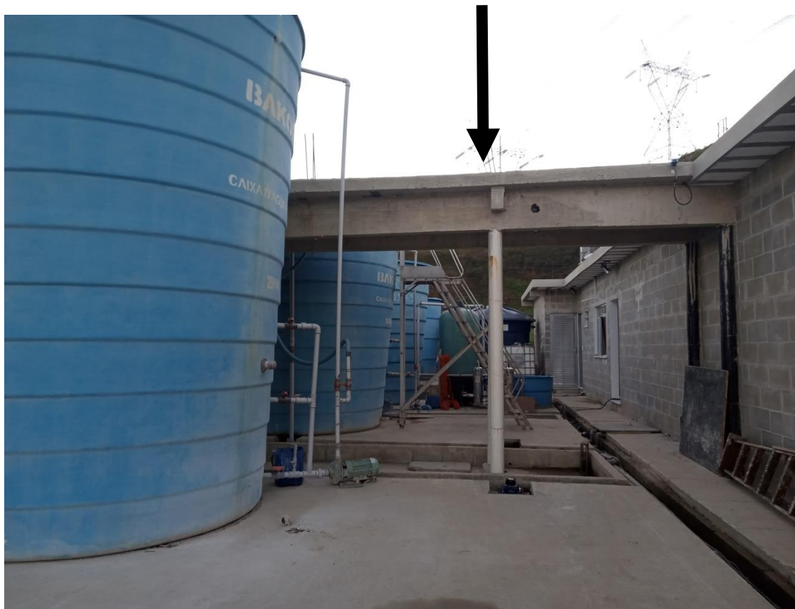
Figura 17 : Tanques da estação de tratamento com o acesso aéreo aos tanques já finalizado.
