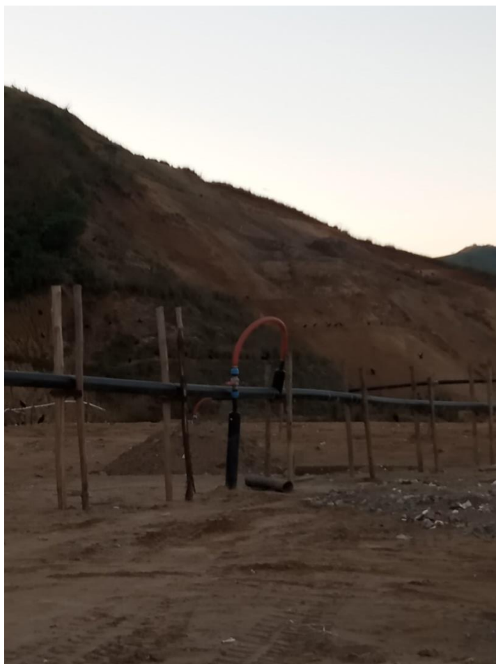
Figura 10 : Dutos de captação de gás
