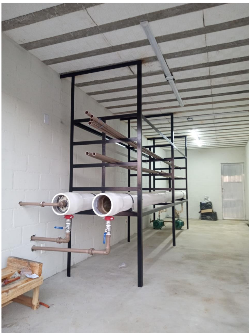
Figura 15: Novo local construído em alvenaria para a instalação e abrigo do equipamento de osmose reversa .
