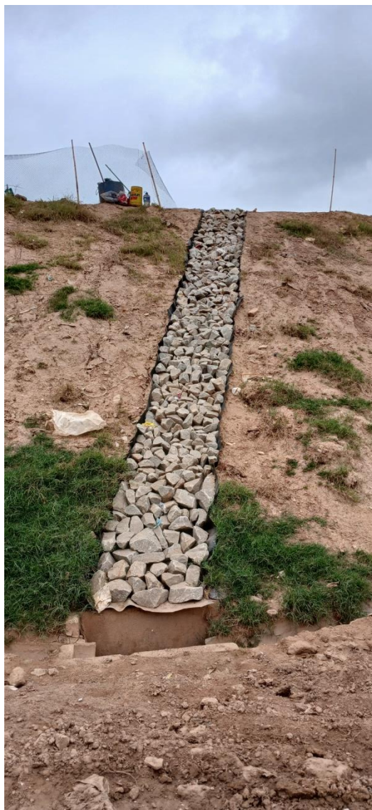
Figura 19: Sistema de drenagem no detalhe
