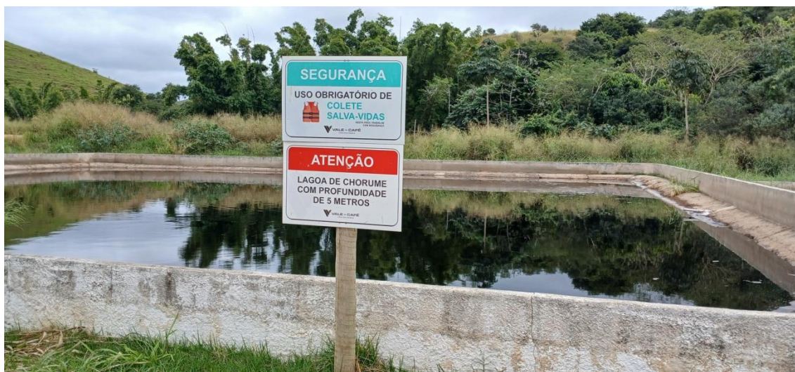
Figura 28: Lagoa de armazenamento de chorume
