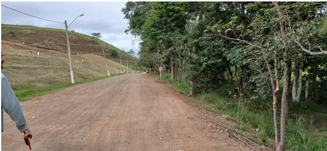
Figura 8: Via interna do CTDR
