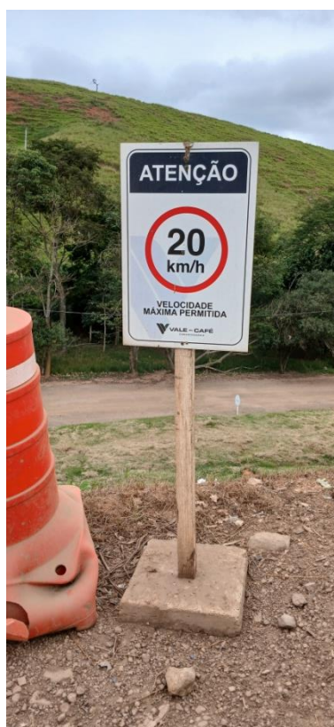
Figura 13: Sinalização da Estrada de acesso à frente de trabalho
