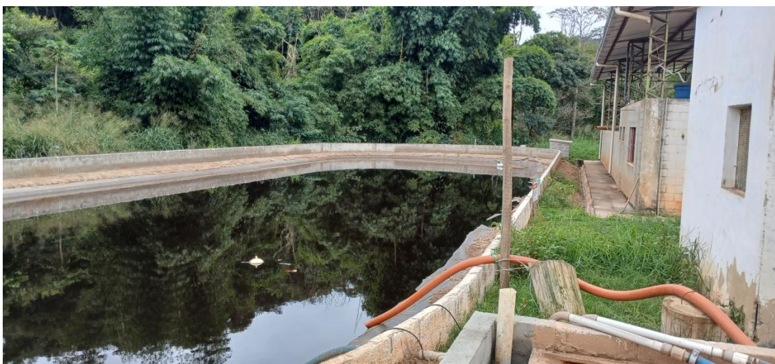
Figura 26: Lagoa de armazenamento de chorume
