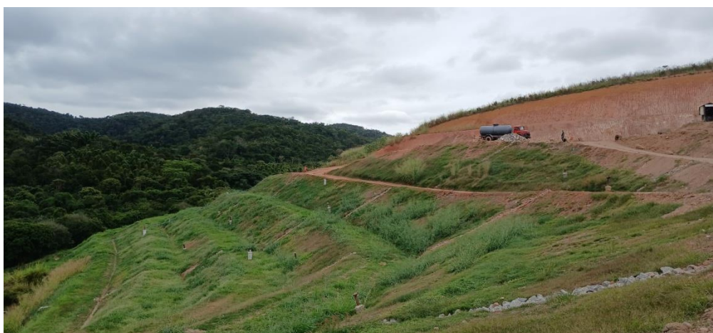
Figura 21: Maciço com recomposição vegetal
