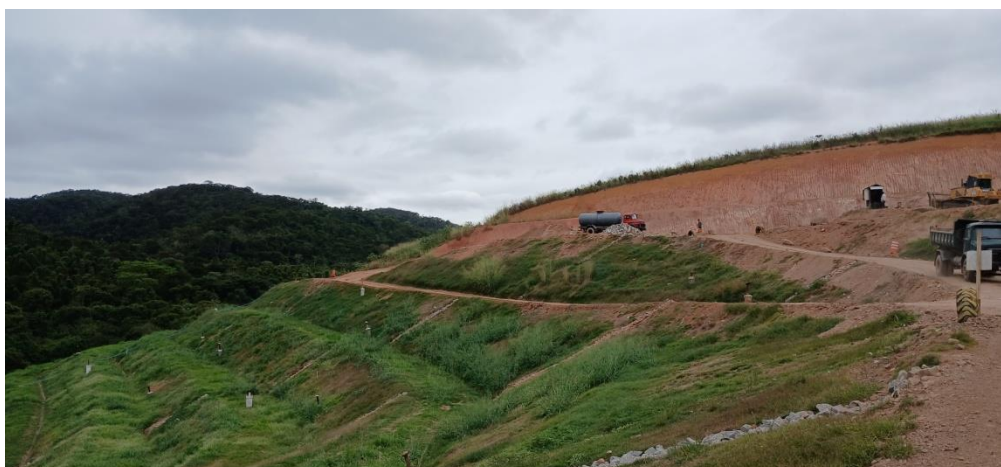
Figura 20: Maciço com recomposição vegetal
