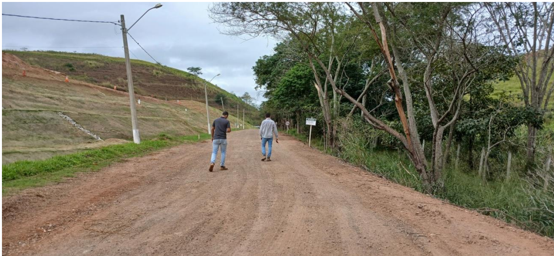
Figura 7: Via interna do CTDR
