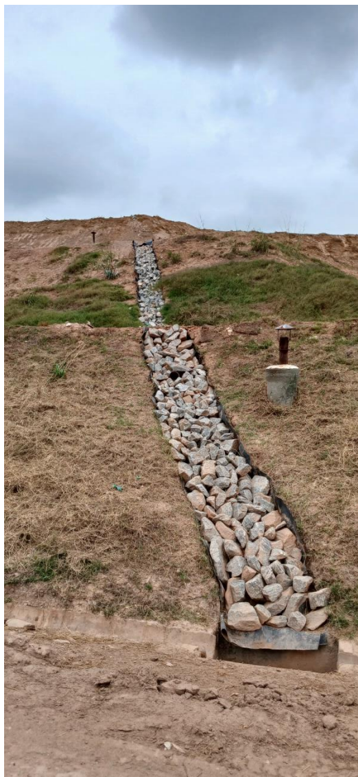
Figura 18 :Sistema de drenagem e cobertura vegetal
