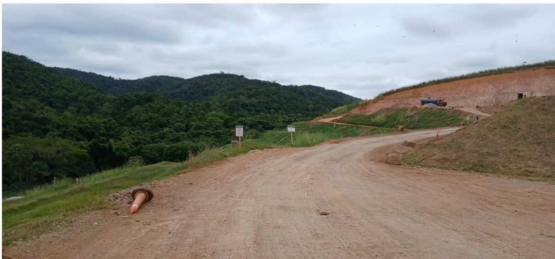
Figura 16: Estrada de acesso à frente de trabalho
