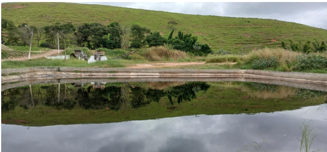
Figura 27: Lagoa de armazenamento de chorume
