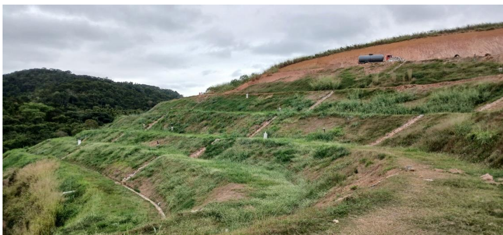
Figura 22: Maciço com recomposição vegetal
