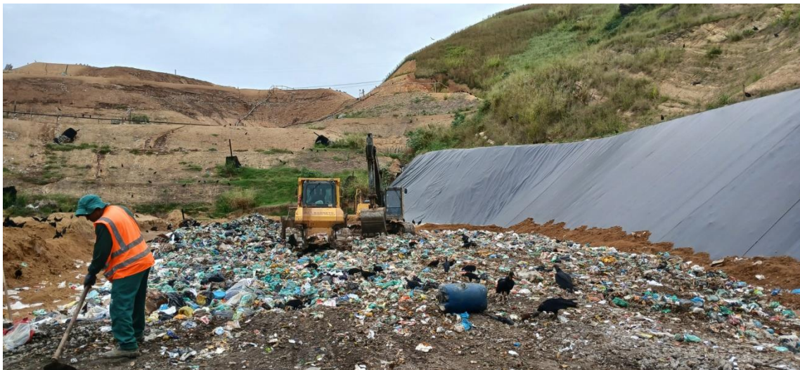
Figura 16: Início da operação na nova frente de trabalho, no detalhe a Geo membrana ( Presença de grande número de aves pois no momento da vistoria o recobrimento dos resíduos estava sendo iniciado)
