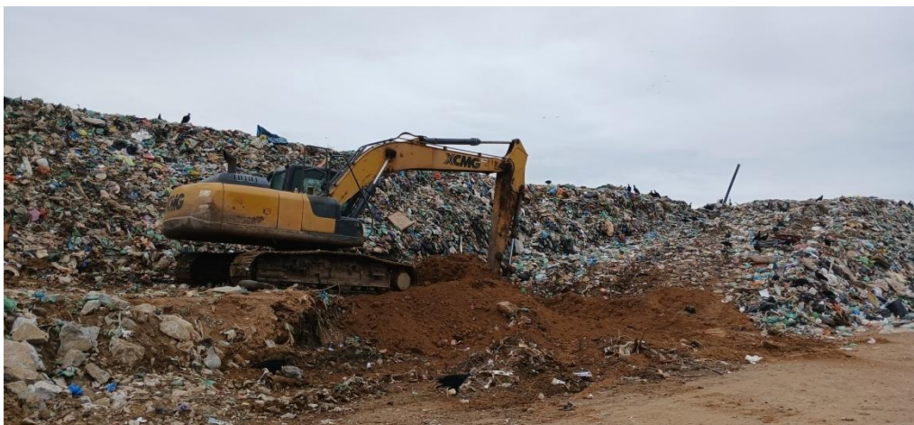
Figura 7: Frente de trabalho atual sendo encerrada
