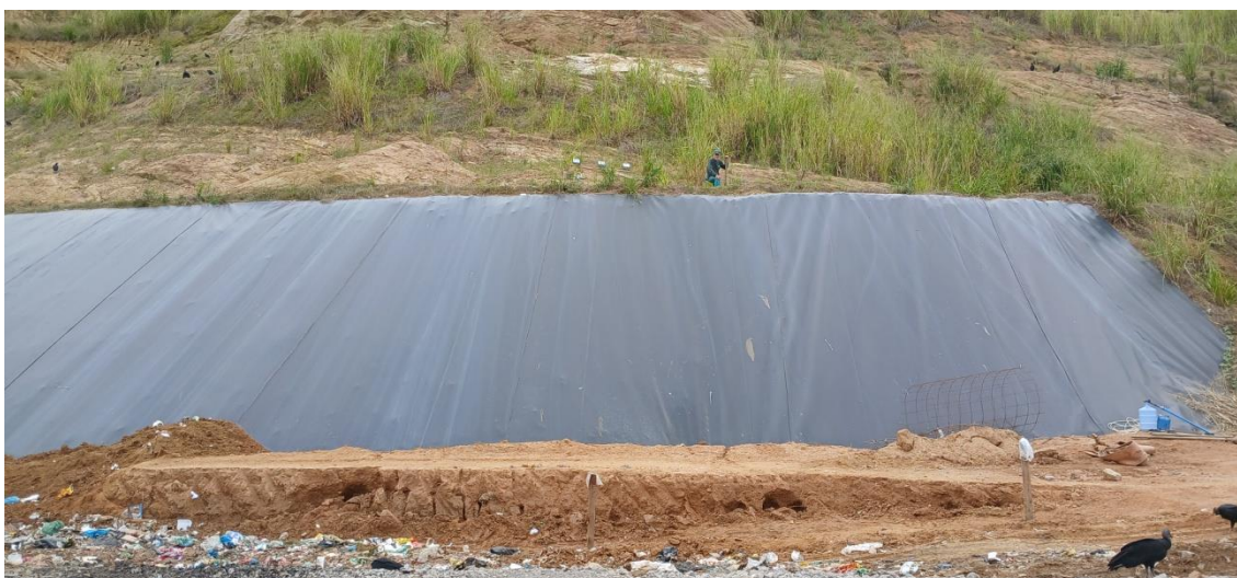
Figura 14: Início da operação na nova frente de trabalho, no detalhe a Geo membrana
