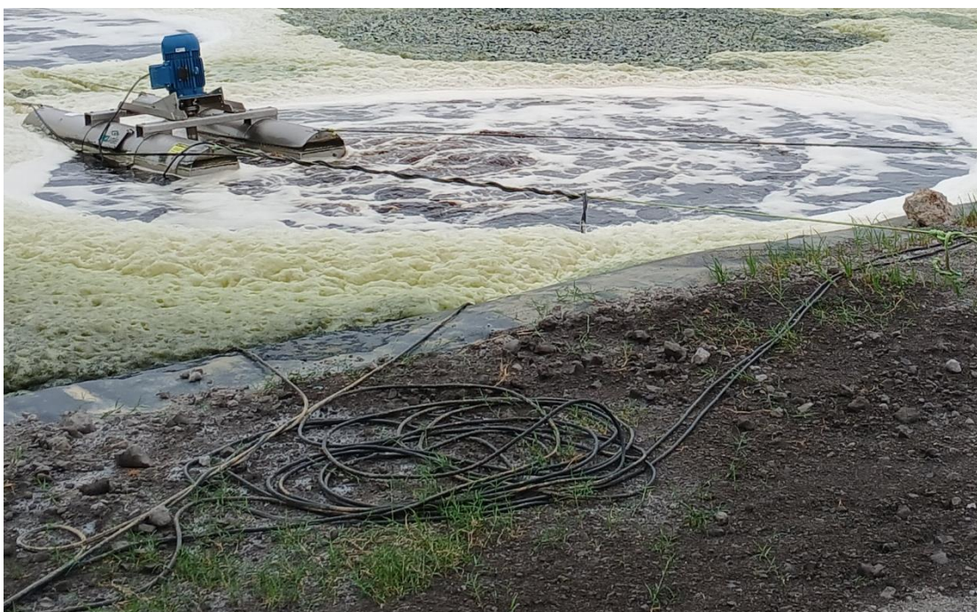
Figura 28: Lagoa secundária de recebimento de chorume e no detalhe o aerador
