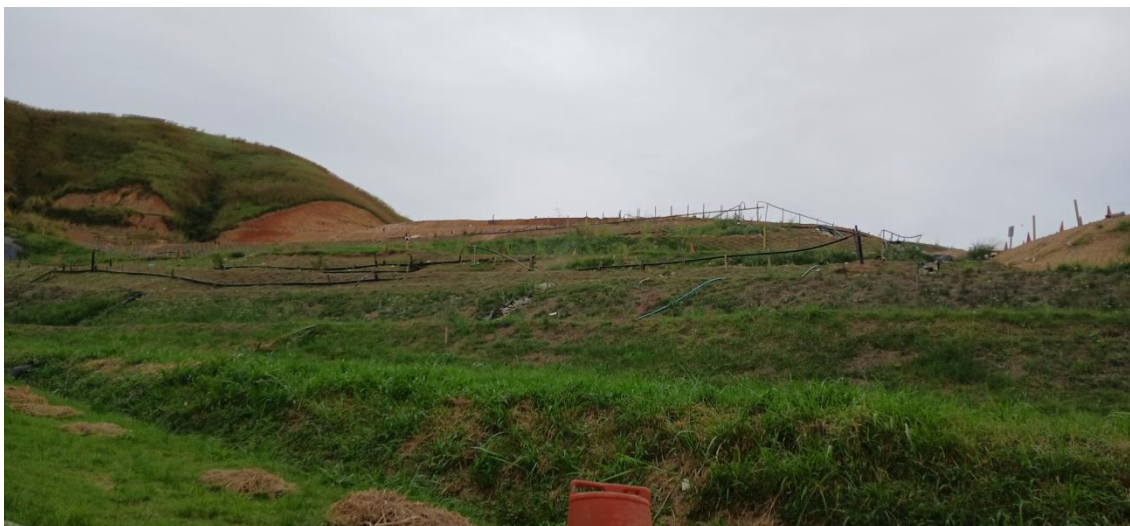
Figura 20: Dutos de captação de gás e cobertura vegetal do maciço.
