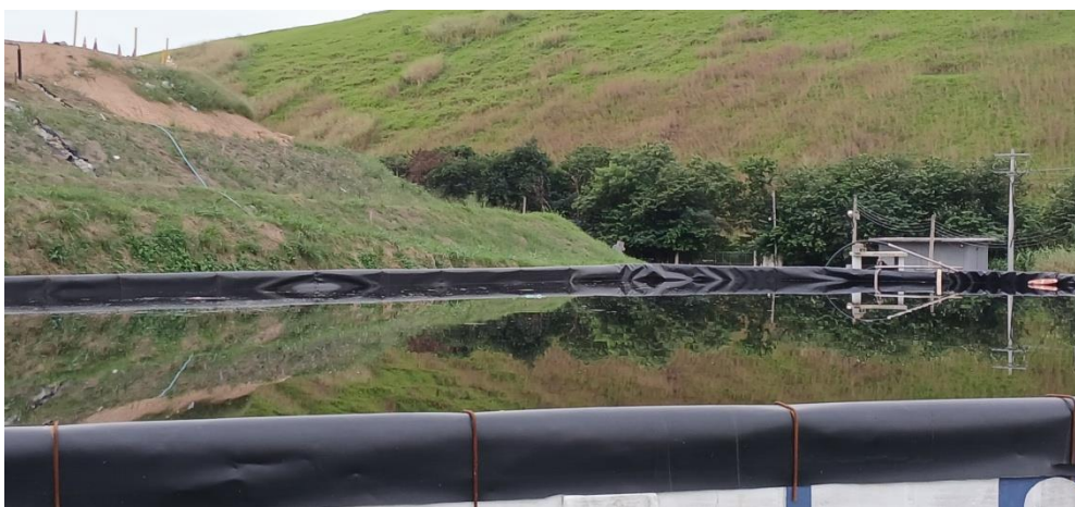
Figura 21: Lagoa principal de recebimento de chorume
