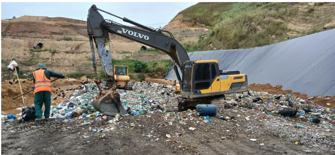
Figura 18: Início da operação na nova frente de trabalho , retroescavadeira recobrindo os resíduos anteriormente compactados
