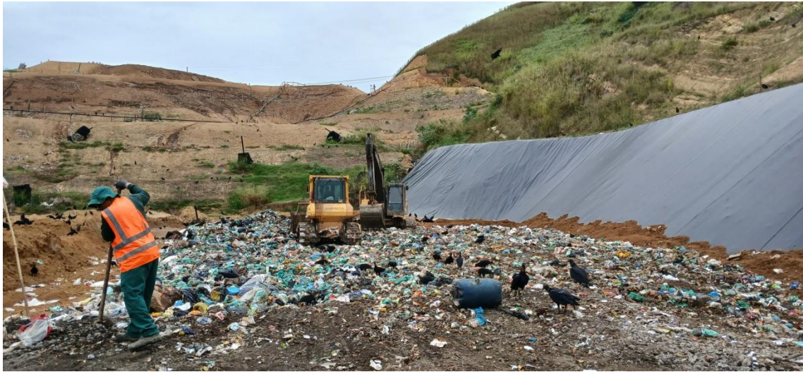
Figura 15: Início da operação na nova frente de trabalho, no detalhe a Geo membrana ( Presença de grande número de aves pois no momento da vistoria o recobrimento dos resíduos estava sendo iniciado)
