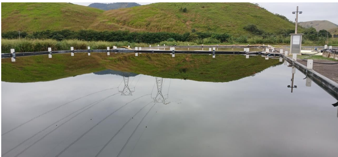
Figura 22: Lagoa secundária de recebimento de chorume
