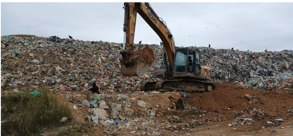
Figura 9: Frente de trabalho atual sendo encerrada
