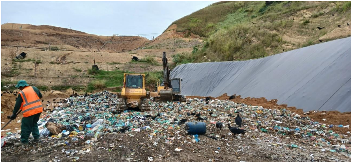
Figura 17: Início da operação na nova frente de trabalho , retroescavadeira compactando os resíduos para posterior recobrimento.
