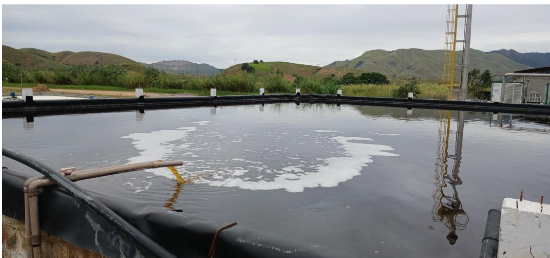
Figura 23: Lagoa secundária de recebimento de chorume
