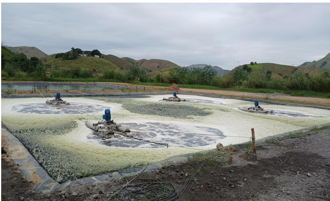
Figura 27: Lagoa secundária de recebimento de chorume com 4 aeradores em funcionamento
