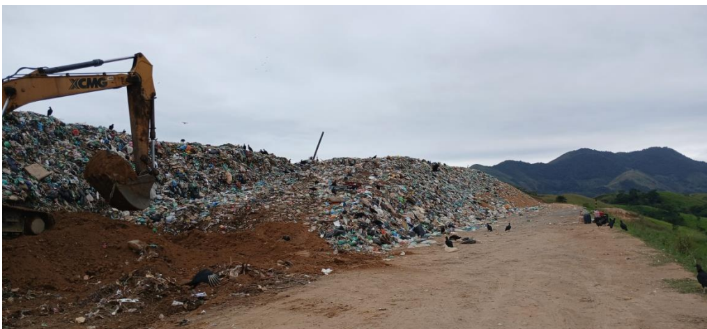
Figura 8: Frente de trabalho atual sendo encerrada
