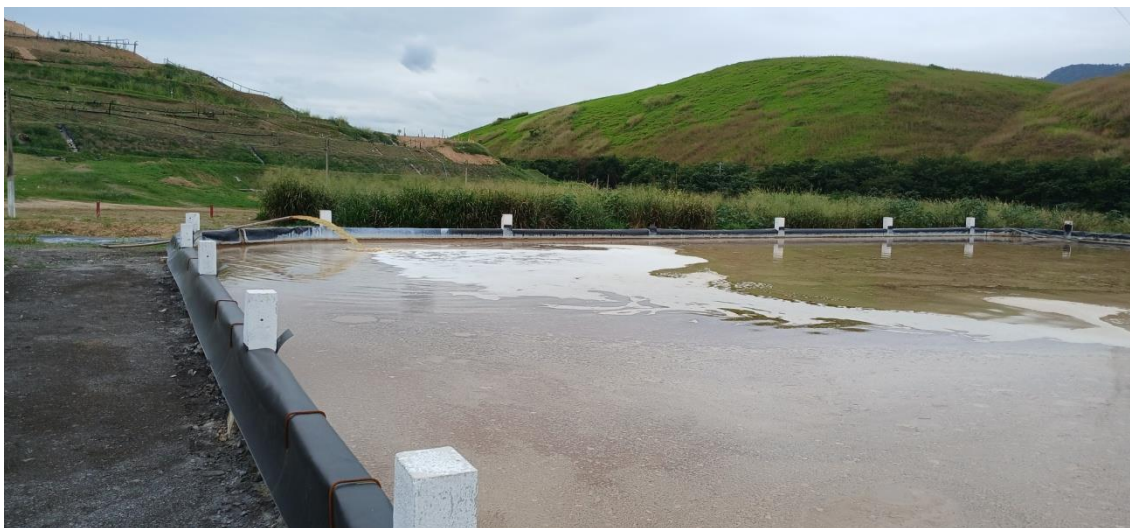
Figura 25: Lagoa secundária de recebimento de chorume
