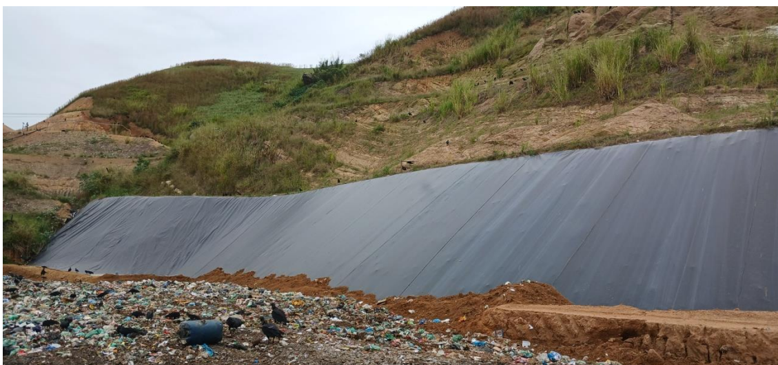
Figura 13: Início da operação na nova frente de trabalho, no detalhe a Geo membrana
