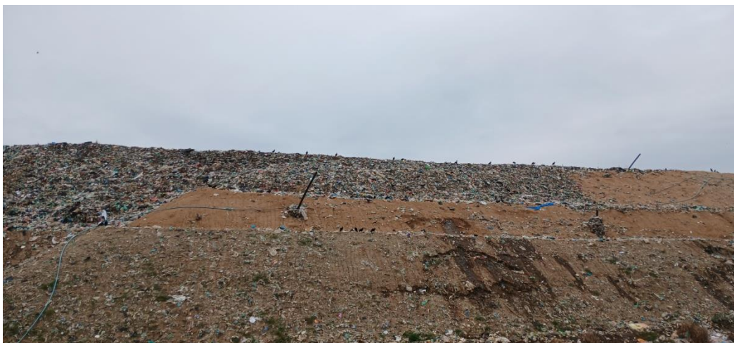
Figura 11: Frente de trabalho atual sendo encerrada
