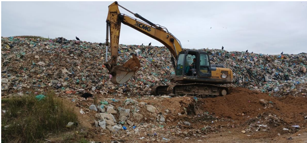
Figura 10: Frente de trabalho atual sendo encerrada
