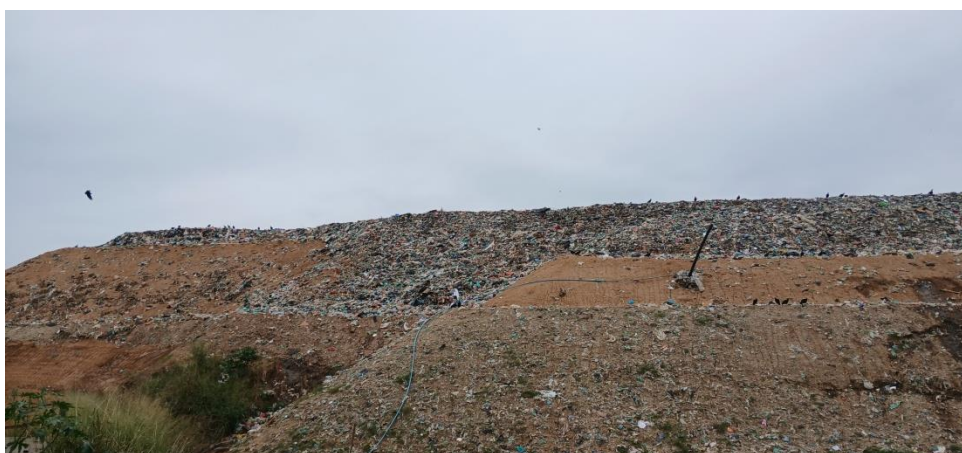
Figura 12: Frente de trabalho atual sendo encerrada
