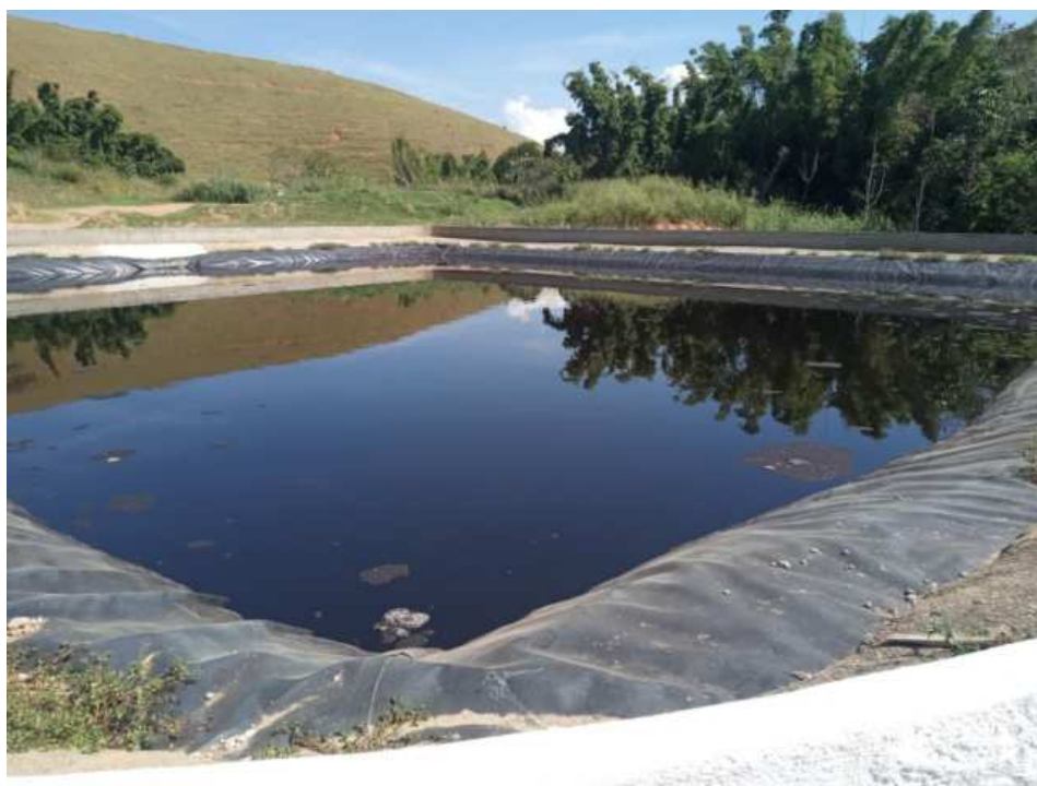
Figura 14: Lagoa de recebimento e armazenagem de chorume
