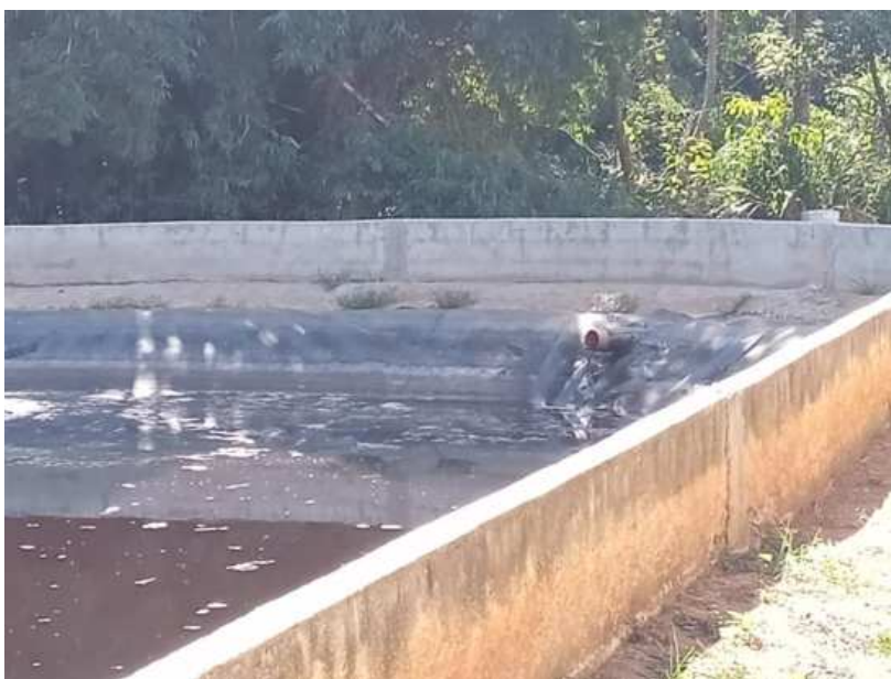
Figura 13: Lagoa de recebimento e armazenagem de chorume
