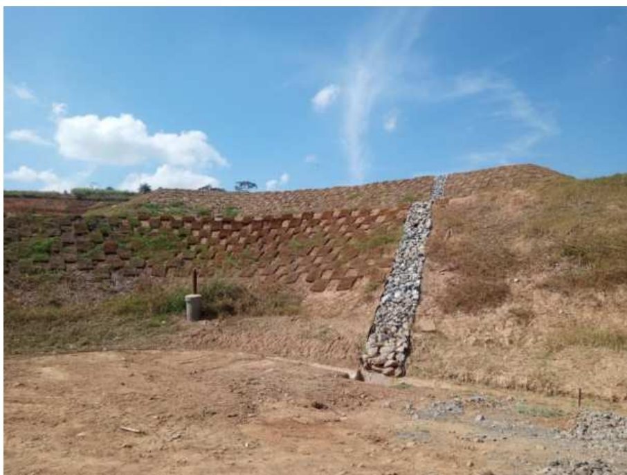
Figura 10: Cobertura vegetal e sistema de drenagem
