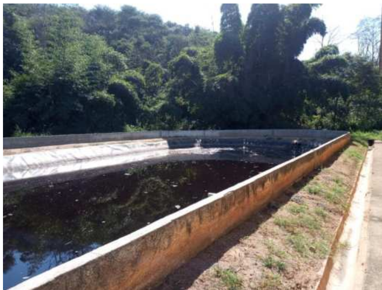
Figura 12: Lagoa de recebimento e armazenagem de chorume
