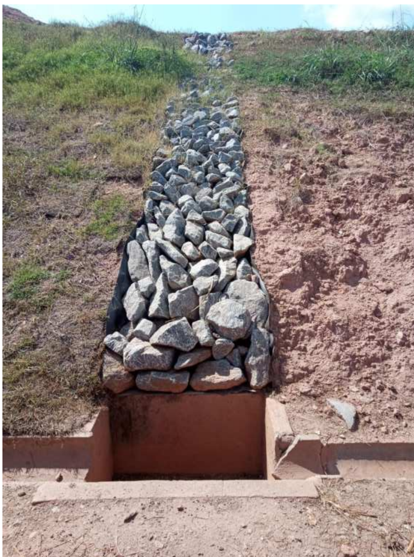
Figura 9: Detalhe do sistema de drenagem
