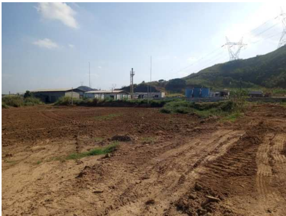
Figura 20 : Início das obras para ampliação do tratamento
