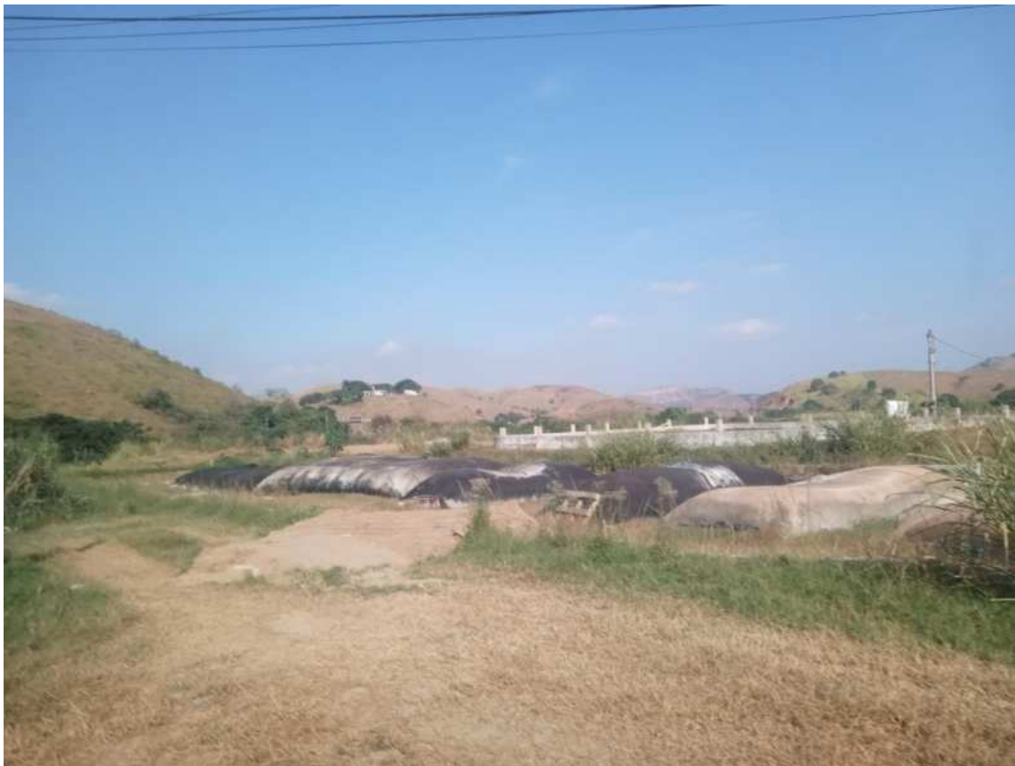
Figura 19 : Ecobags de secagem do lodo
