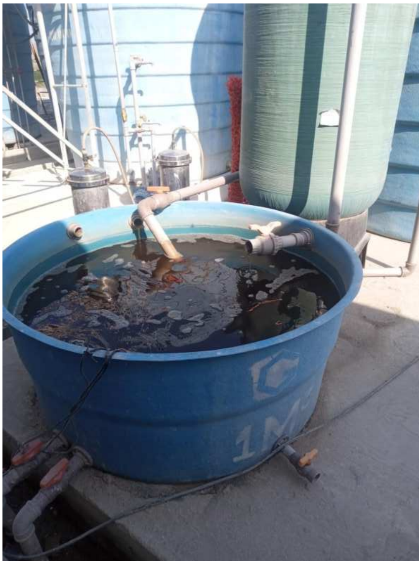
Figura 17 : Detalhe processo de tratamento osmose reversa
