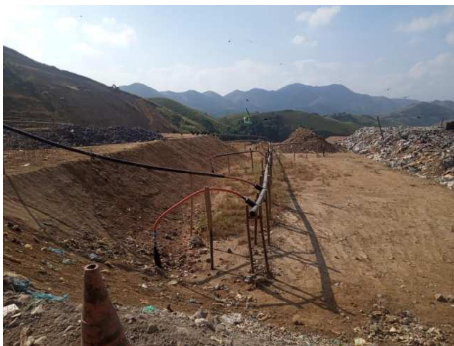
Figura 7: Frente de trabalho e no detalhe tubulação de captação de gás
