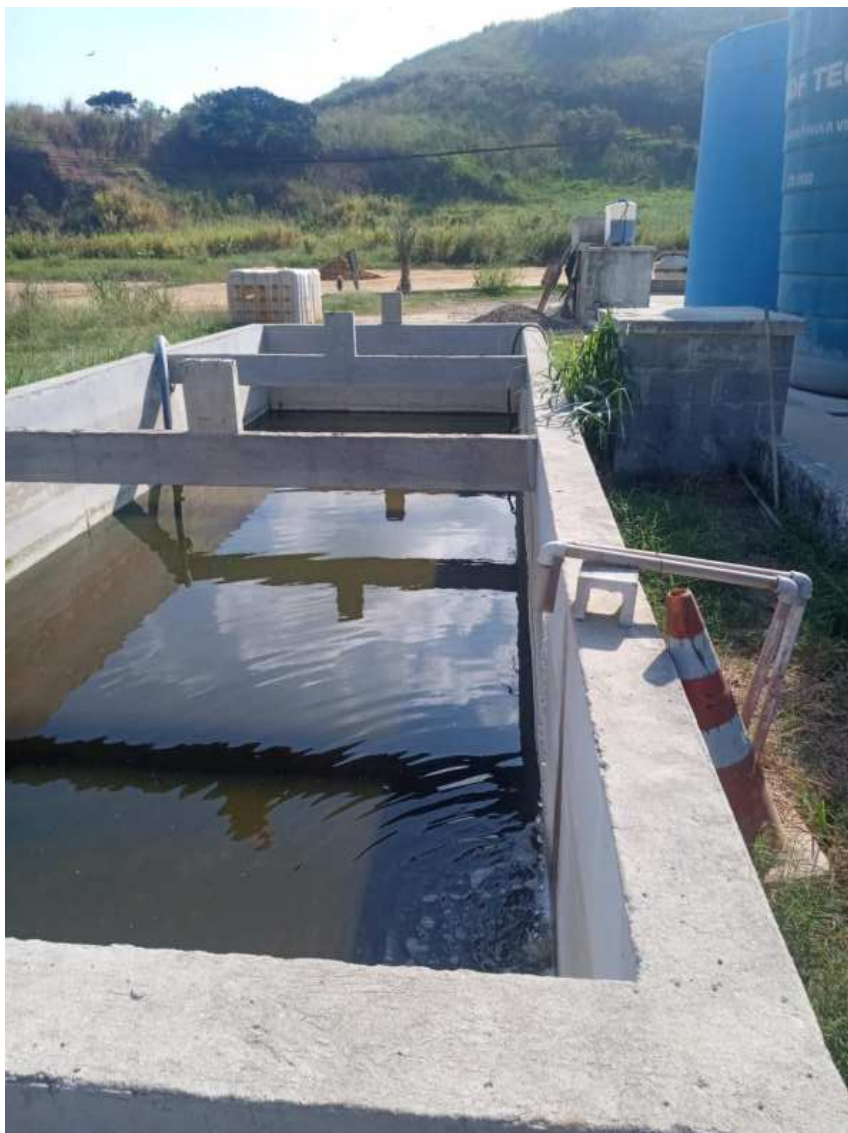
Figura 18 : Tanque de recebimento de água de reuso após tratamento
