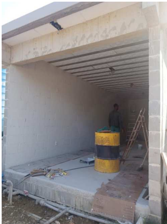
Figura 16 : Construção para armazenar o equipamento de osmose reversa
