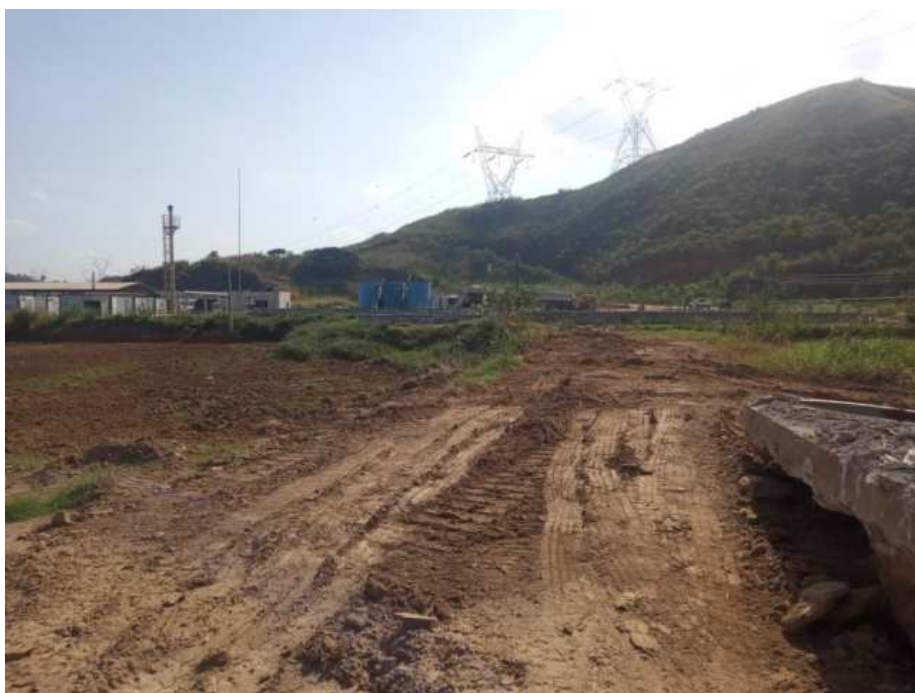
Figura 21 : Início das obras para ampliação do tratamento
