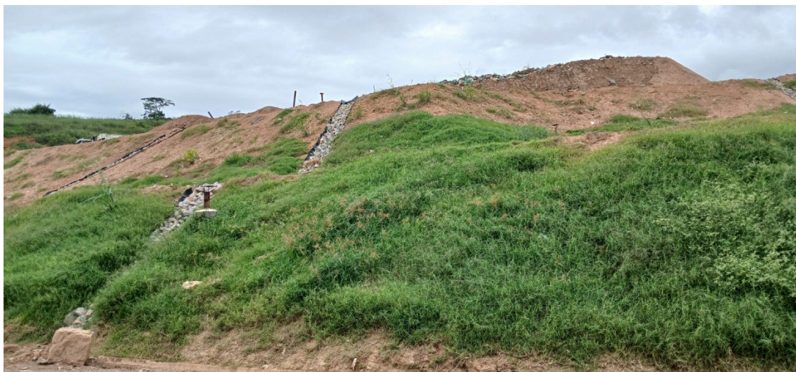
Figura 16 :Sistema de drenagem e cobertura vegetal
