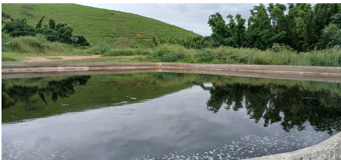
Figura 24: Lagoa de armazenamento de chorume
