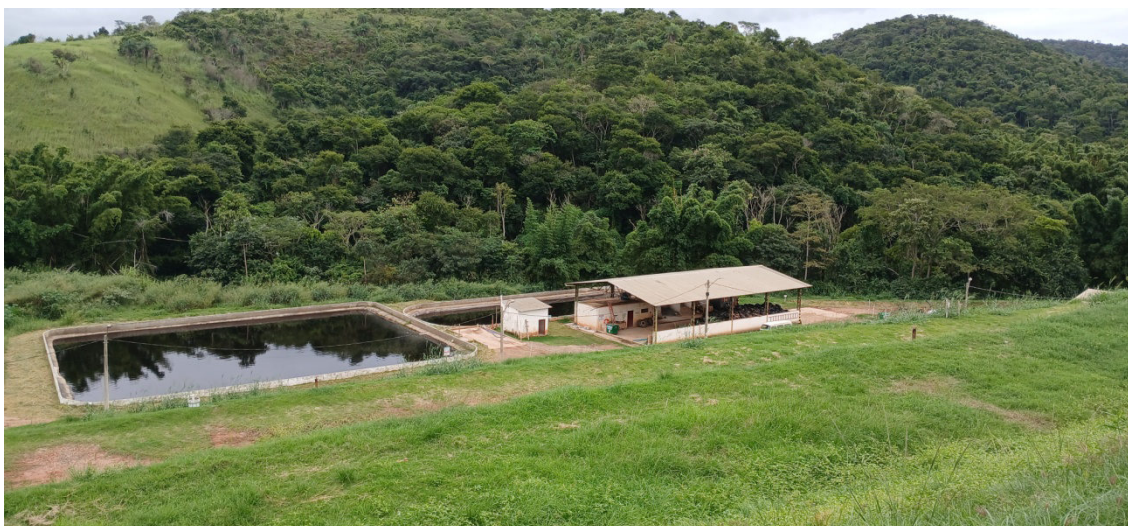
Figura 22: Vista aérea das lagoas de armazenamento de chorume
