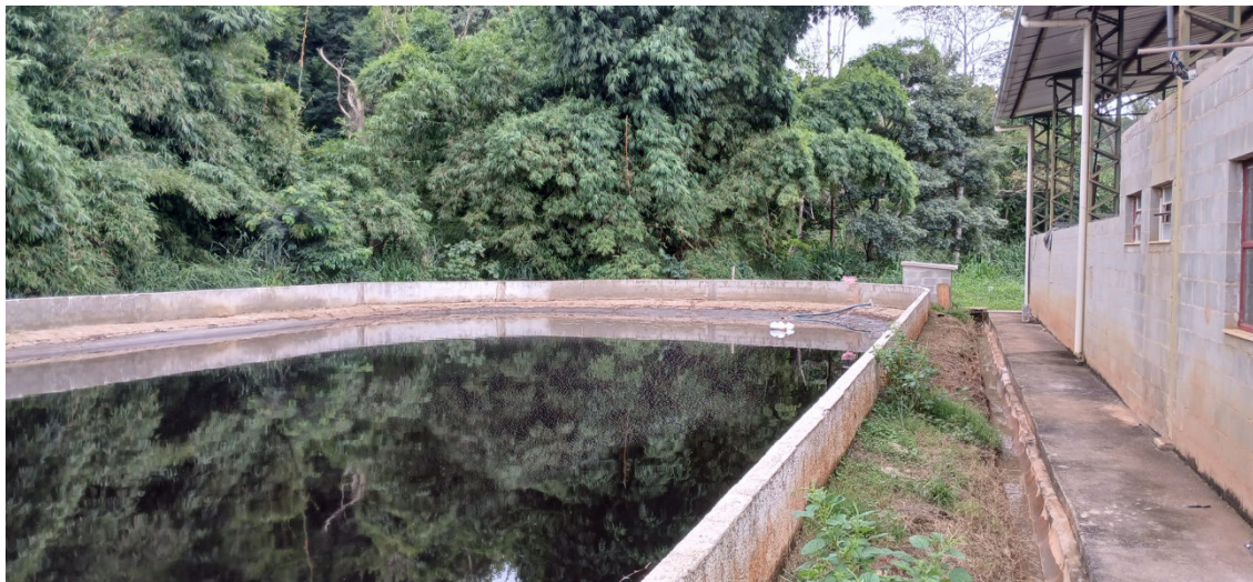
Figura 23: Lagoa de armazenamento de chorume
