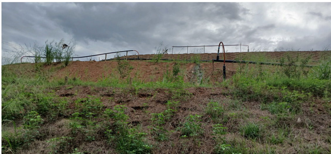
Figura 11: Dutos de captação de gás
