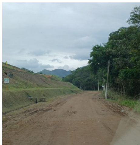
Figura 8: Estrada de acesso a frente de trabalho
