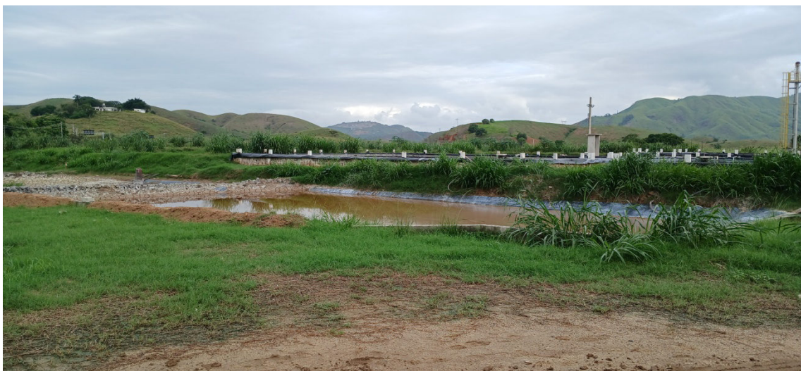
Figura 14: Leito de secagem do lodo
