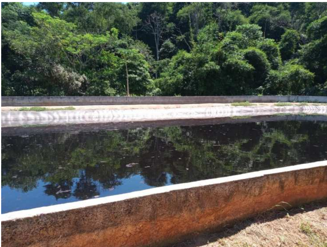
Figura 14: Lagoa de recebimento e armazenagem de chorume
