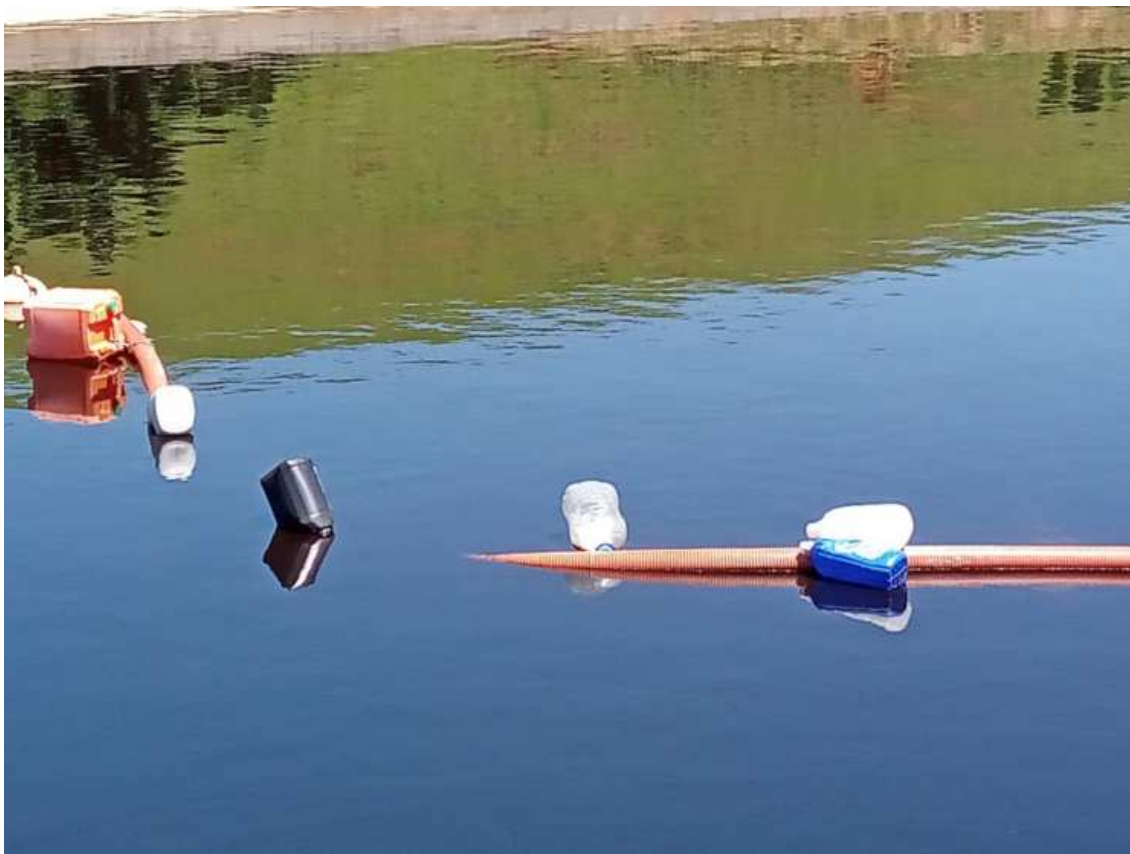
Figura 16: Lagoa de recebimento e armazenagem de chorume
