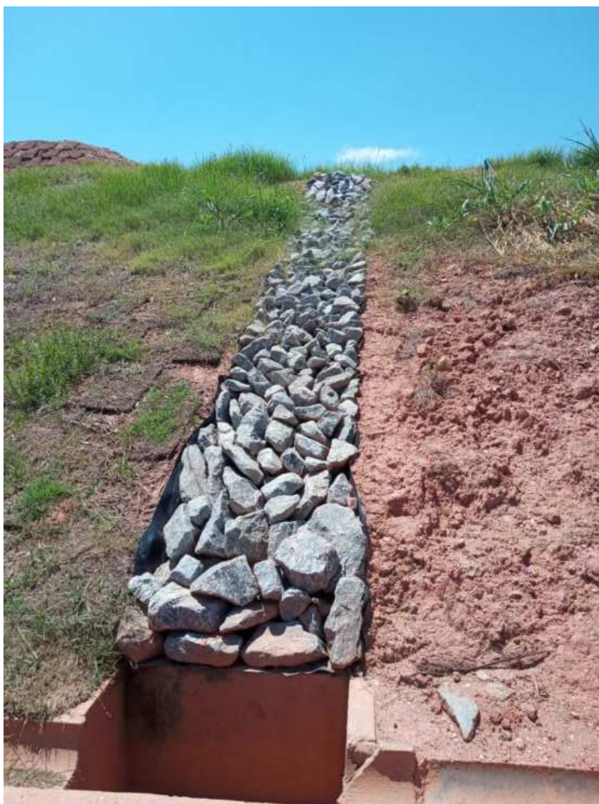
Figura 10: Detalhe do sistema de drenagem
