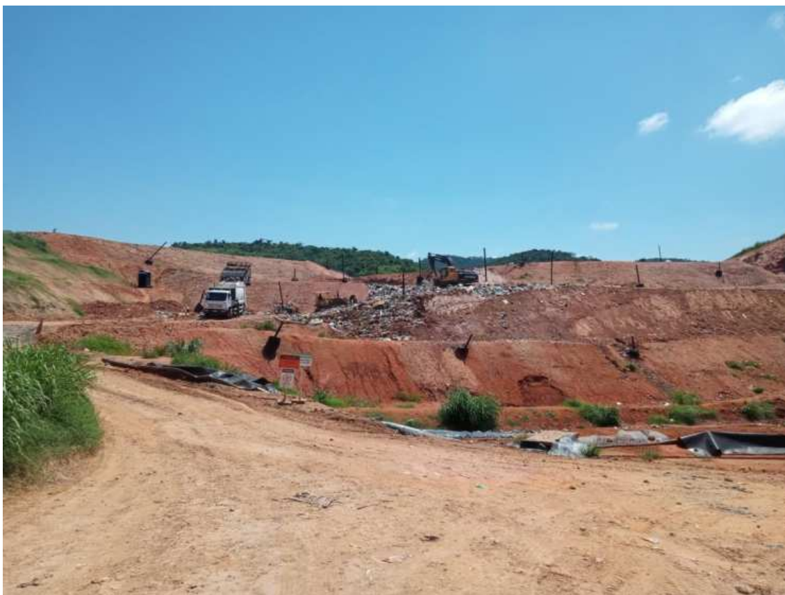
Figura 4: Preparação da nova célula e ao fundo a frente de trabalho
