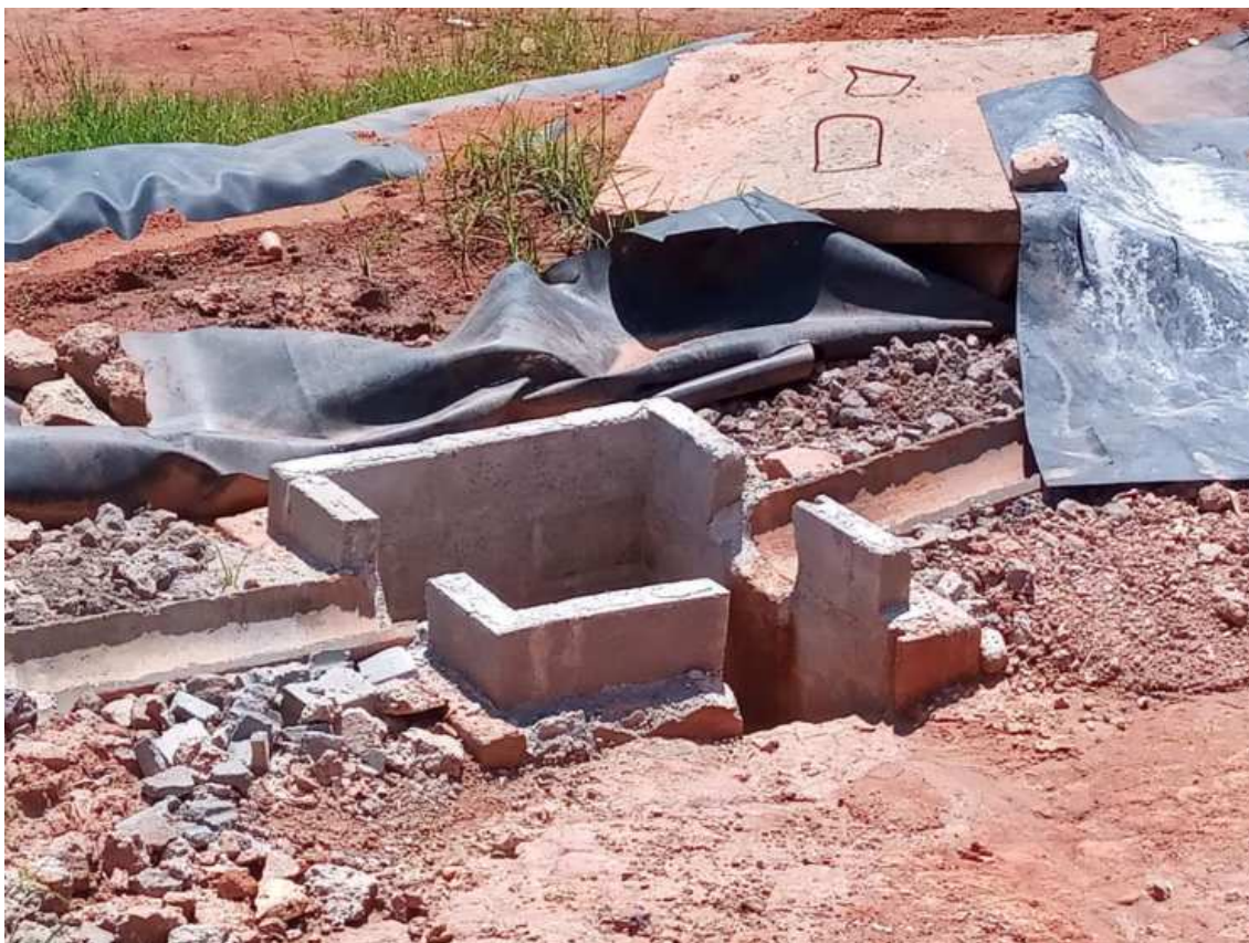
Figura 6: Preparação da nova célula . Detalhe da drenagem e Geomembrana
