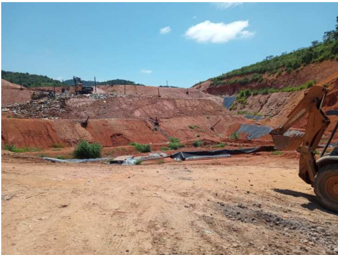
Figura 3: Preparação da nova célula
