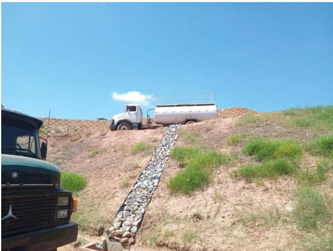
Figura 11: Detalhe do sistema de drenagem
