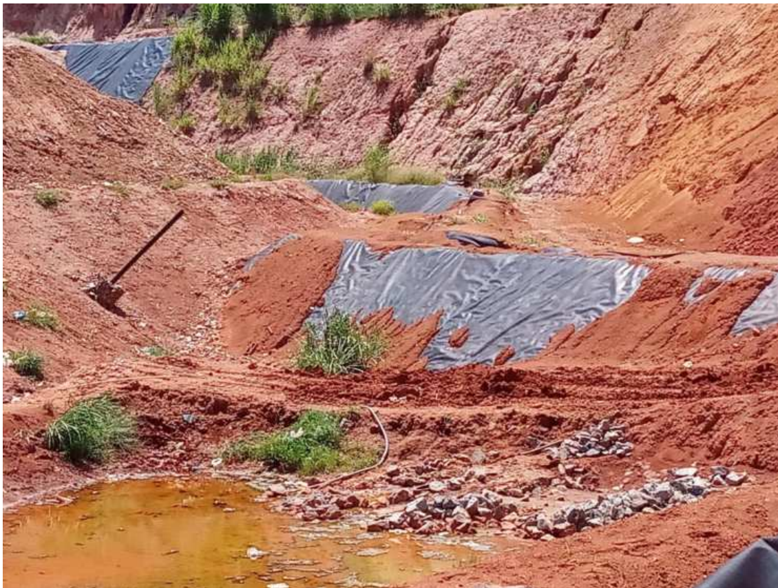
Figura 5: Preparação da nova célula . Detalhe da drenagem e Geomembrana
