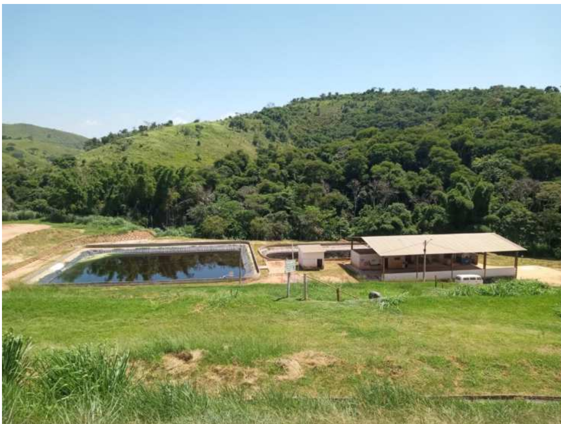
Figura 13: Vista das lagoas de acumulação de chorume
