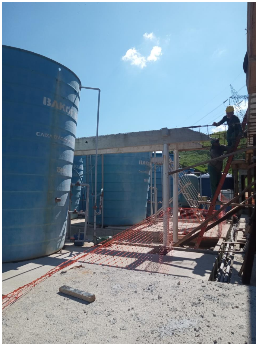
Figura 12 : Construção de acesso aéreo aos tanques de tratamento
