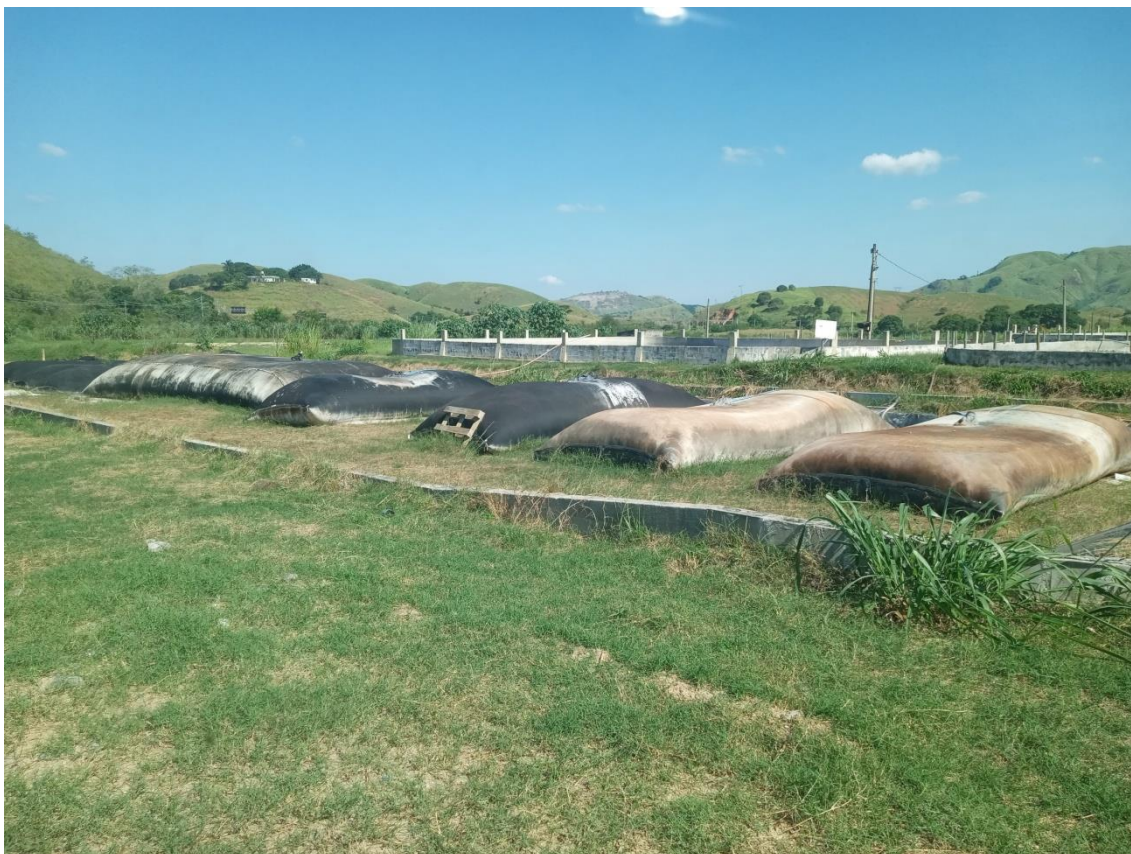
Figura 15 : Ecobags de secagem do lodo
