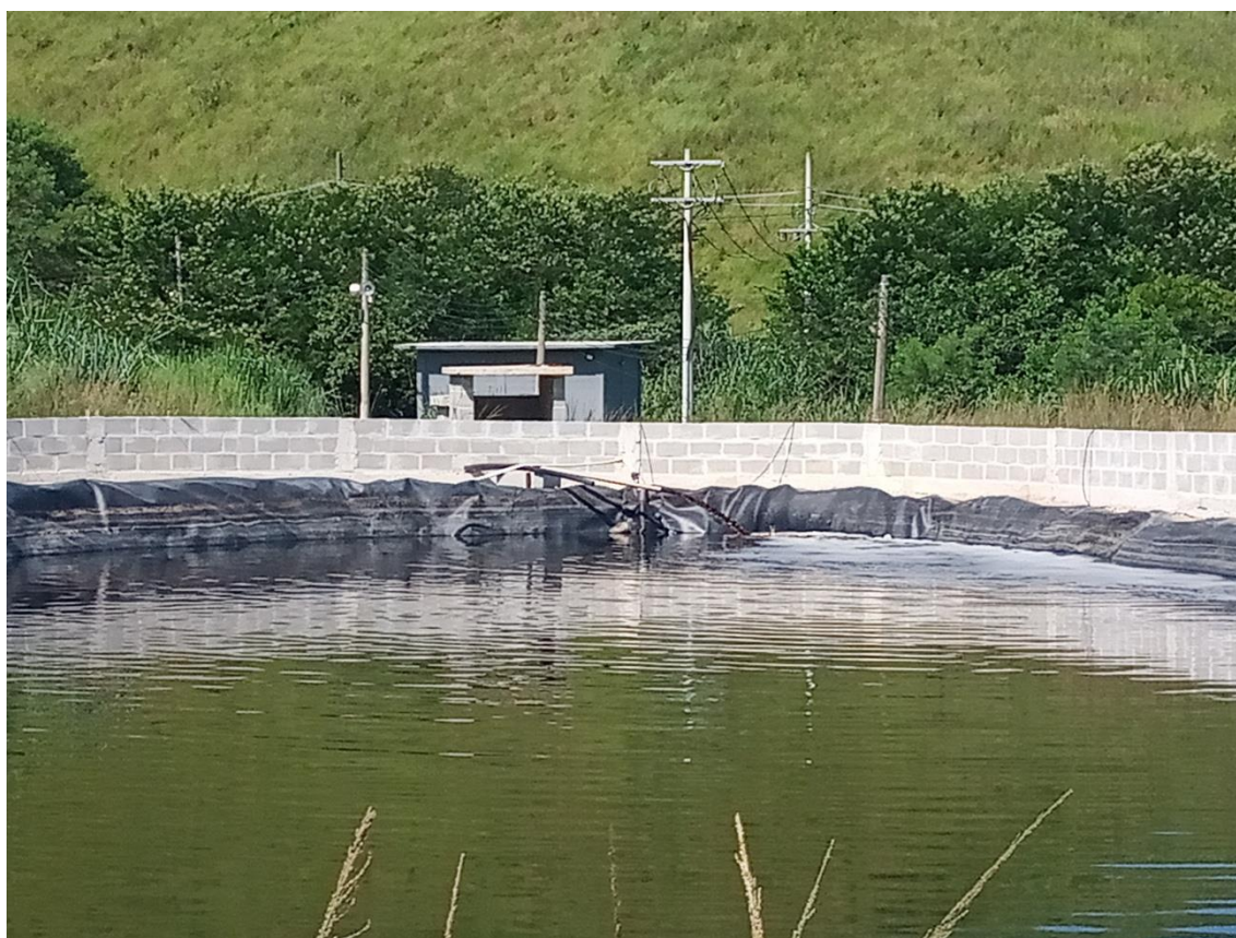
Figura 7: Lagoa principal de recebimento de chorume
