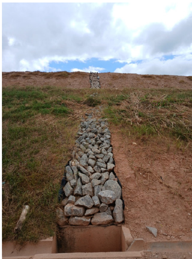
Figura 9: Sistema de drenagem
