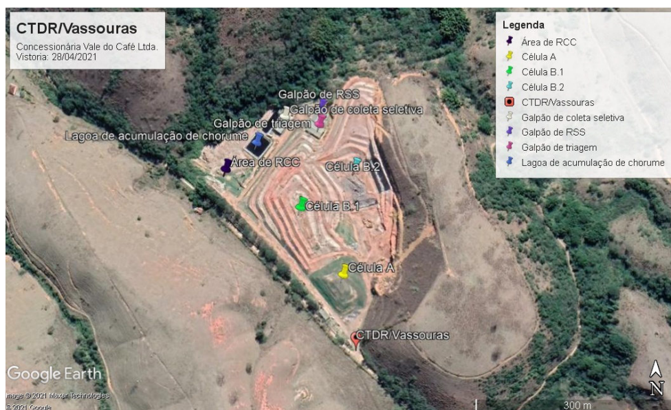
Figura 1: Vista aérea do CTDR/Vassouras. Fonte: Google Earth, 28/04/2021.
