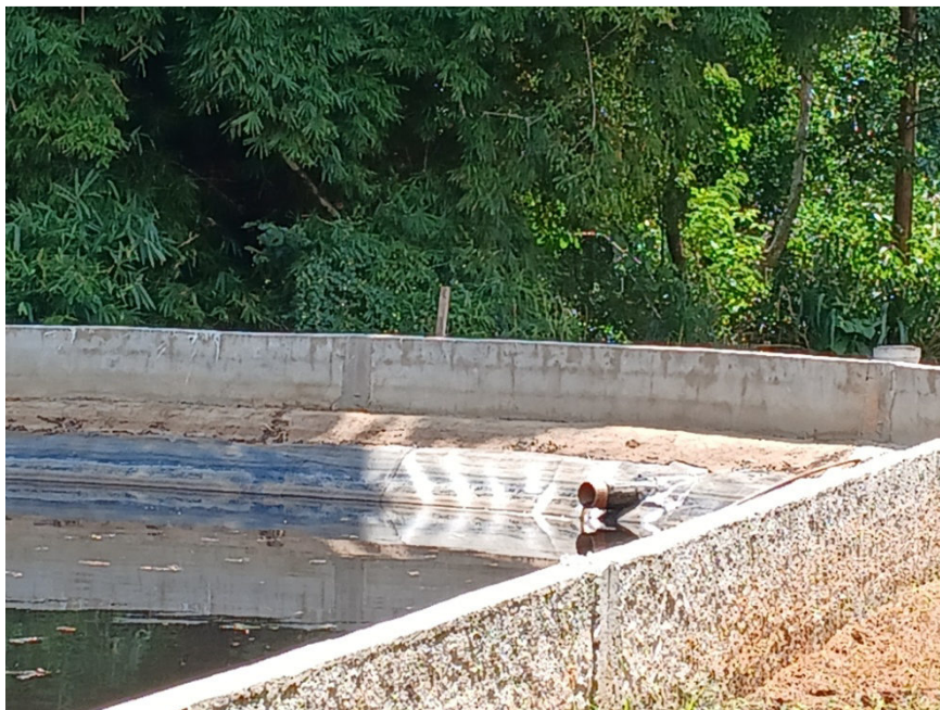
Figura 22: Lagoa de armazenamento de chorume
