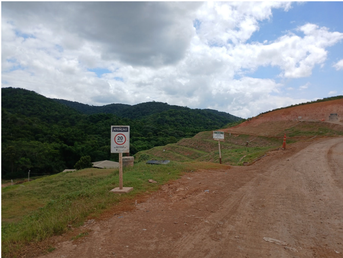
Figura 11: Acesso a frente de trabalho
