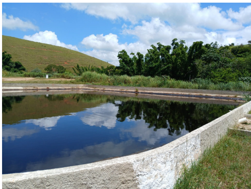
Figura 23: Lagoa de armazenamento de chorume
