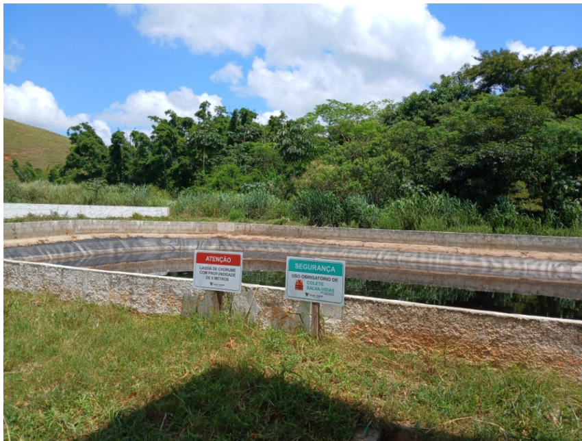
Figura 20: Lagoa de armazenamento de chorume
