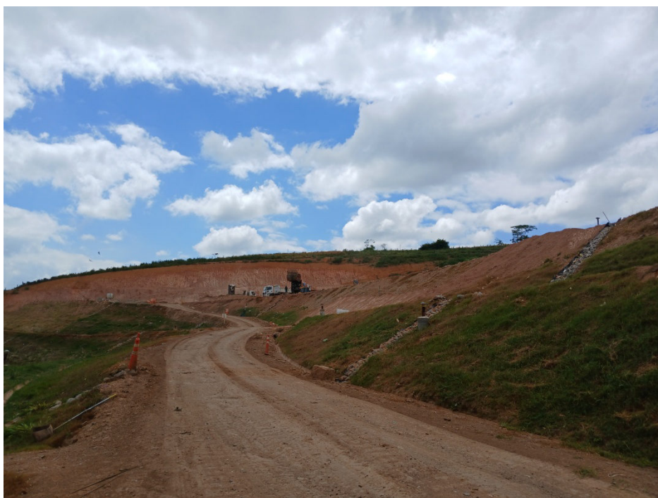
Figura 12: Acesso a frente de trabalho
