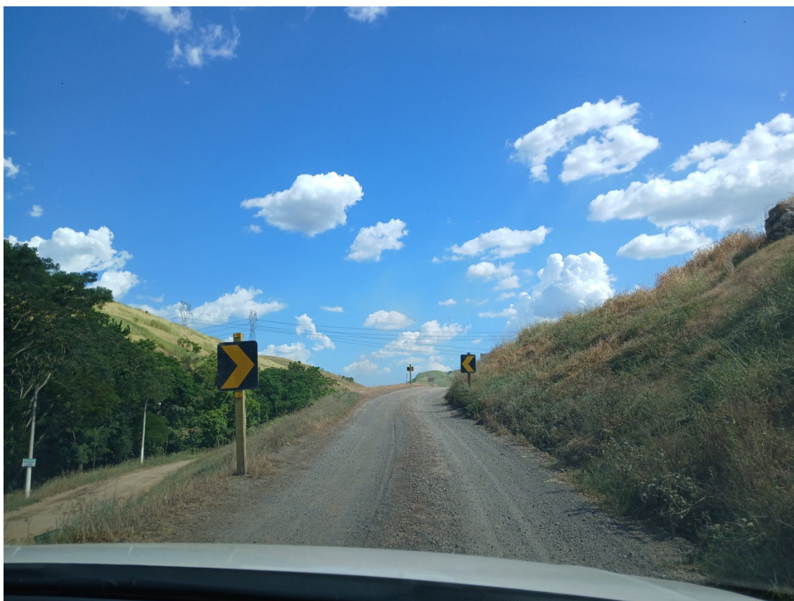
Figura 5: Estrada de acesso a frente de trabalho
