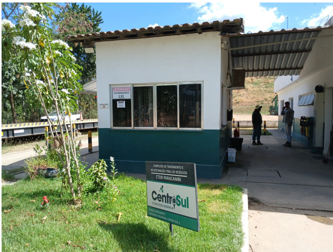
Figura 3: Sala de comando de pesagem
