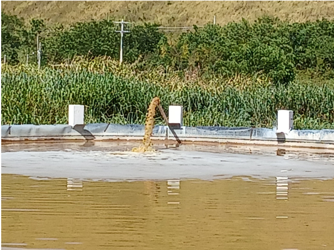
Figura 19: Lagoa de recebimento de chorume
