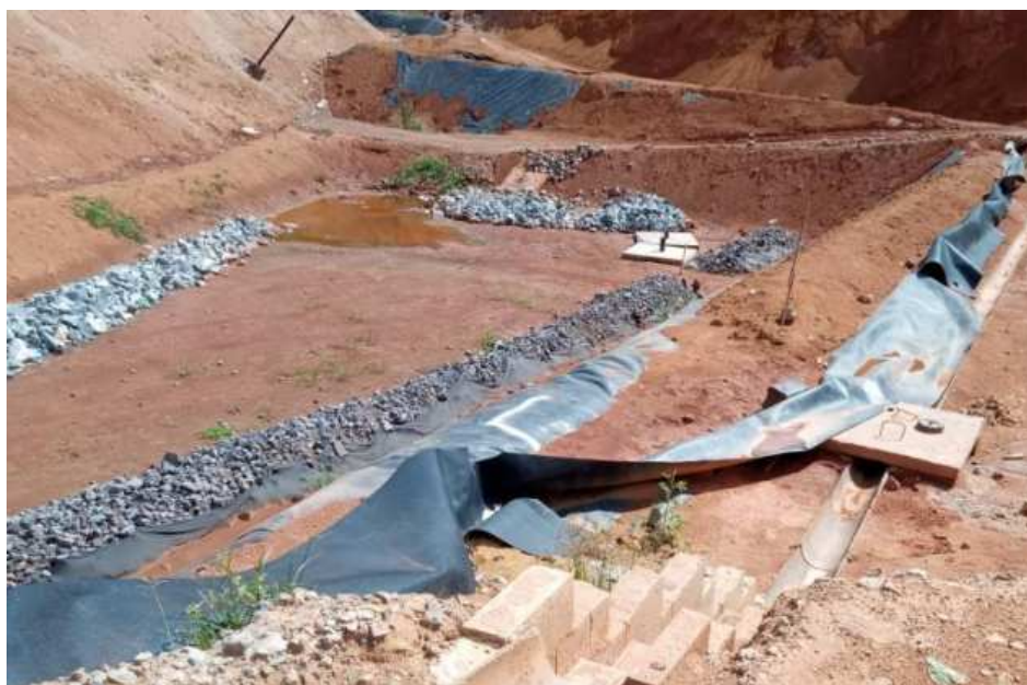
Figura 5: Preparação da nova célula . Detalhe da drenagem e Geomembrana
