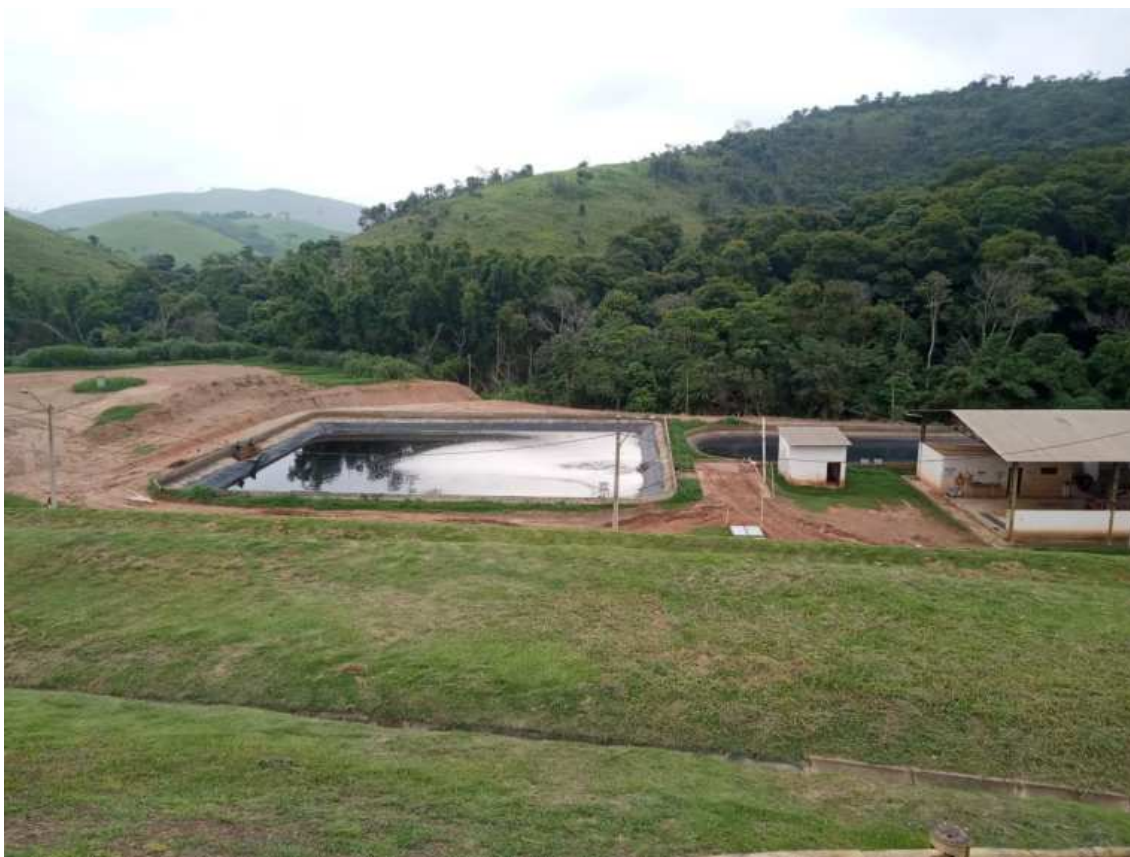
Figura 12: Vista das lagoas de acumulação de chorume
