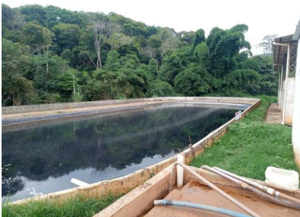
Figura14: Lagoa de recebimento e armazenagem de chorume
