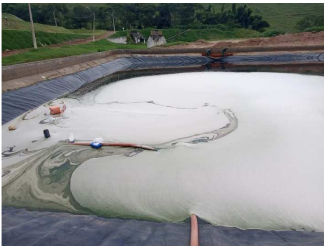
Figura 4: Lagoa de recebimento e armazenagem de chorume
