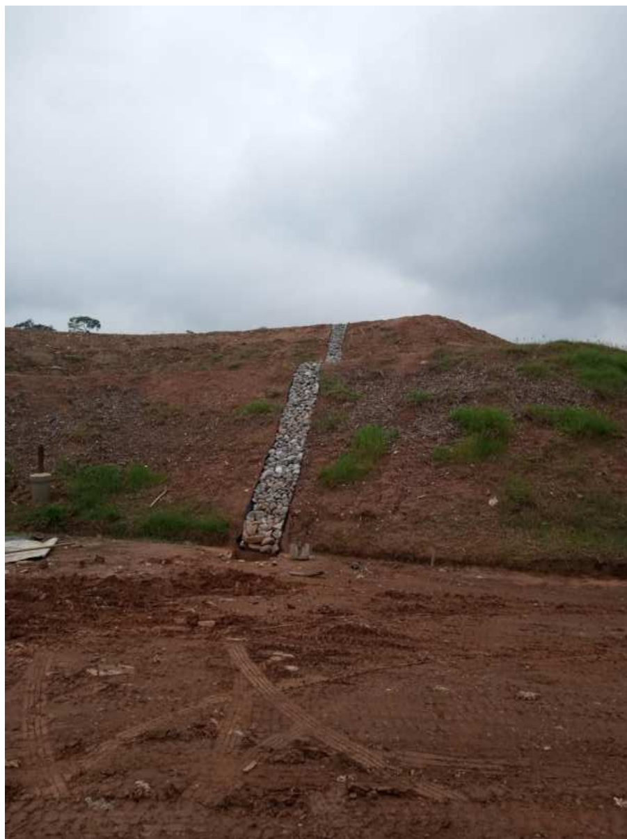
Figura 11: Cobertura vegetal e Drenagem do talude
