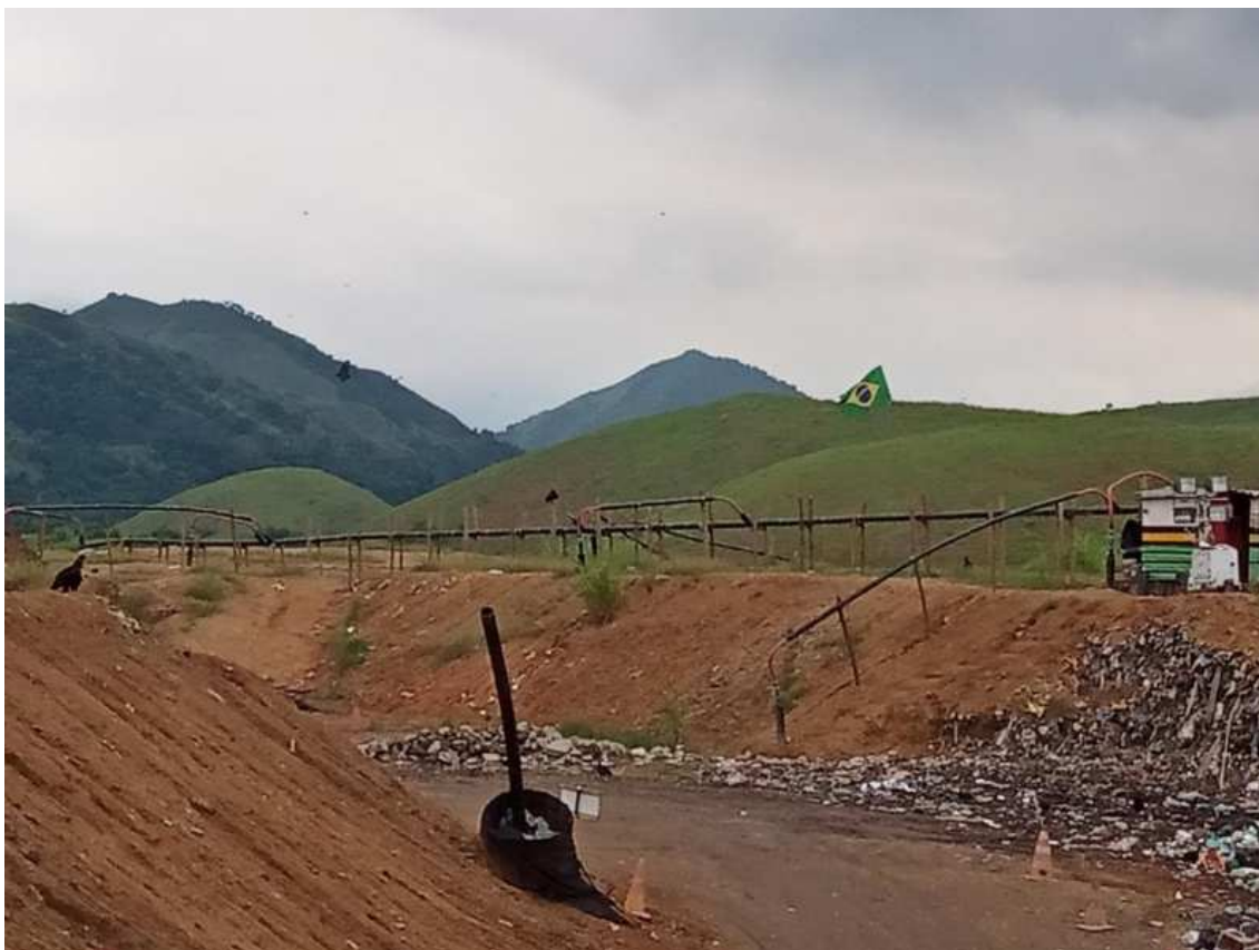
Figura 6: Dutos de captação de gás
