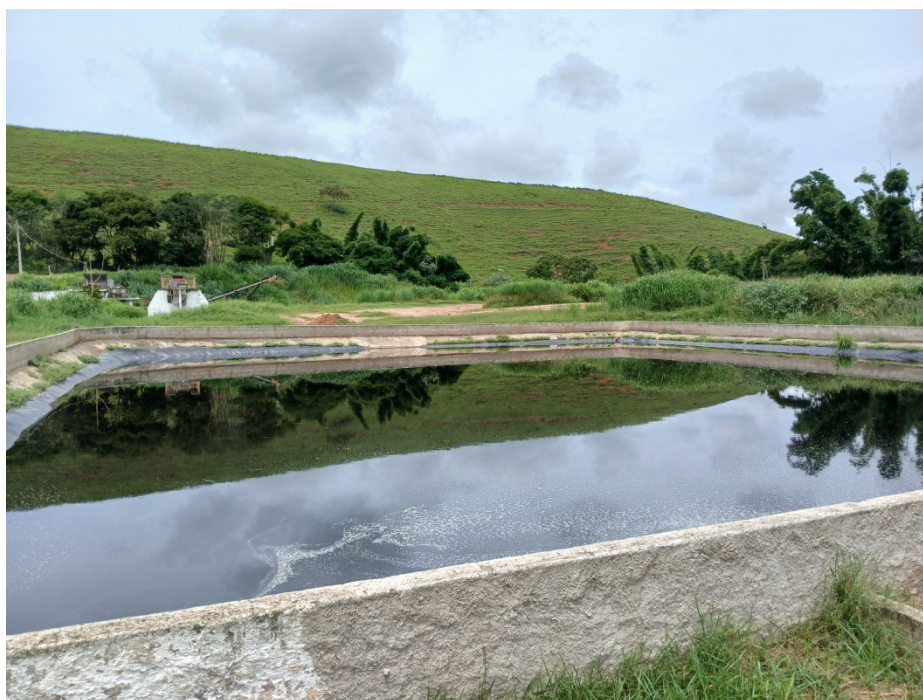
Figura 18: Lagoa de armazenamento de chorume
