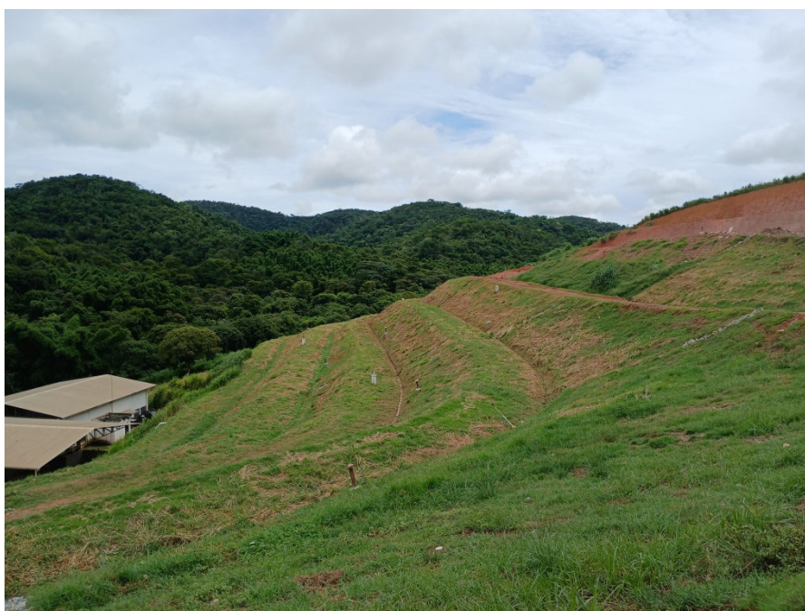
Figura 7: Cobertura vegetal do talude
