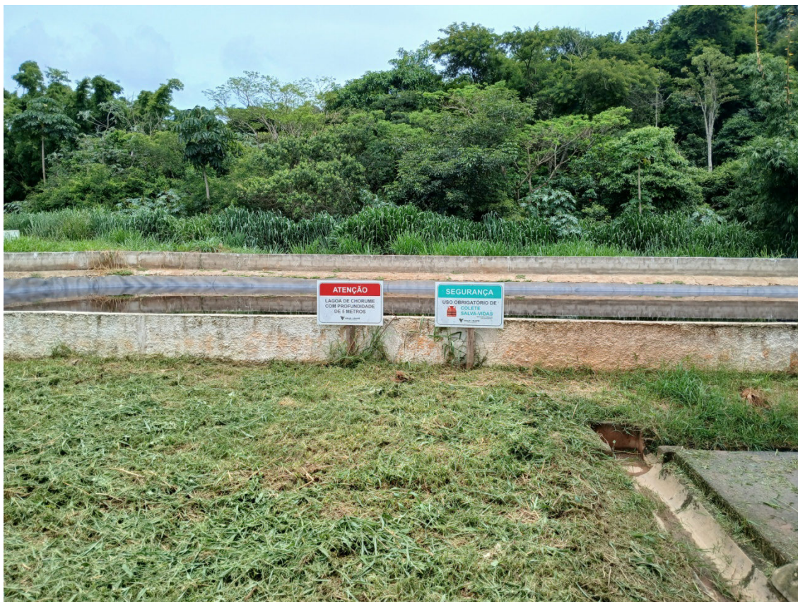
Figura 15: Lagoa de armazenamento de chorume
