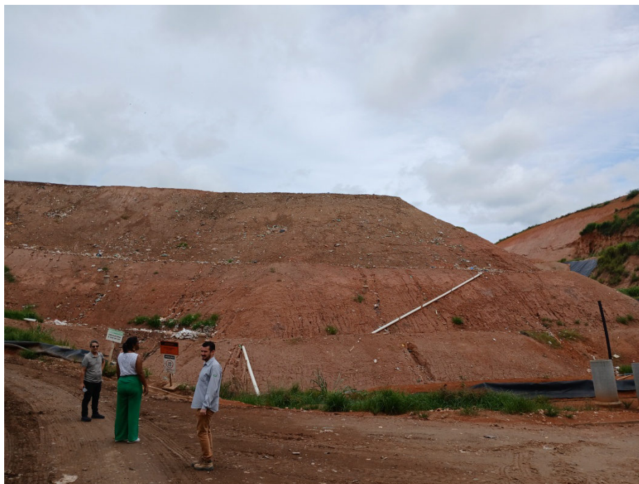
Figura 3: Acesso a Frente de trabalho
