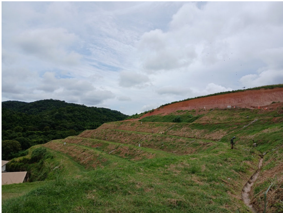
Figura 8: Cobertura vegetal do talude
