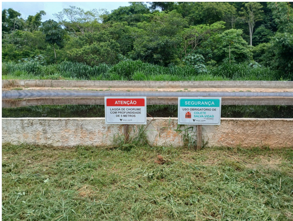
Figura 16: Lagoa de armazenamento de chorume devidamente sinalizada
