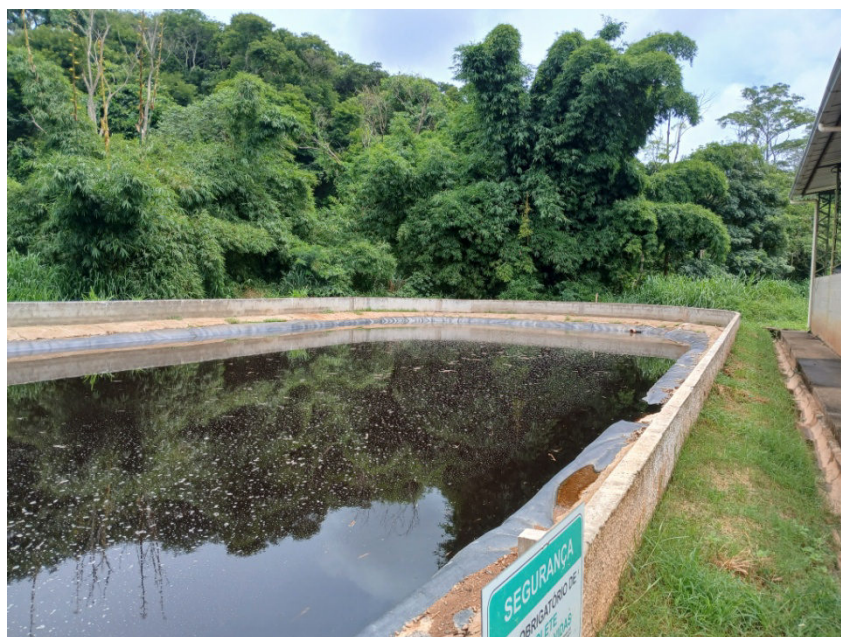
Figura 17: Lagoa de armazenamento de chorume
