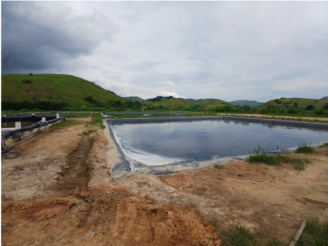
Figura 13: Leito de secagem do lodo
