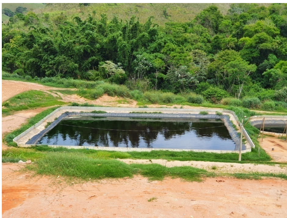
Figura 12: Lagoa de armazenamento de chorume.
