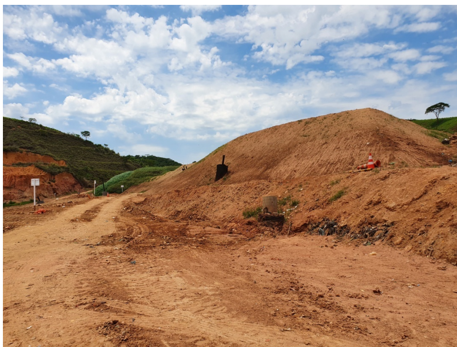
Figura 9: Vista de taludes operados da célula b, setor 1.
