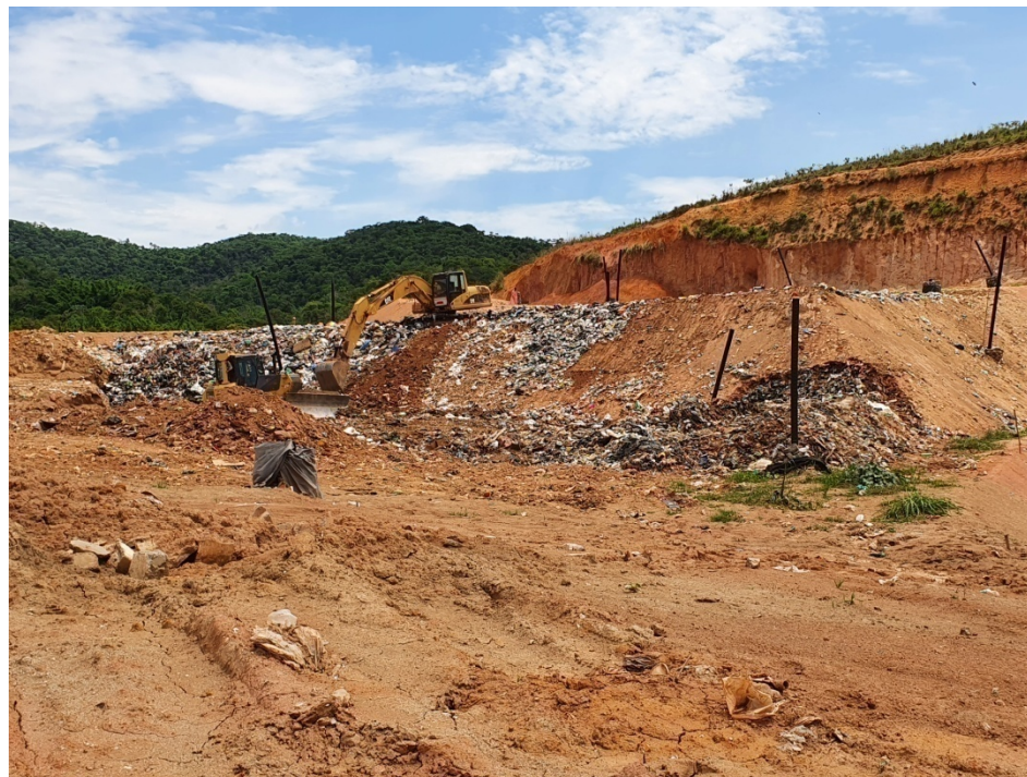
Figura 5: Vista da frente de trabalho.
