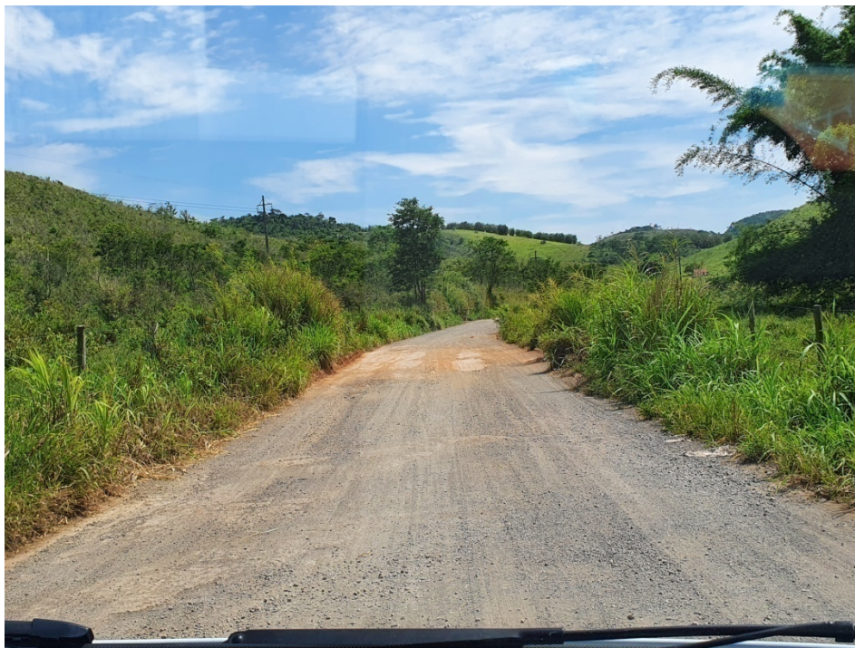
Figura 2: Estrada de acesso apresentando boas condições.
