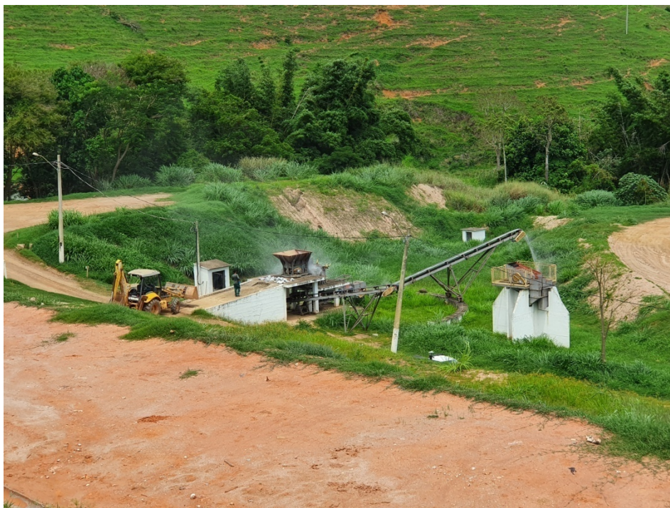
Figura 17: Vista da área do britador de RCC.
