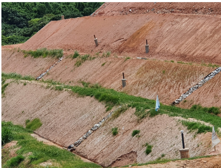
Figura 11: Vista das camadas da célula b com presença de gramíneas após processo de hidrossemeadura.
