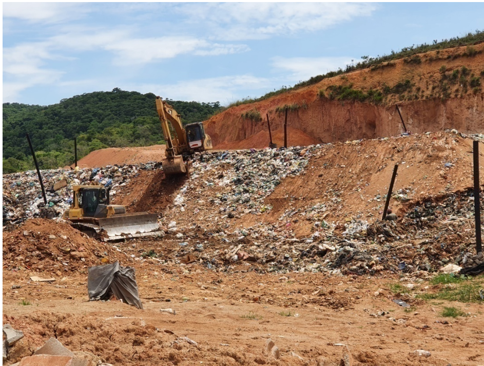
Figura 6: Vista da escavadeira em operação para realizar a cobertura dos resíduos do talude.
