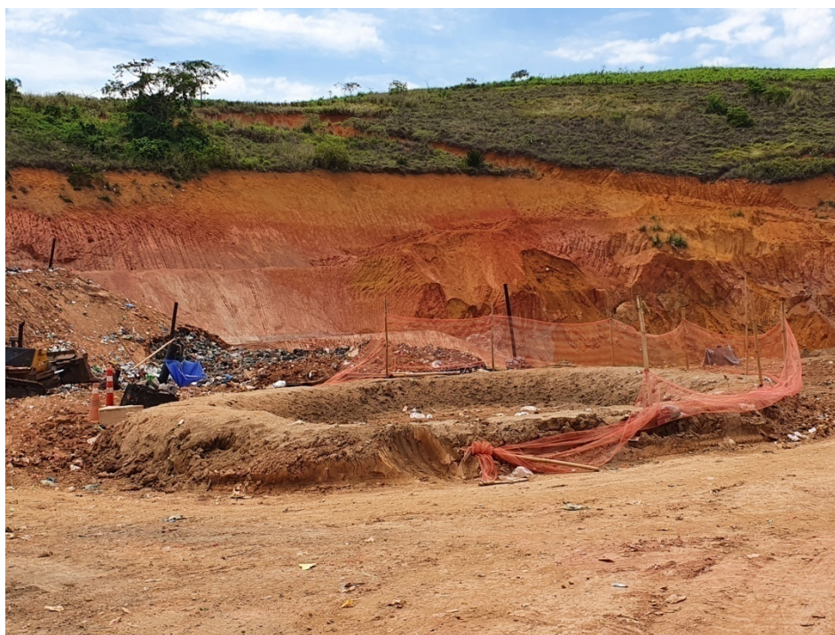
Figura 8: Área reservada para realizar a secagem do lodo oriundo da ETE de Barra Mansa, utilizado, junto com solo, para recobrimento dos taludes.
