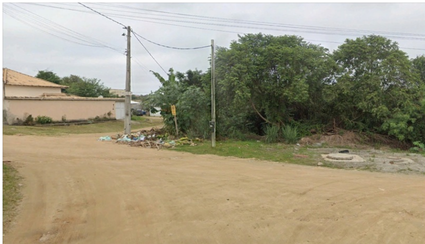
Fotos 6 e 7 – Vista da EEE Nilda Ferreira e do poço de sucção das bombas ( 22° 55' 31,75" S 42° 28' 32,85" O )
