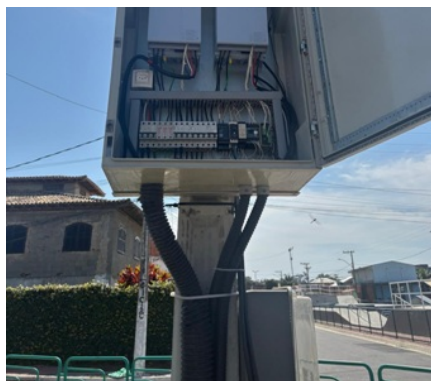
Fotos 8 e 9 – Vista do Quadro de Comando da EEE Leigos (na praça) e do poço de sucção ( 22° 55' 45,41" S 42° 29' 13,27" O )
