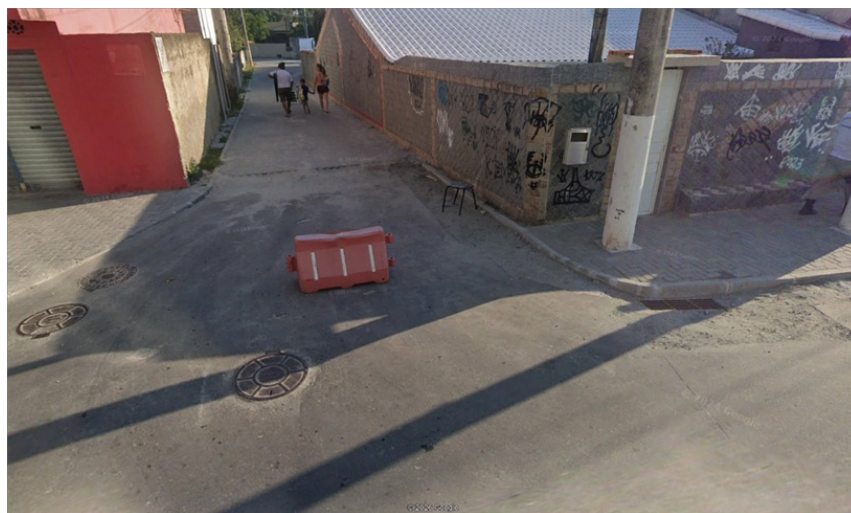
Foto 18 – Vista da EEE Itaúna 3 (Av. Oceânica 253) 22° 55' 58,57" S 42° 29' 23,38" O
