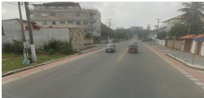
Foto 12 – Vista da EEE Itaúna 1 ( Av. Saquarema esquina Rua Cantor Orlando Silva ) 22° 55' 36,91" S 42° 29' 9,21" O
