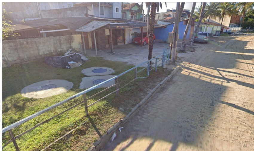
Foto 15 – Vista da EEE Itaúna 2 (Rua Virgínia Marins Pessoa) 22° 55' 59,07" S 42° 29' 27,51" O
