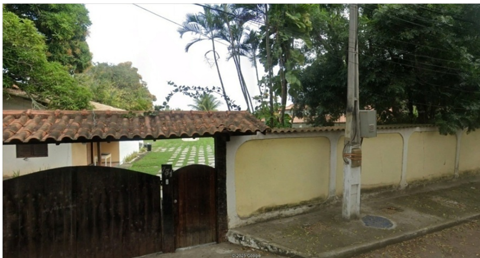
Foto 14 – Vista da EEE Tocas 4 (Rua das Tocas e/f 731).
