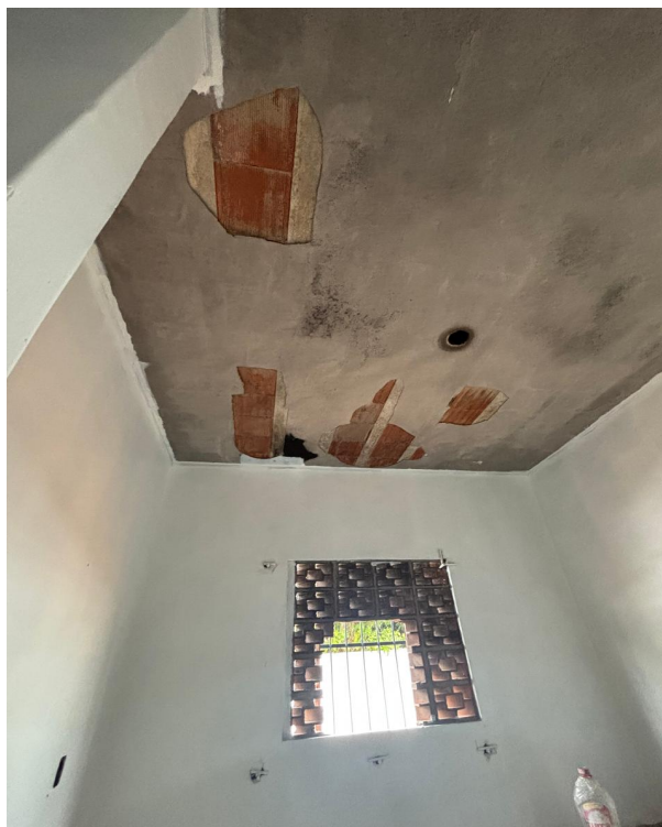
Foto 11 – Paredes com pintura nova e teto ainda a ser reformado
