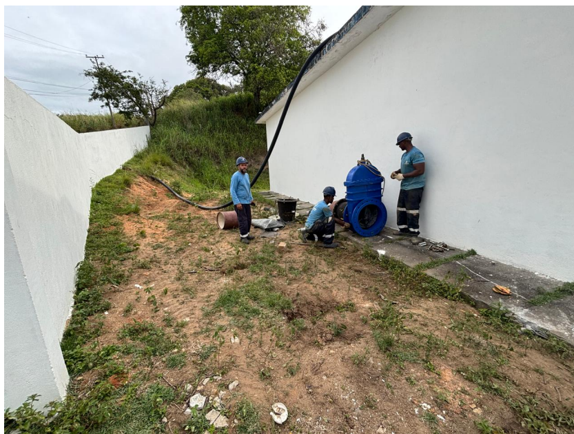
Foto 4 – Válvula sendo preparada para ser instalada e pintura nova
