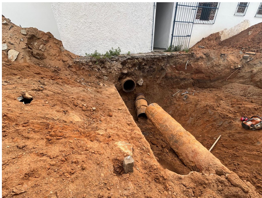
Foto 5 – Tubulação já cortada para a instalação da válvula
