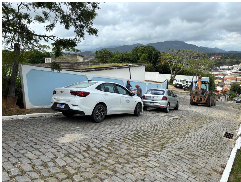
Foto 1 – Vista frontal do reservatório murado, massem identificação
