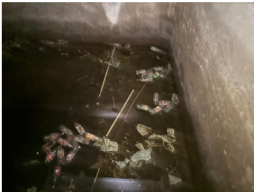
Foto 5 – Água parada com detritos em uma das células
