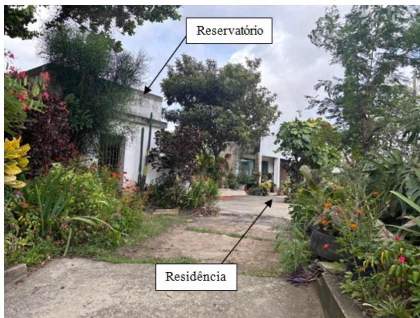
Foto 2 – Reservatório e residência juntos na mesma área
