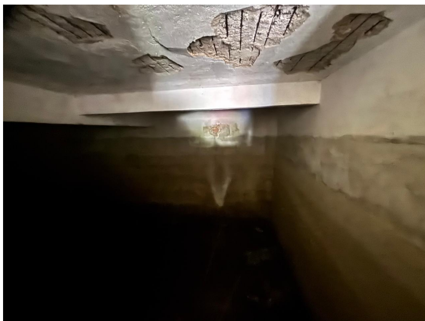
Foto 8 – Ferragens expostas em uma das células
