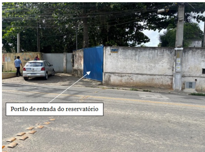
Foto 1 – Vista frontal do reservatório sem identificação
