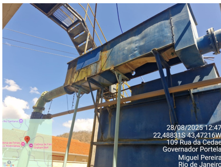
Foto 10 – Vista inferior da calha parshall
