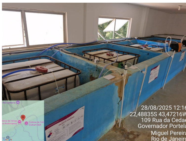
Foto 08 – Tanque de produtos químicos
