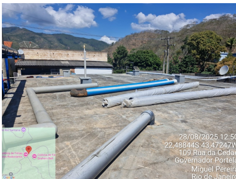
Foto 06 – Cobertura do tanque de contato
