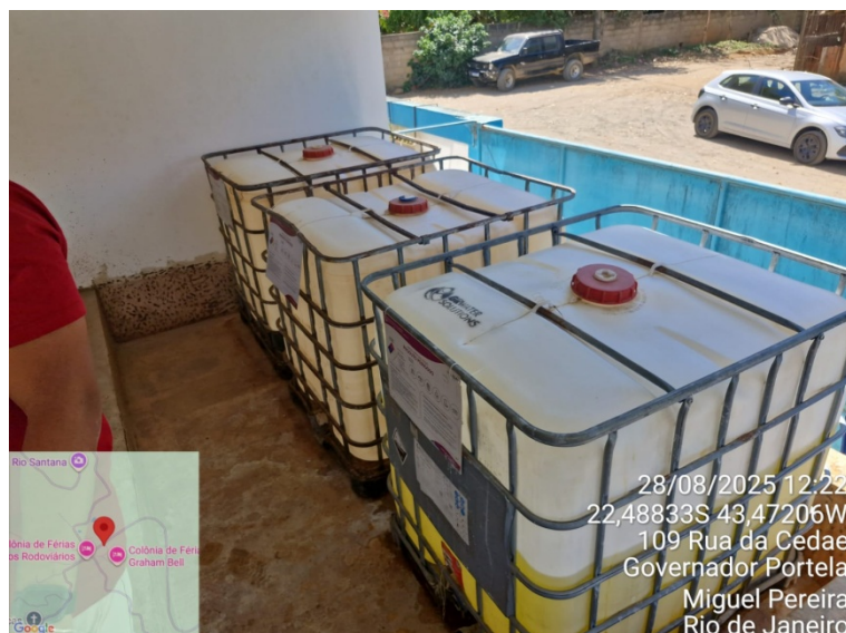
Foto 09 – Tanque de produtos químicos
