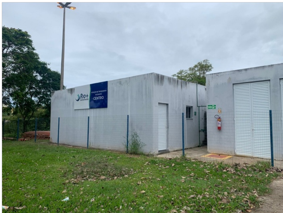
1 Entrada da Unidade devidamente identificada
