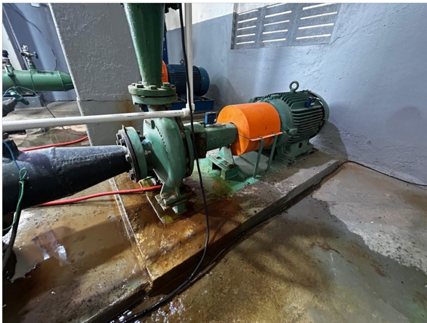
Foto 3 - Pequeno vazamento
