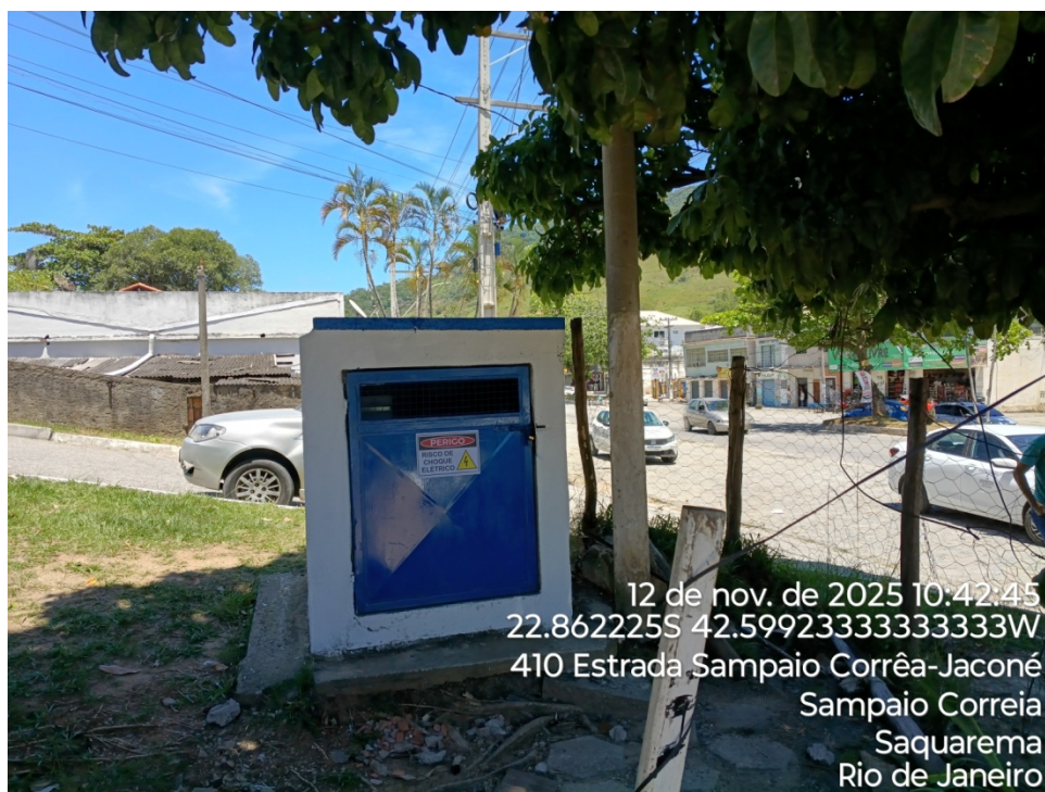
Foto 02 – Vista frontal da EEAT Posto de Saúde III
