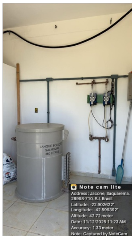
Foto 17 – Interior prédio operacional
