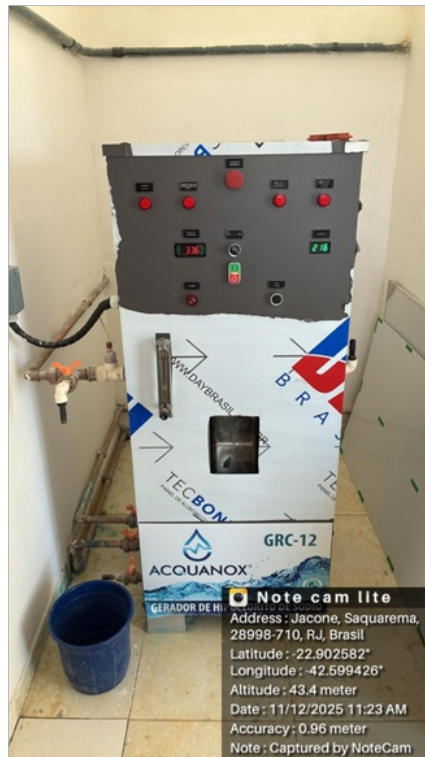
Foto 18 – Interior prédio operacional
