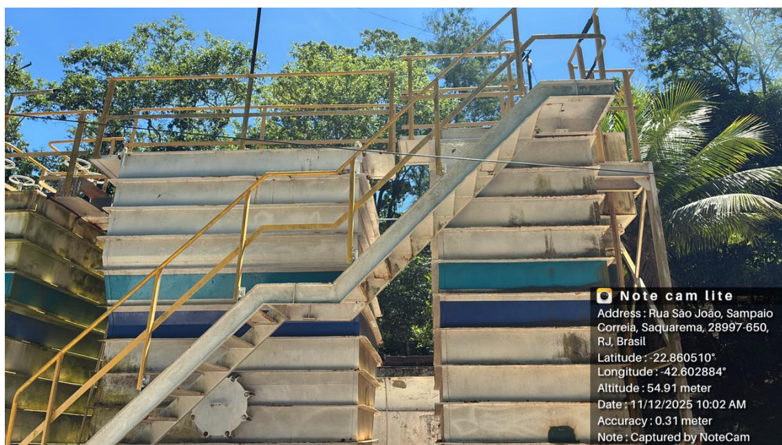
Foto 02 – Vista lateral (escada de acesso) da ETA
