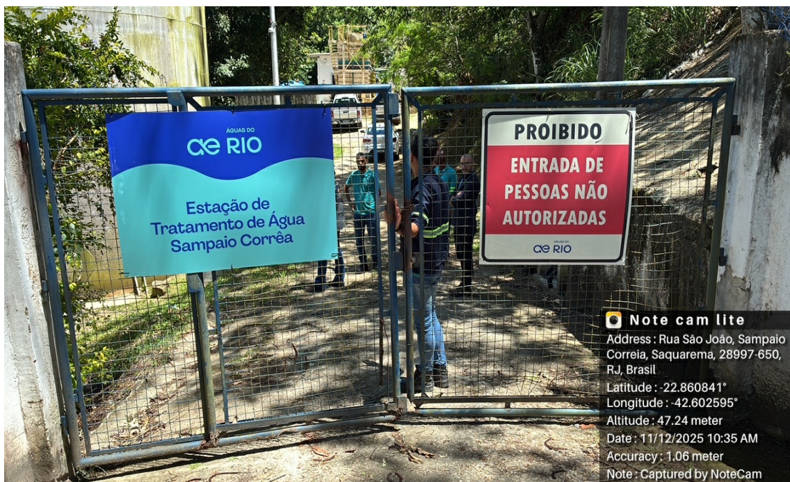
Foto 01 – Portão com sinalização de acesso restrito na entrada da ETA.
