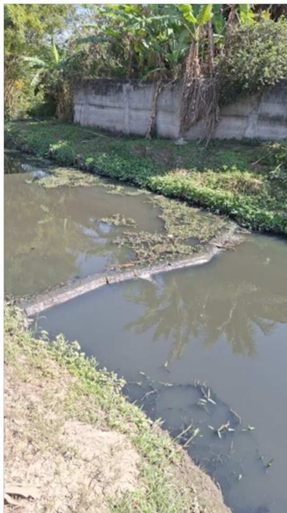
Fotos 8 – Vista da barragem da CTS da EEE Raia.
