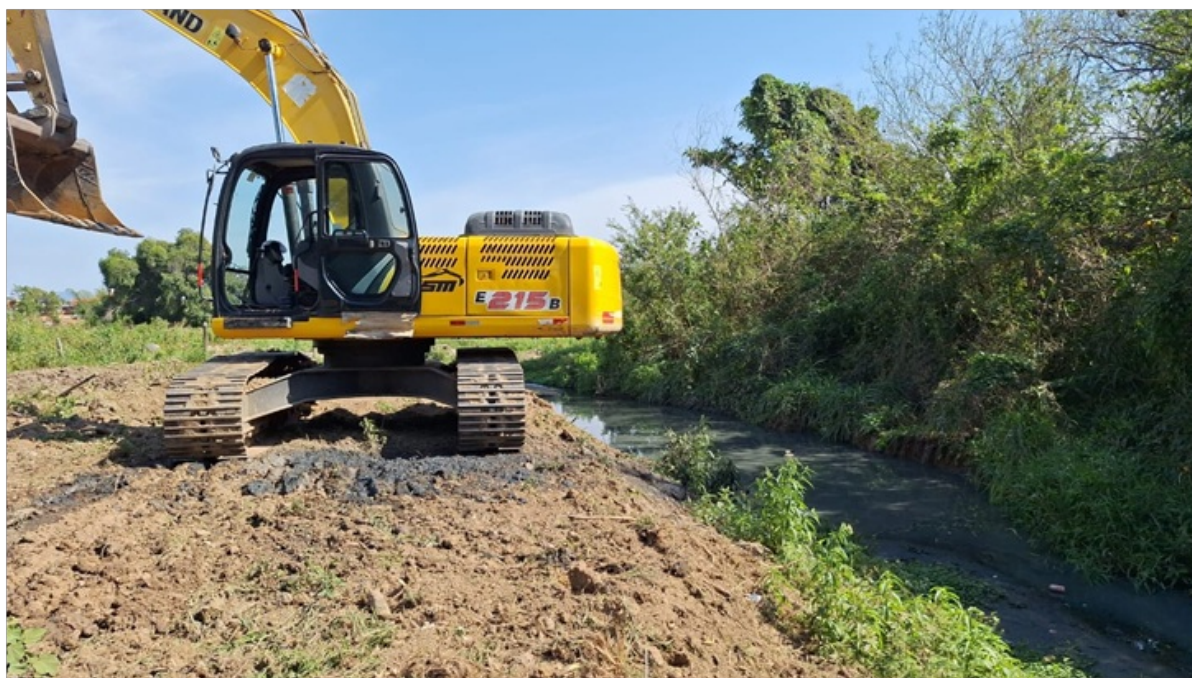
Fotos 11 – Vista do Córrego da Fazendinha que é captado pela EEE Raia, que estava recebendo limpeza e desassoreamento (dragagem).
