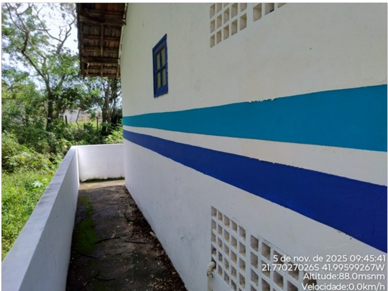
Foto 03: Abrigo do PCO.
