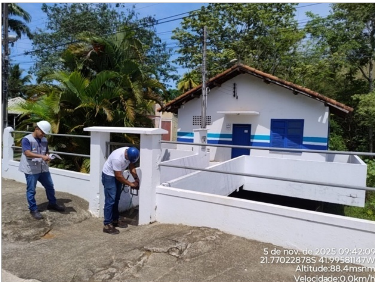
Foto 01: Acesso ao PCO cercado e com restrição de acesso.
