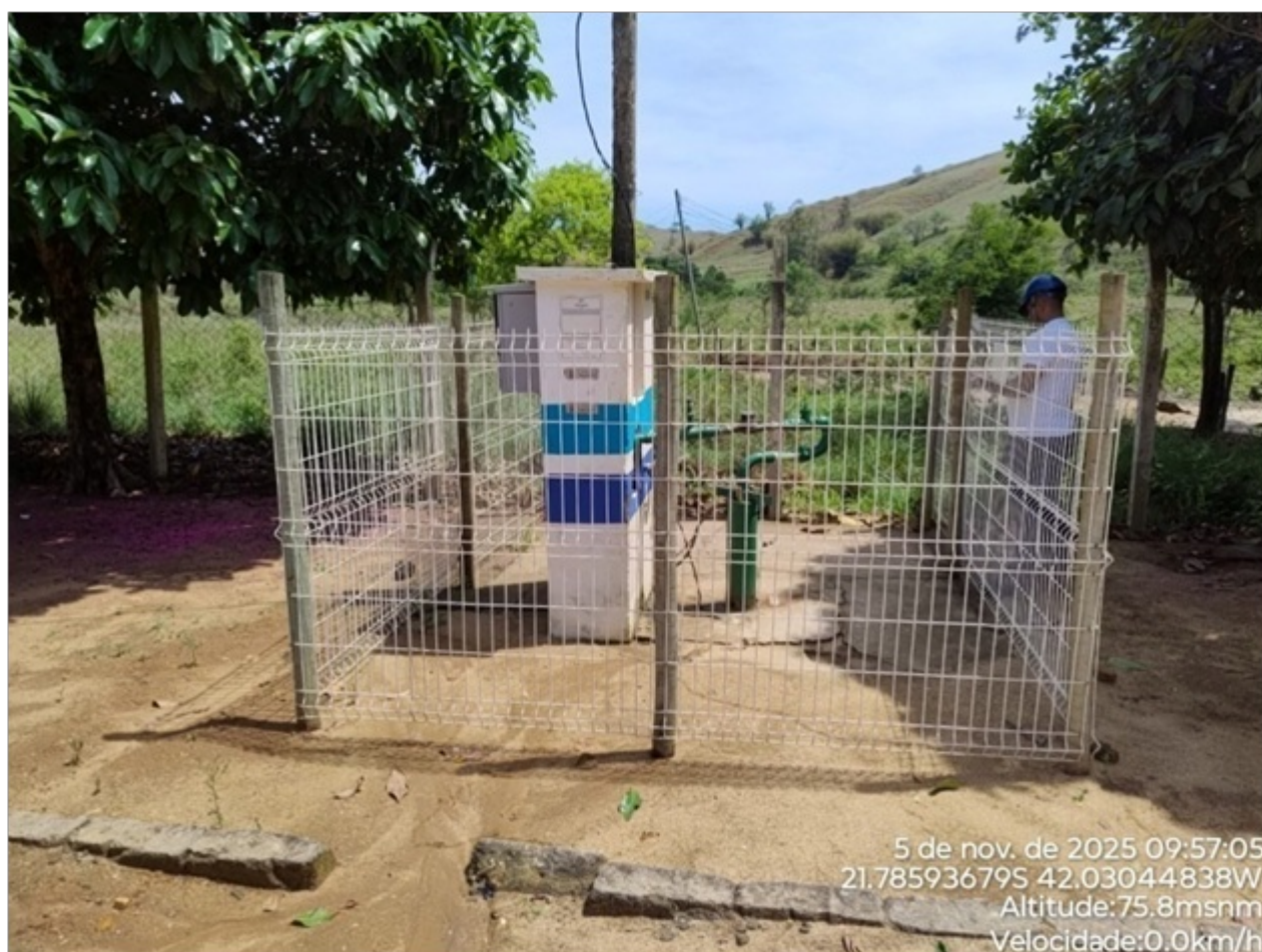
Foto 02: Abrigo do PCO com restrição de acesso.
