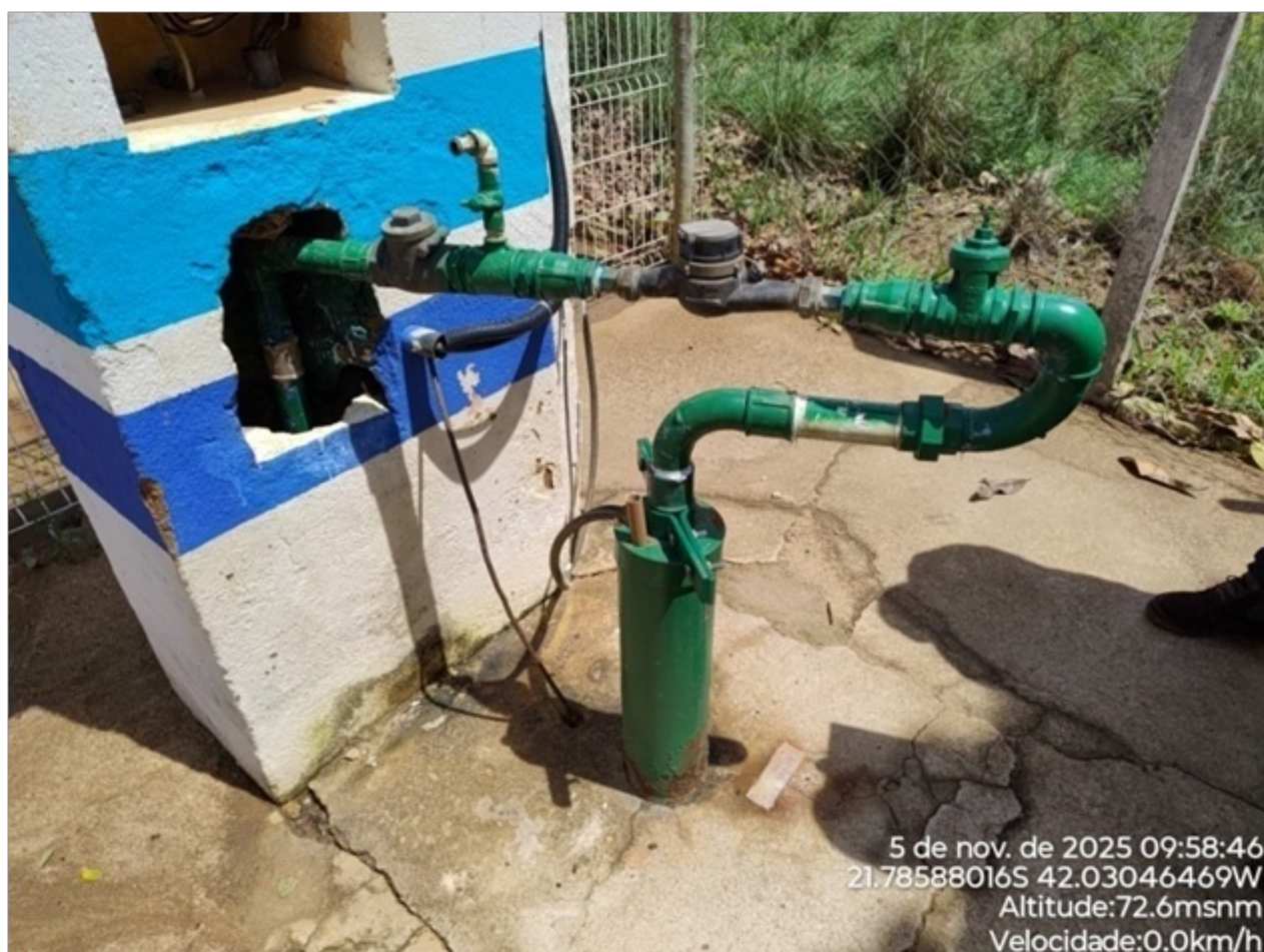
Foto 04: Barrilete do PCO.
