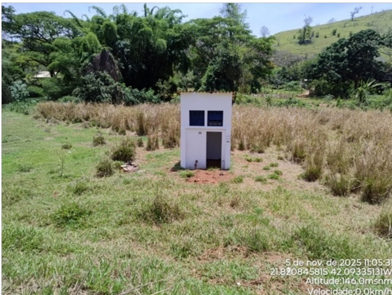
Foto 01: A área do poço não possui cercamento e restrição de acesso.
