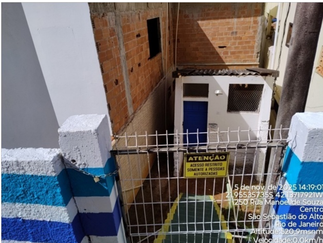
Foto 01: A área do poço apresenta cercamento e restrição de acesso.
