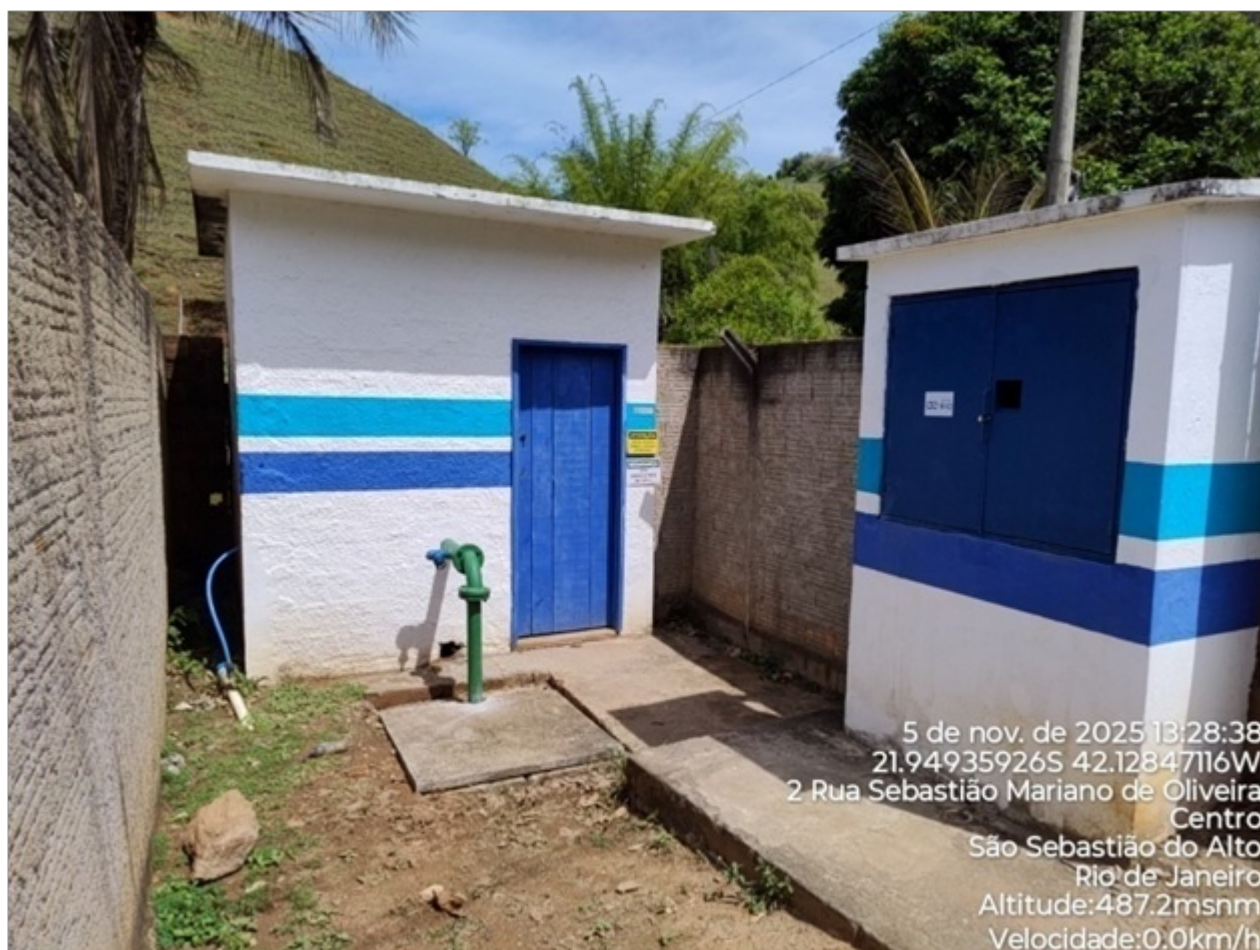
Foto 01: A área do poço apresenta isolamento porém não possui identificação externa.
