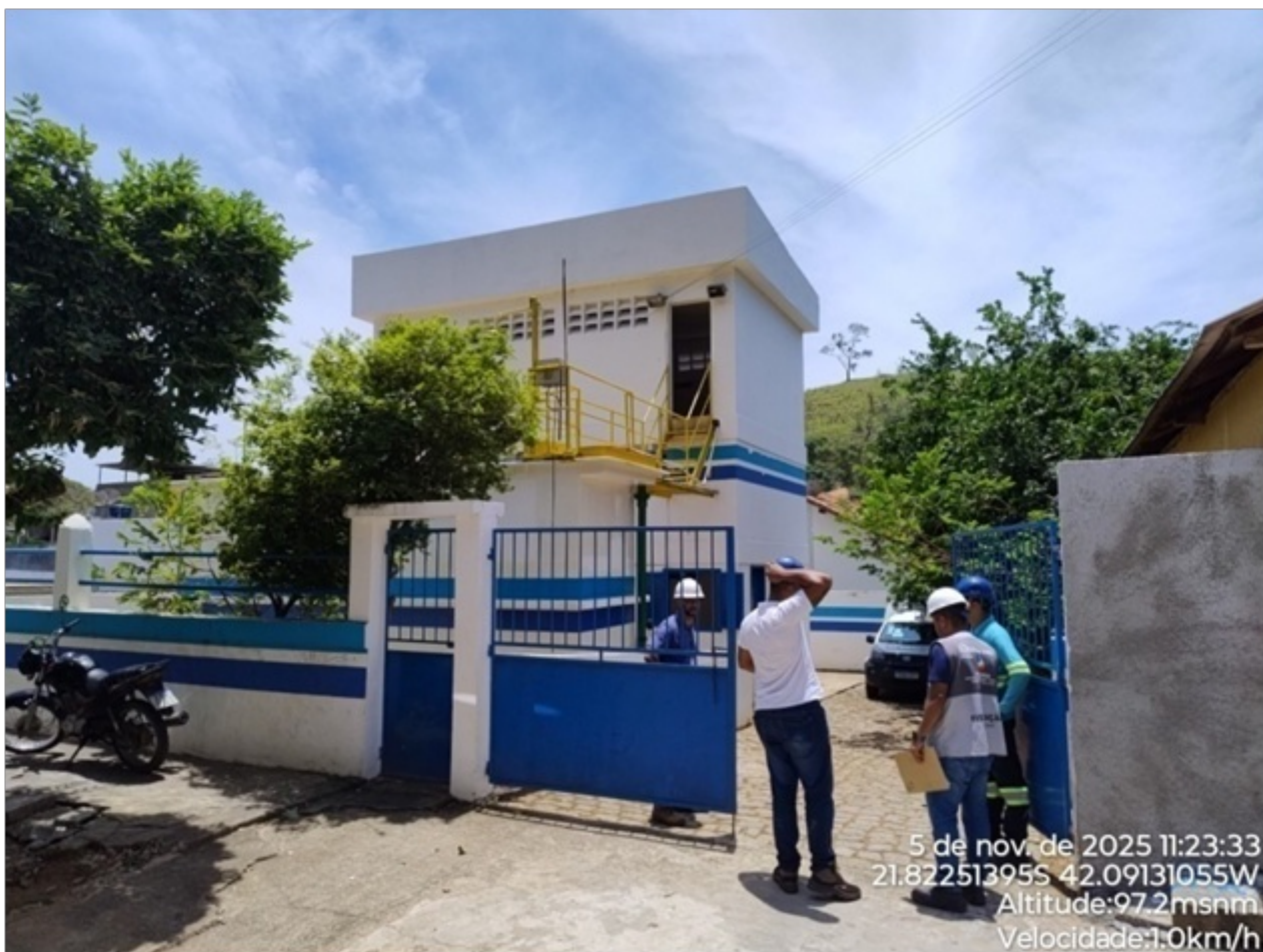
Foto 01: Entrada da ETA sem identificação da unidade.
