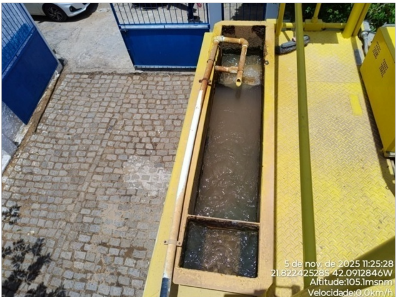
Foto 05: Chegada da água bruta e aplicação do agente coagulante.
