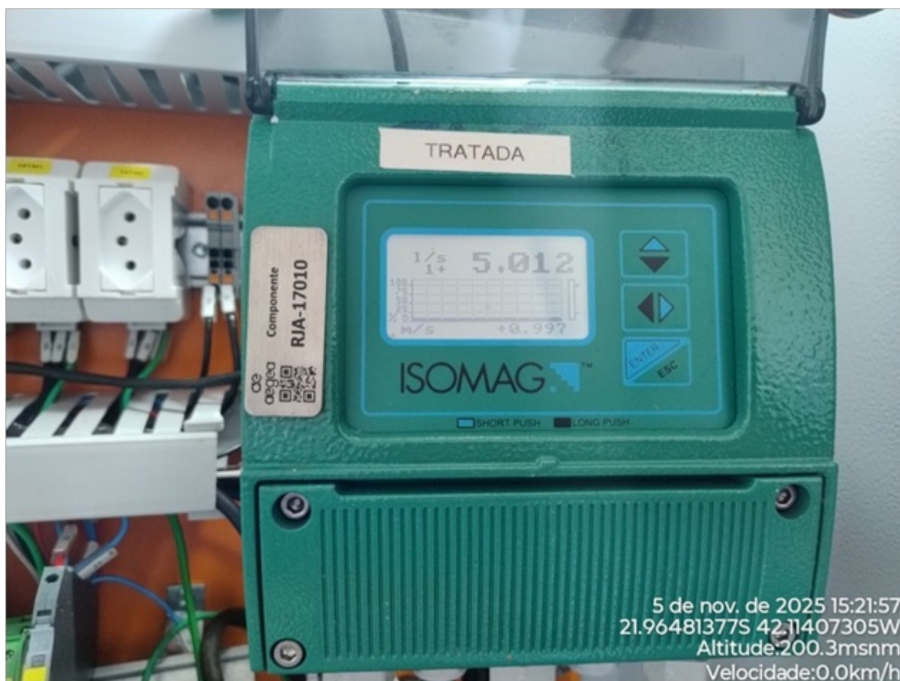
Foto 16: Macromedidor de água tratada.
