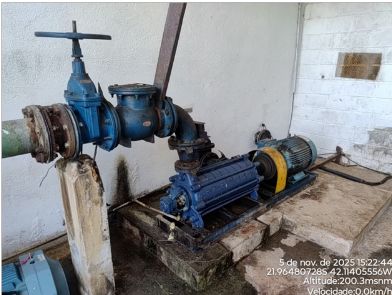
Foto 14: Indício de vazamento na bomba da EEAT.
