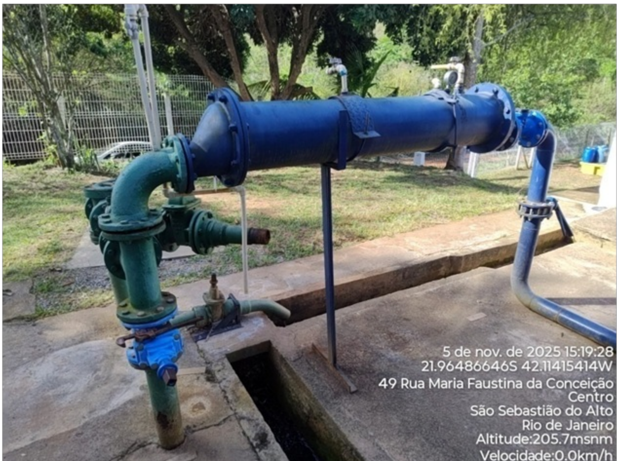
Foto 01: Misturador estático tubular.
