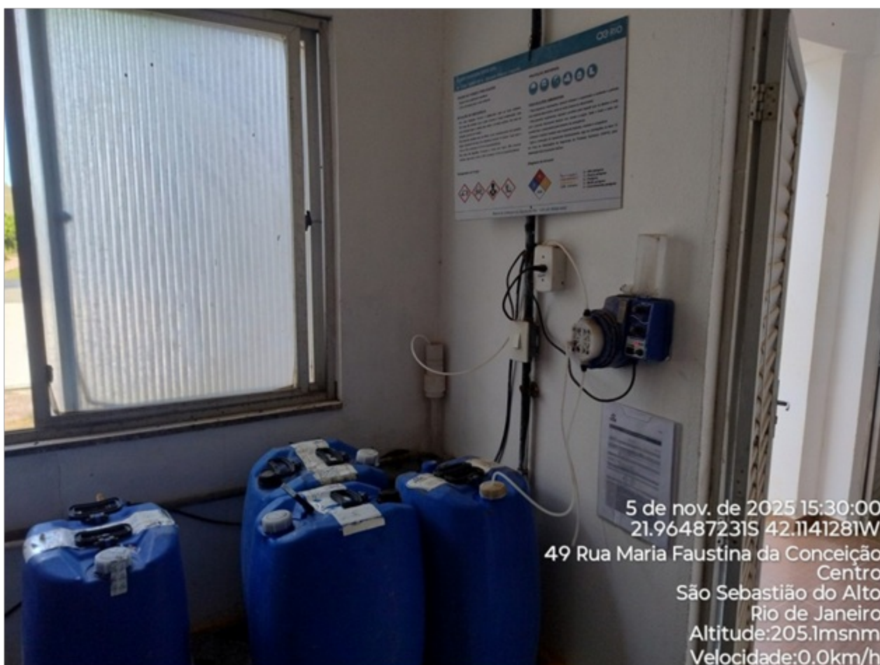
Foto 05: Dosador de Ácido fluossilícico.
