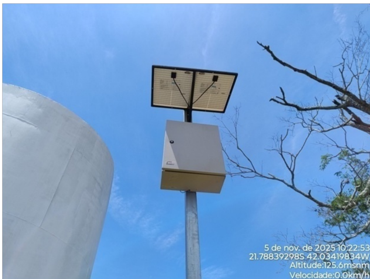
Foto 04: Equipamento de controle e telemetria.
