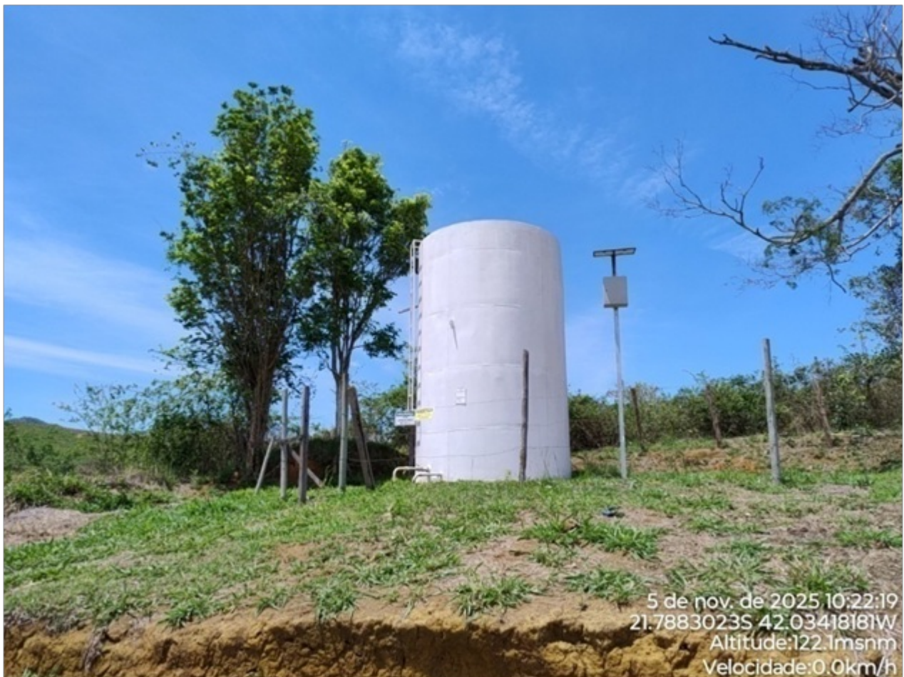
Foto 01: Acesso ao reservatório.
