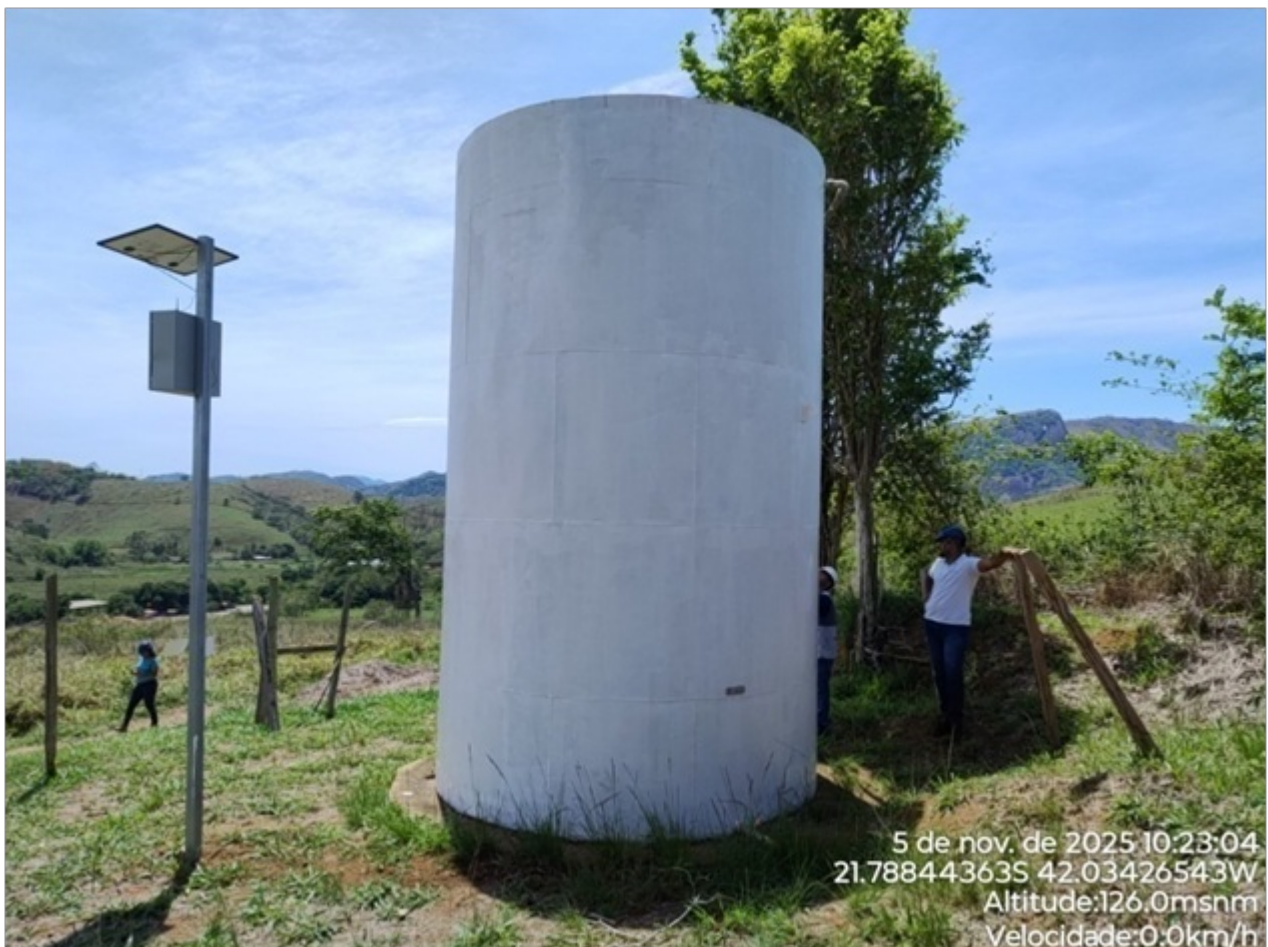
Foto 02: Vista da lateral do reservatório.
