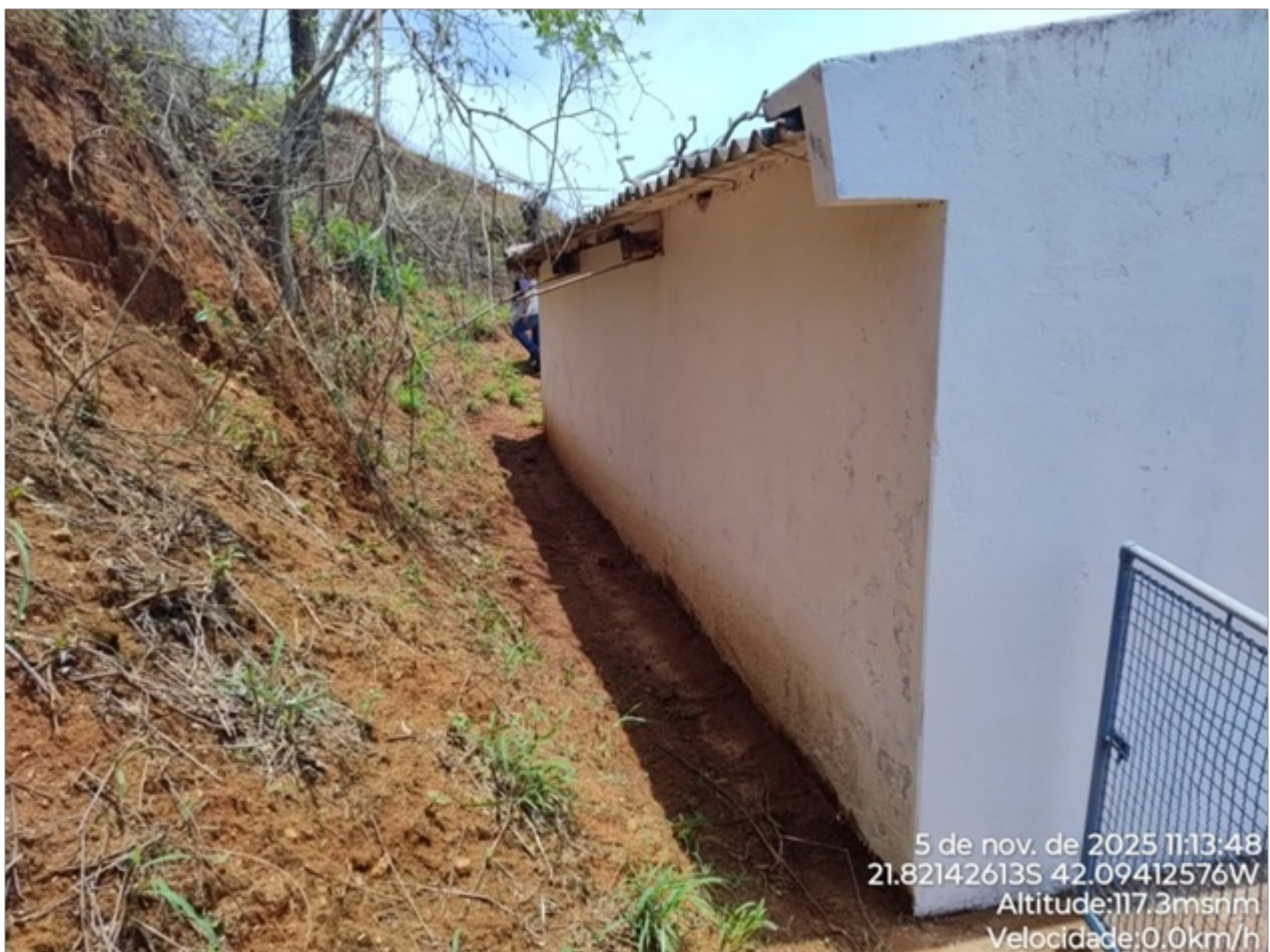
Foto 03: Vista parcial do reservatório.
