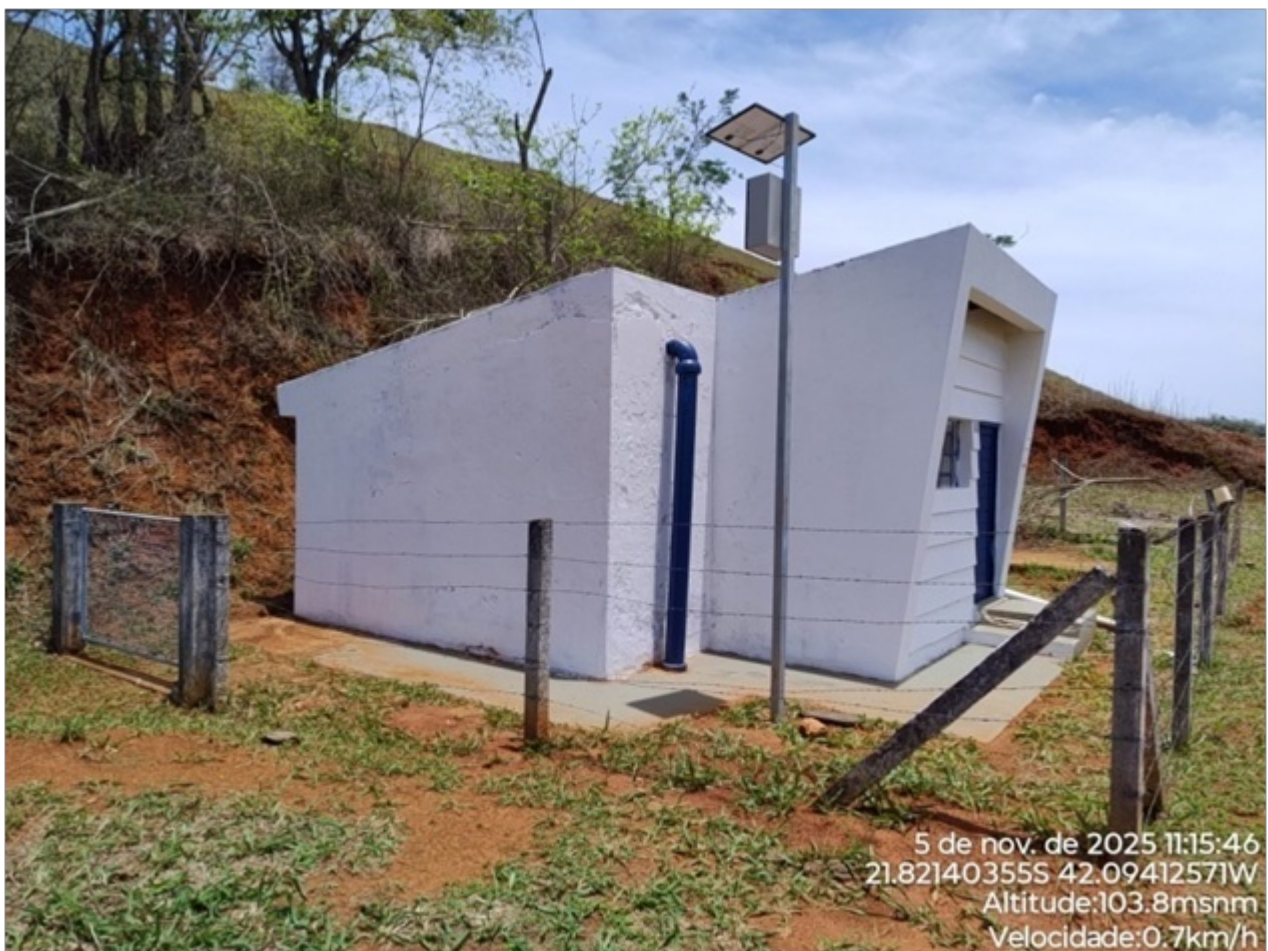
Foto 01: Área do reservatório isolada e com restrição de acesso.
