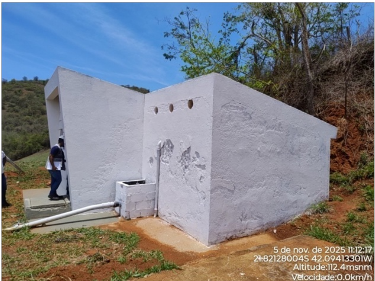
Foto 02: Vista da lateral do reservatório.
