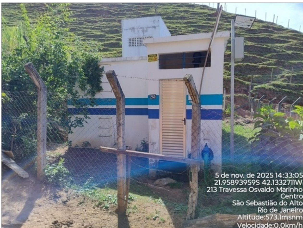
Foto 01: Acesso ao reservatório sem restrição de acesso.
