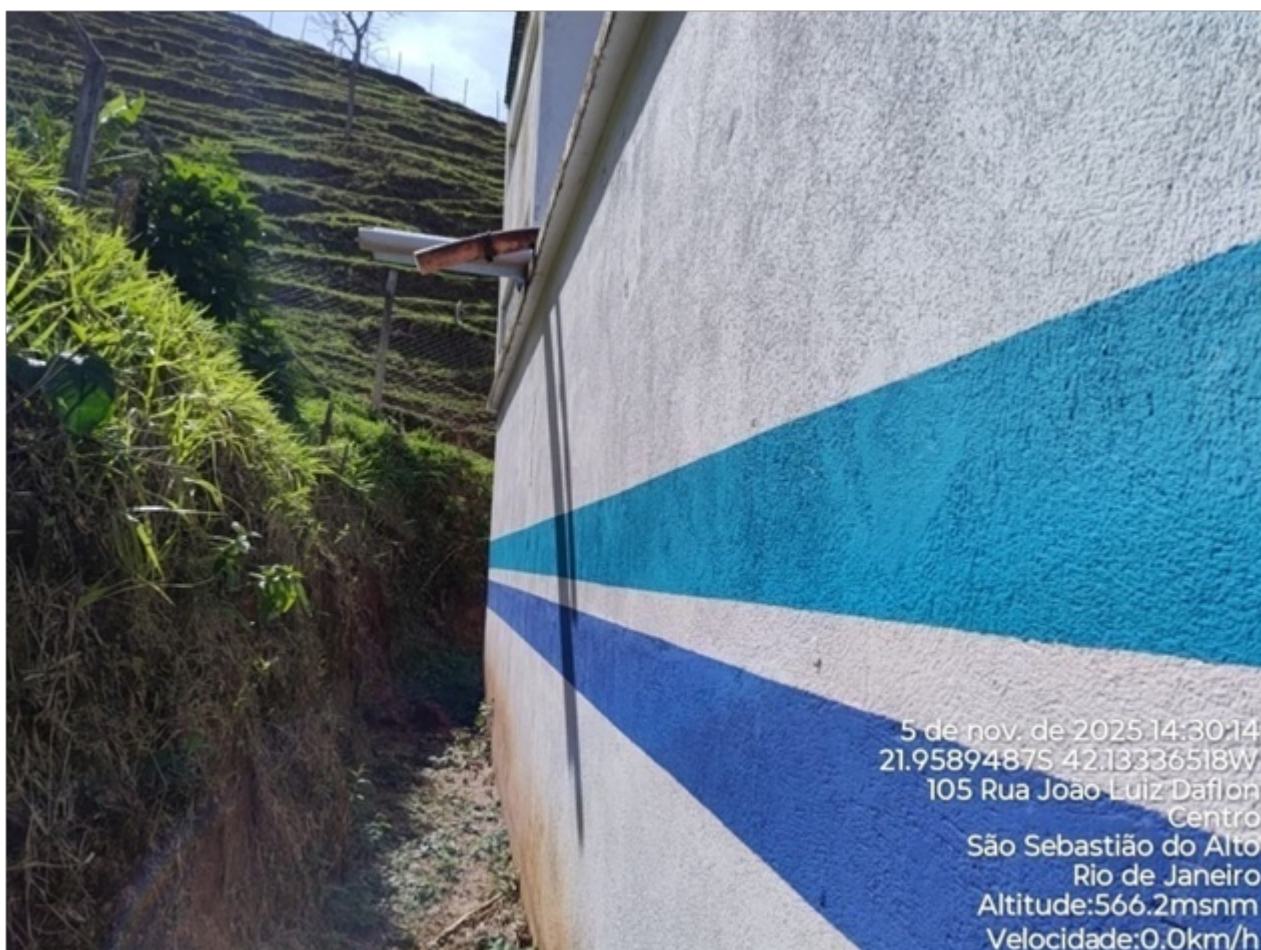
Foto 03: Vista parcial do reservatório.
