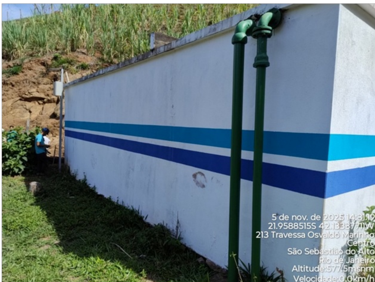
Foto 04: Vista parcial do reservatório.
