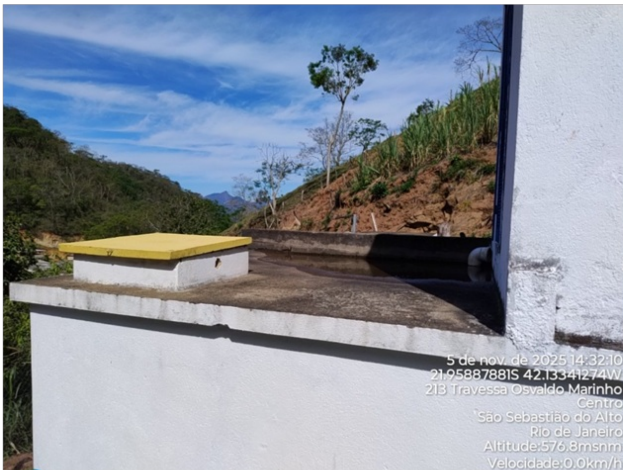
Foto 05: Laje de cobertura do reservatório.
