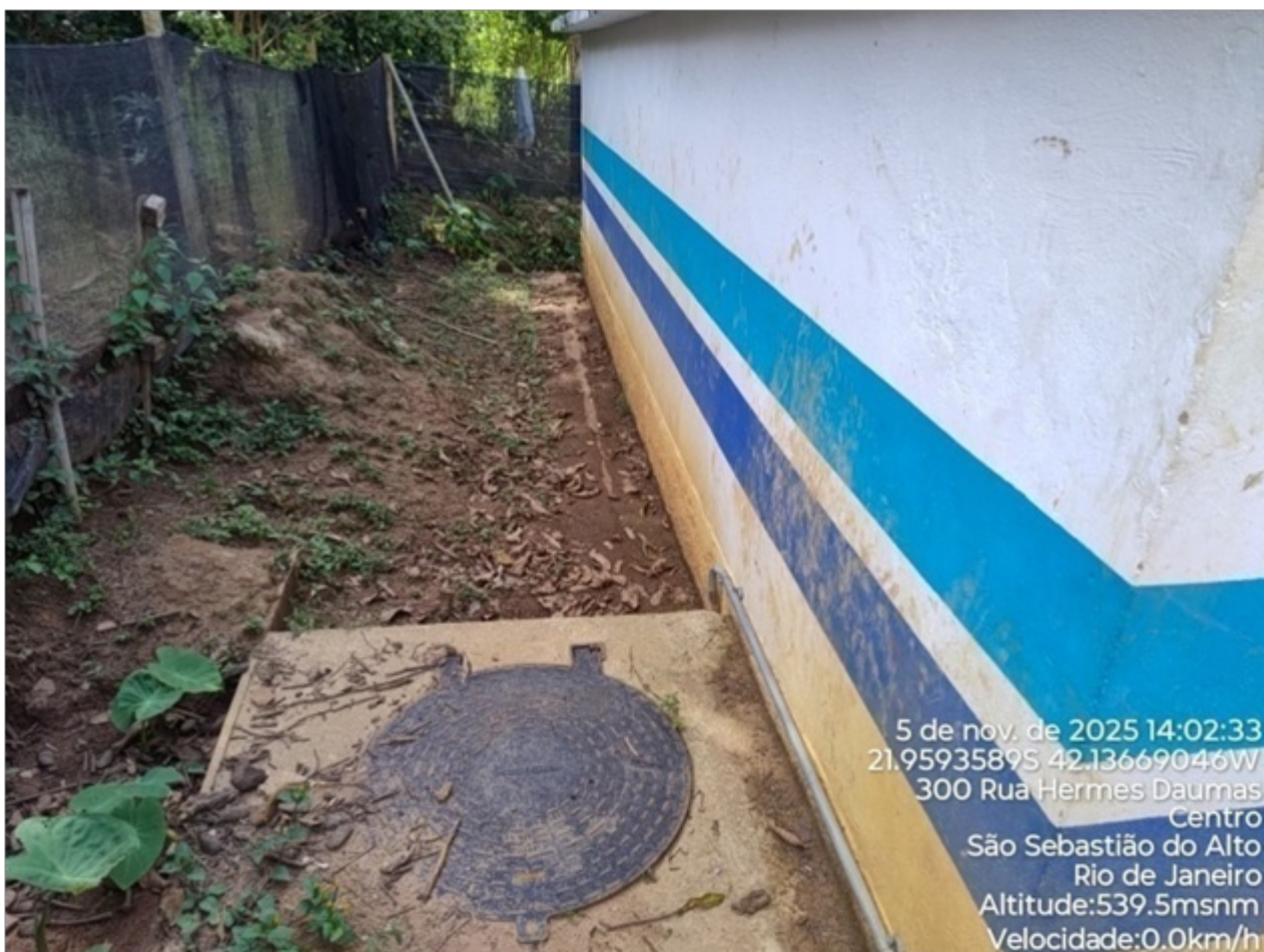
Foto 04: Vista do abrigo da EEAT.
