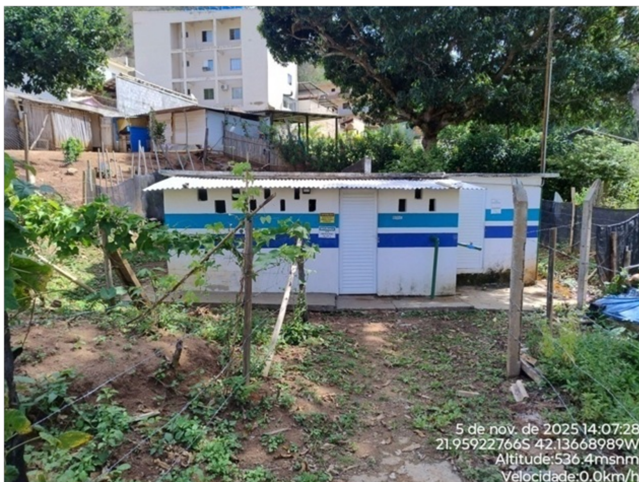
Foto 02: Abrigo da EEAT com restrição de acesso.
