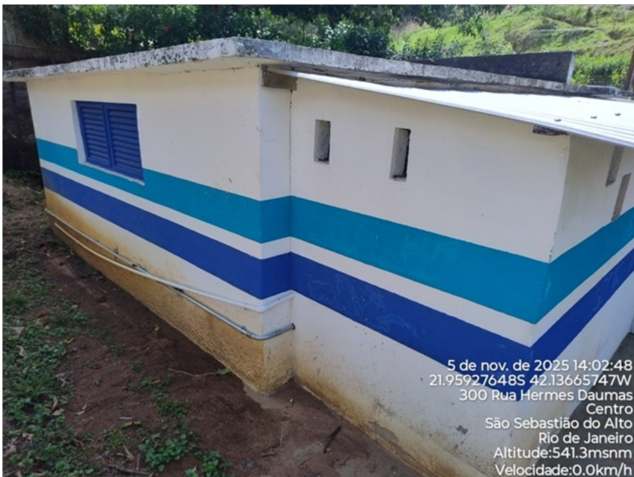
Foto 03: Vista do abrigo da EEAT.
