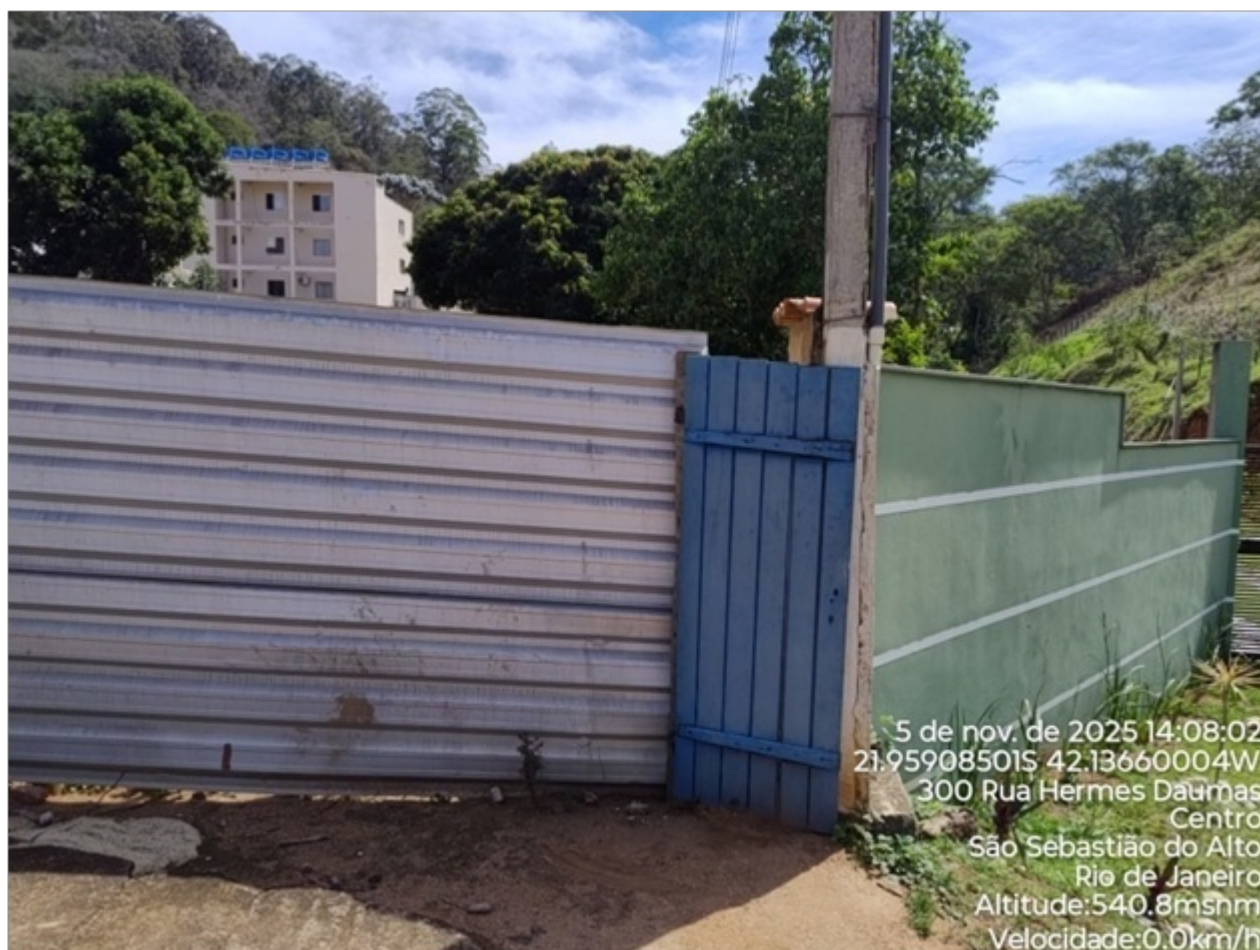
Foto 01: Abrigo da EEAT com restrição de acesso.
