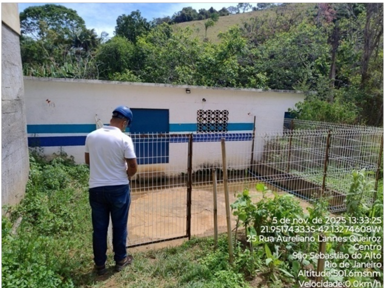
Foto 01: Abrigo da EEAT com restrição de acesso.
