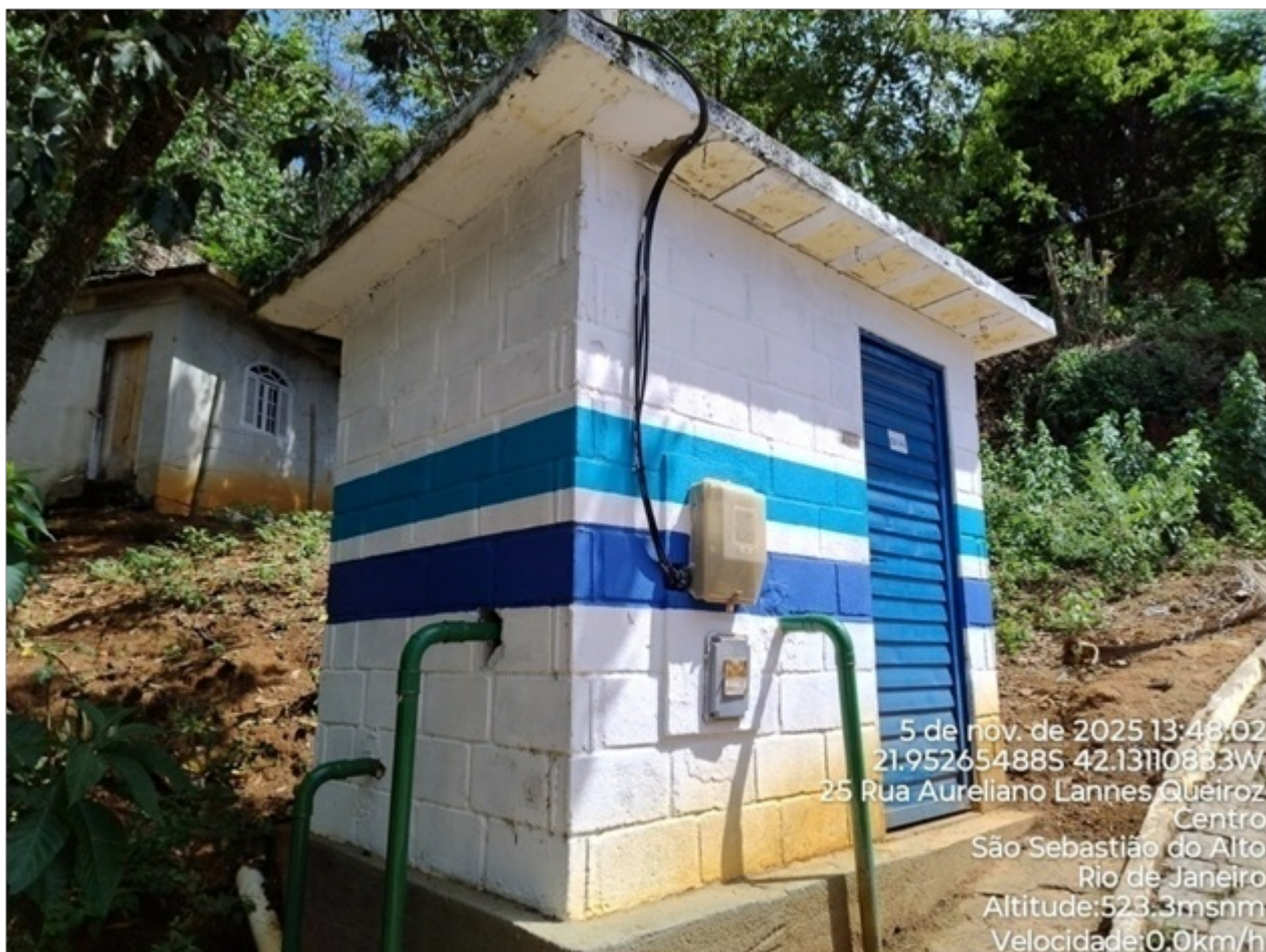
Foto 01: Abrigo da elevatória isolado e com restrição de acesso.
