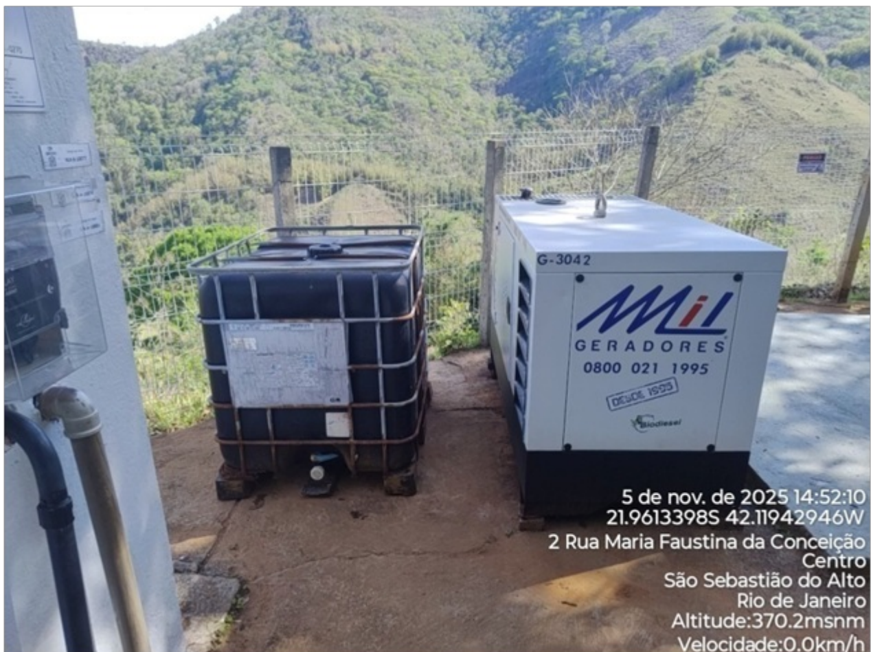
Foto 05: Gerador de energia elétrica em caso de interrupção no fornecimento da distribuidora.
