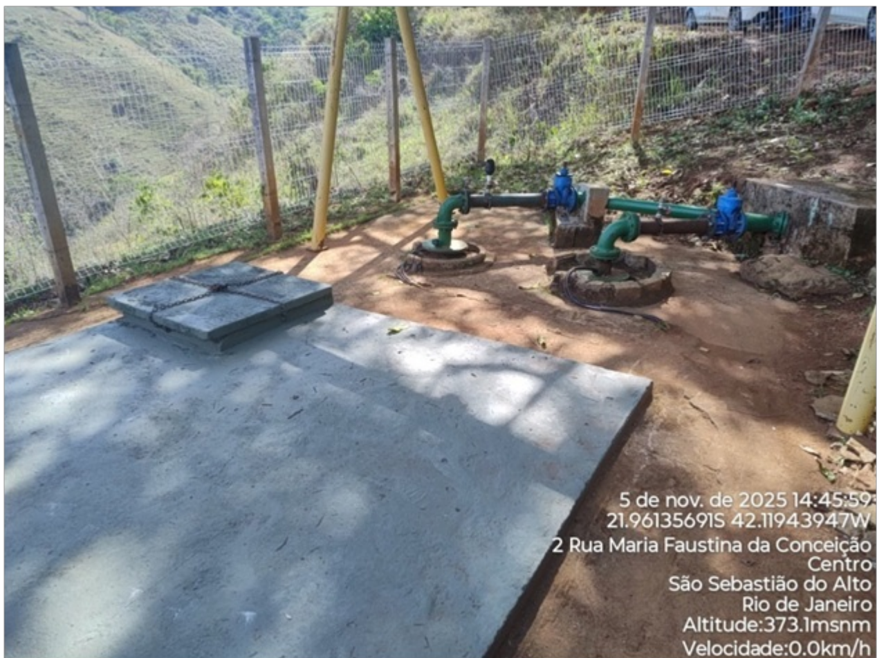
Foto 04: Poço de sucção e bombas da EEAT.
