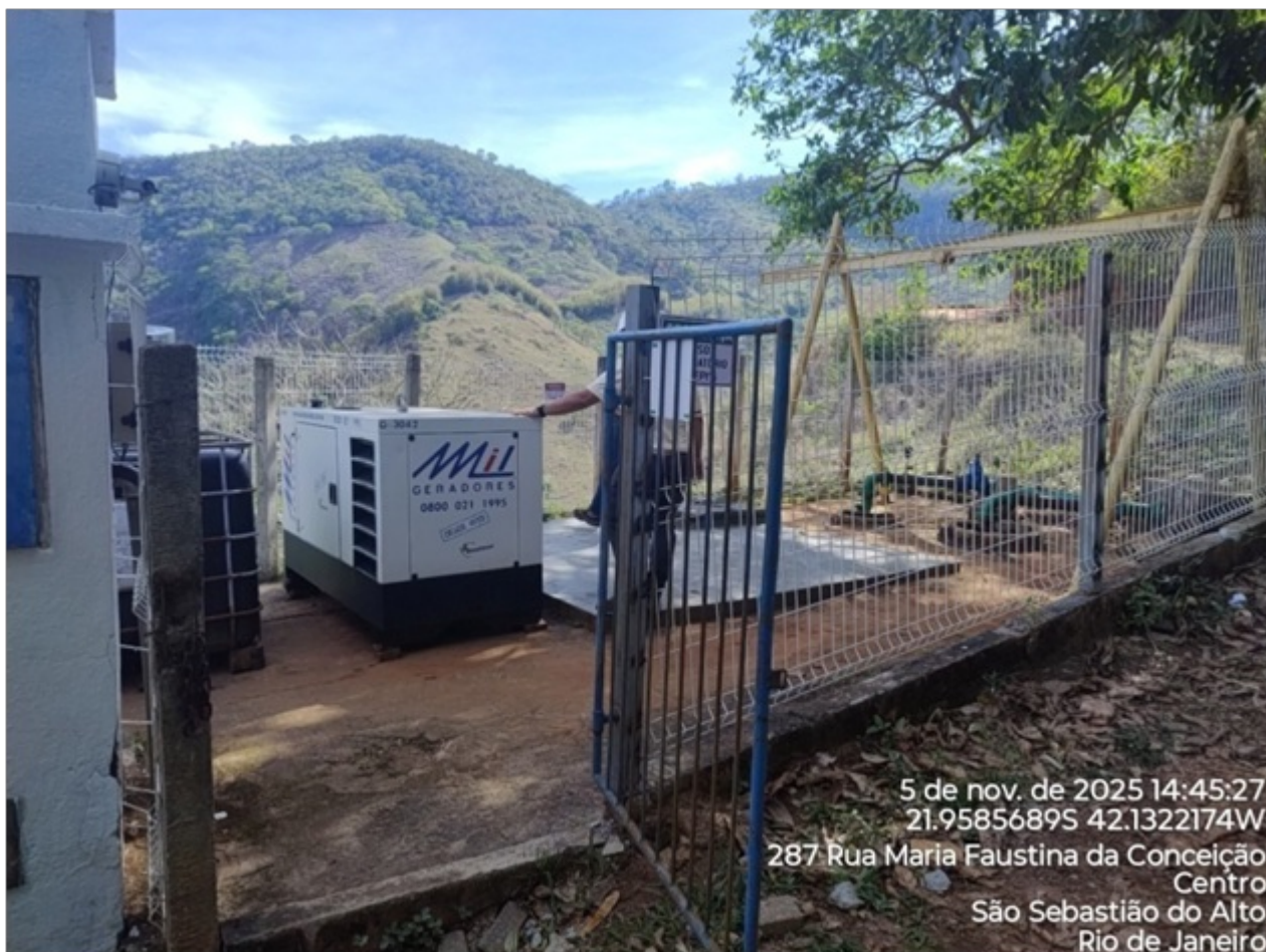
Foto 01: Área da elevatória isolada e com restrição de acesso.
