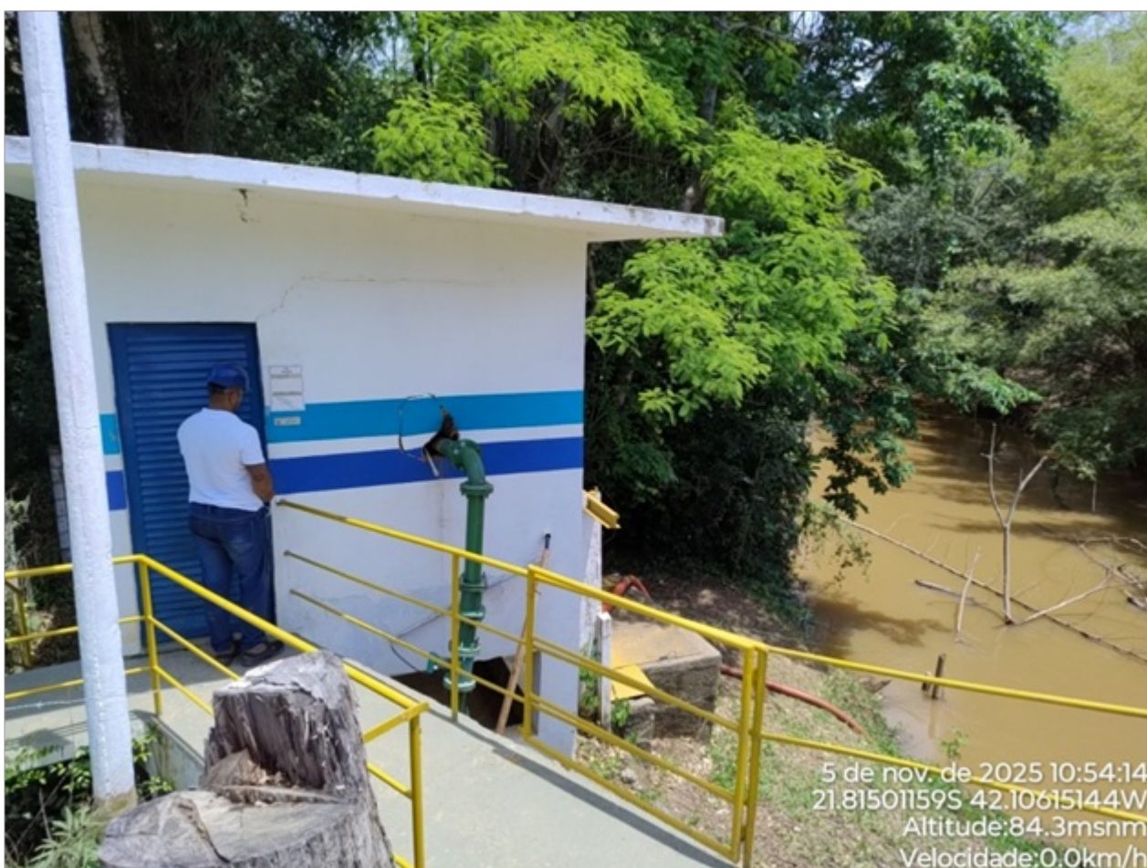
Foto 02: Acesso ao abrigo da captação com restrição de acesso.
