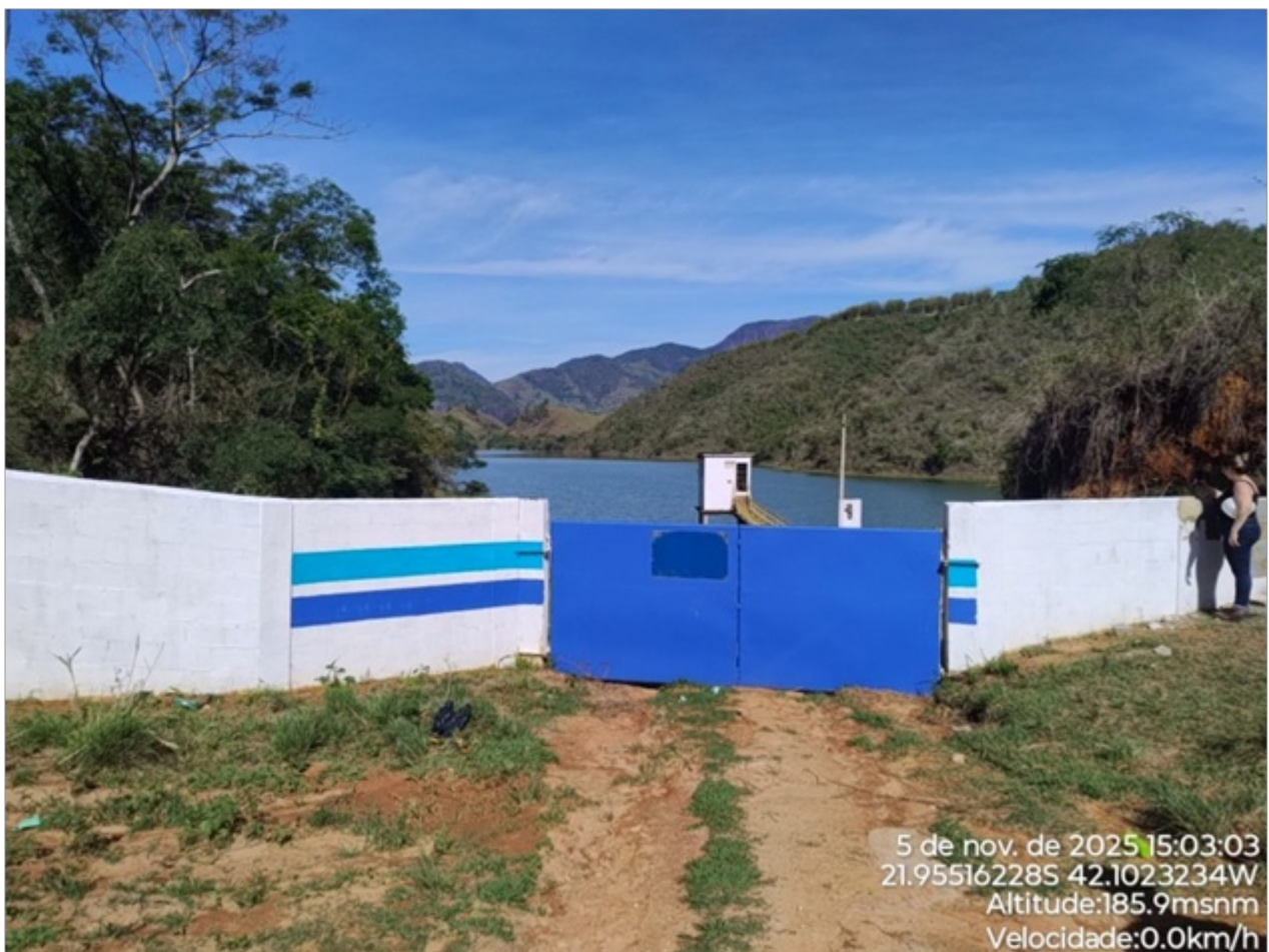
Foto 01: Acesso a captação isolado e com restrição de acesso.
