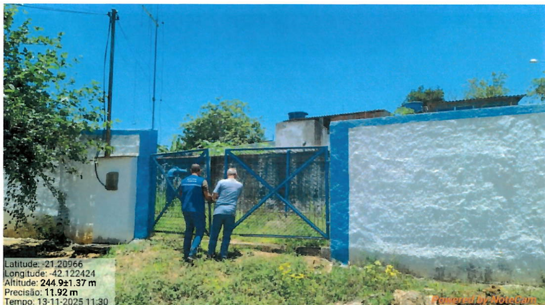
Foto 1: Entrada do Reservatório do Cruzeiro.
