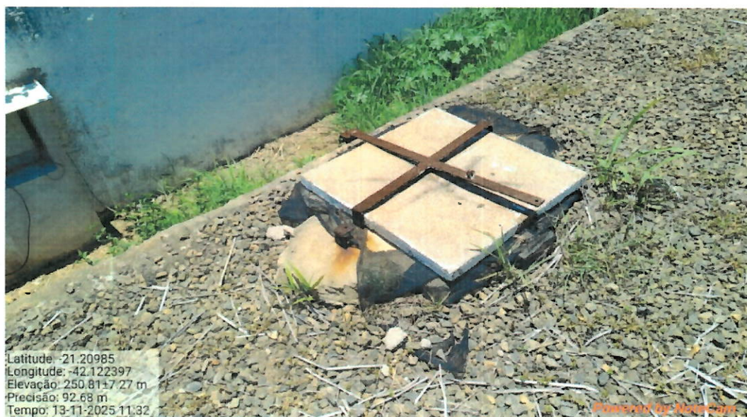
Foto 4 : Tampa de inspeção.
