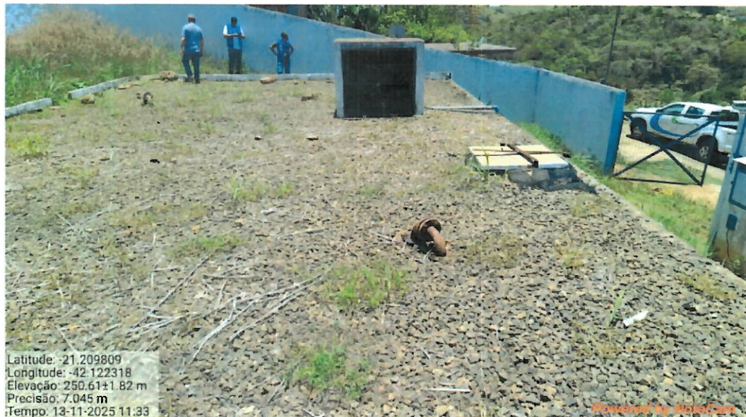
Foto 3 : Vista superior do reservatório.
