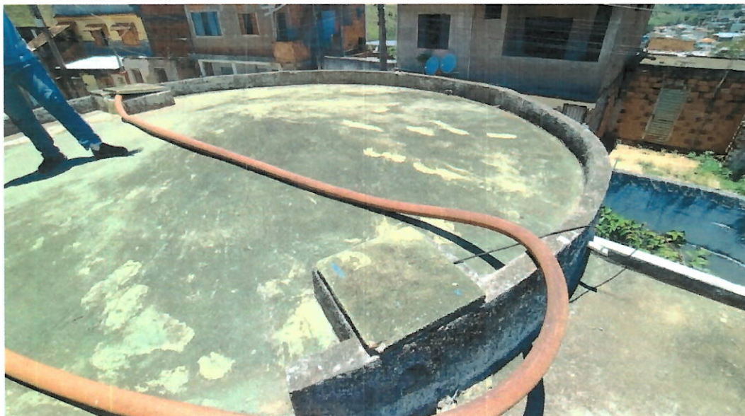
Foto 3 : Vista superior do reservatório.
