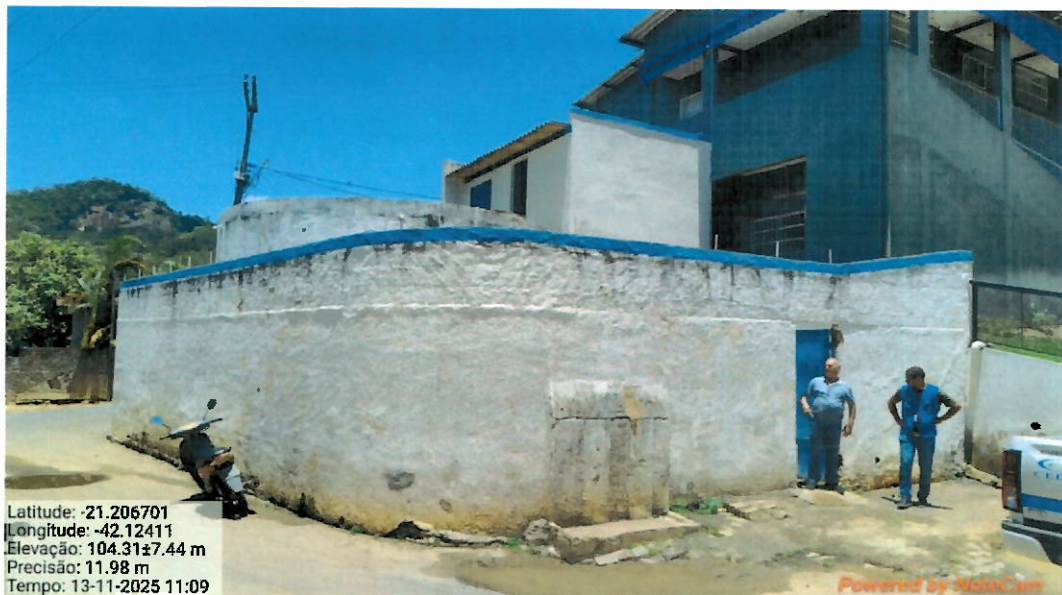
Foto 1: Entrada do Reservatório do Querosene.
