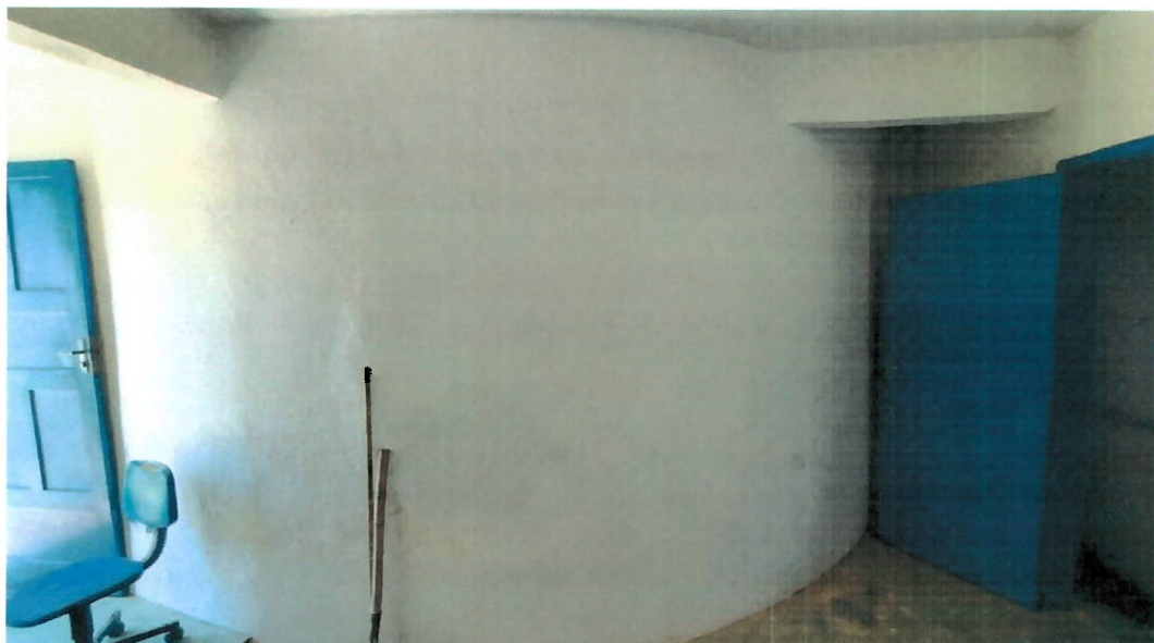
Foto 5 : Obra de impermeabilização realizada.
