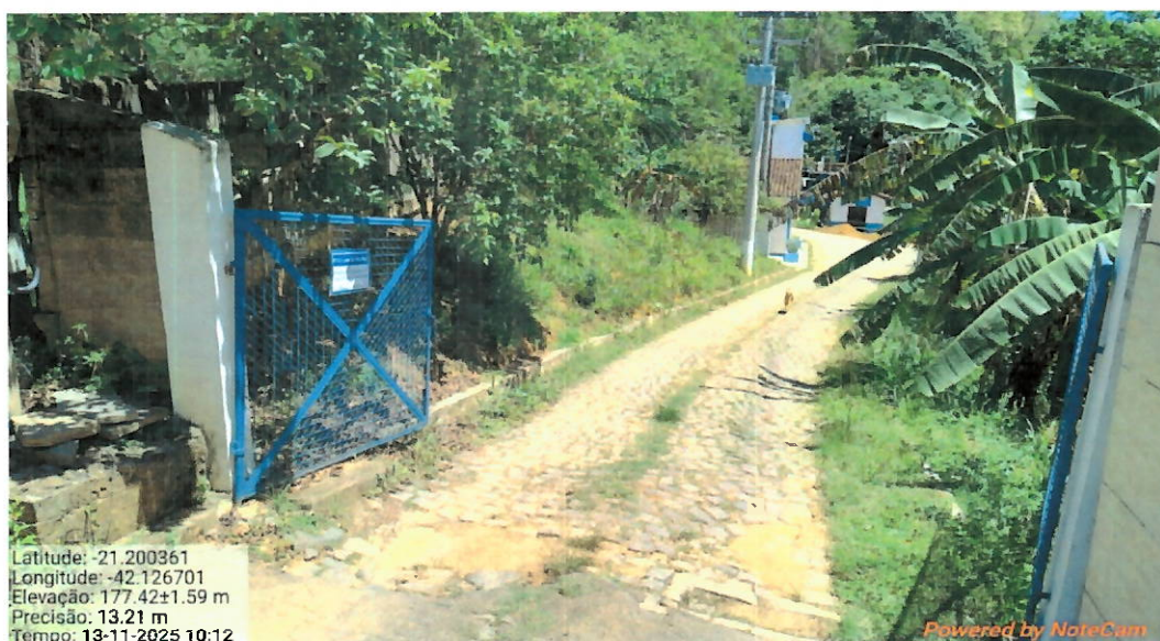
Foto 1: Entrada da ETA.
