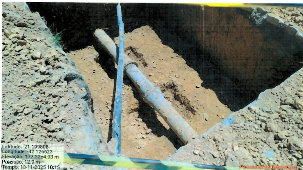
Foto 6: Obra para instalação de macromedidor.
