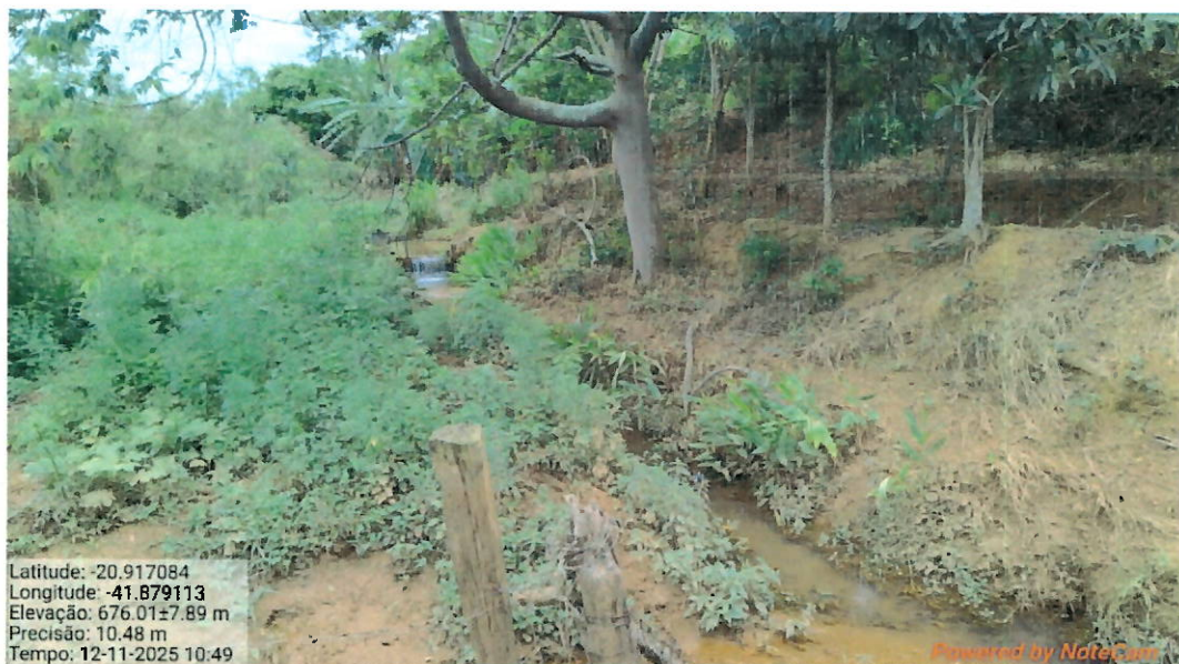
Foto 1: Córrego Santa Cruz -- nota-se a ausência de cercamento no ponto de captação e de placa de identificação.
