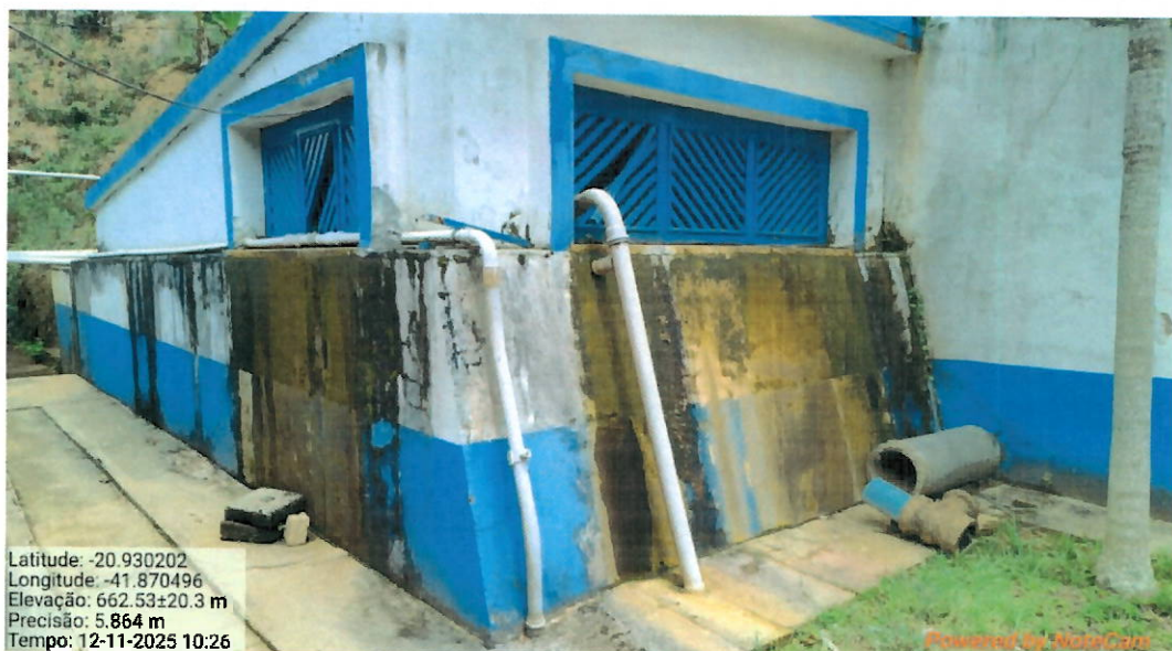
Foto 14: Vista externa do reservatório.
