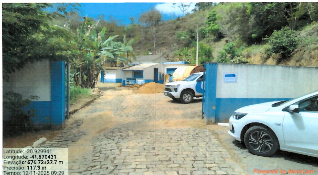
Foto 1: Fachada da ETA (note-se placa improvisada ao lado direito).
