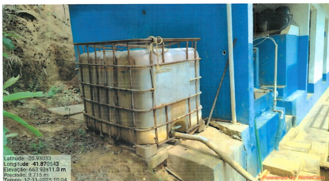
Foto 23: Sulfato de alumínio armazenado sem bacia de contenção, à céu aberto e sobre piso não impermeabilizado.
