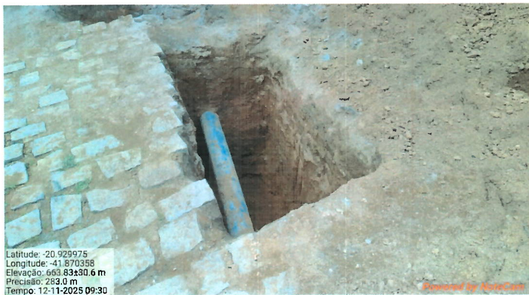
Foto 5: Tubulação DN 150 onde será instalado o macromedidor.
