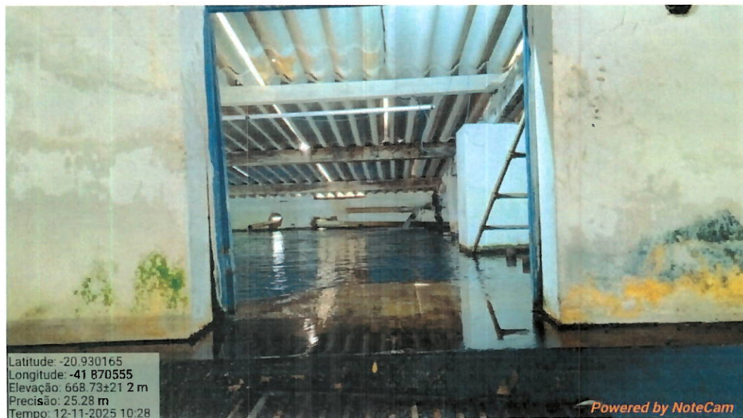
Foto 15: Vista interna do reservatório.
