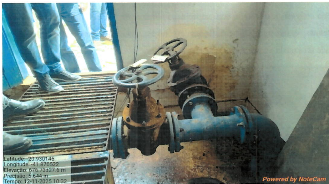
Foto 16: Ausência de vazamento de água (reparo realizado).
