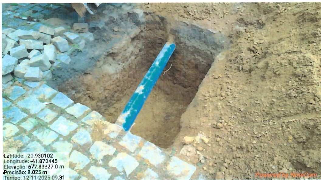
Foto 4: Tubulação DN 150 onde será instalado o macromedidor.
