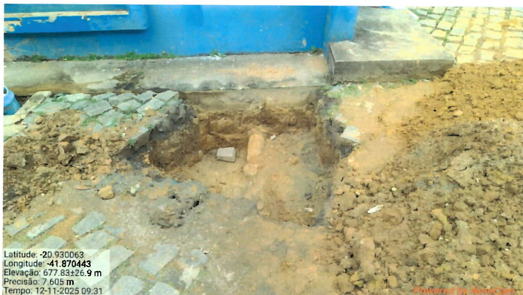
Foto 6: Tubulação DN 150 onde será instalado o macromedidor.
