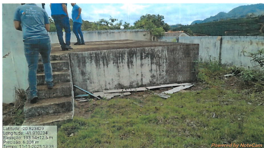
Foto 02 - Vista do reservatório semi-enterrado (capacidade 95.000 litros).
