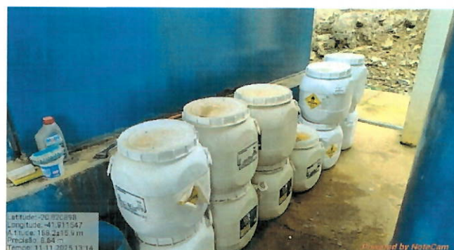
Foto 17 - armazenamento de pastilhas de hipoclorito.
