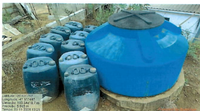
Foto 16 - tanque de sulfato de alumínio sem bacia de contenção.
