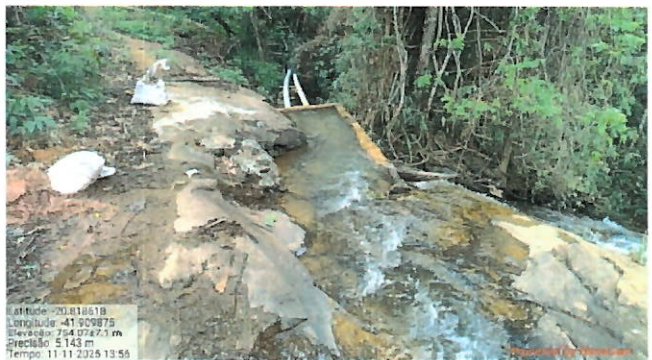
Foto 02 - barragem e tubulações
